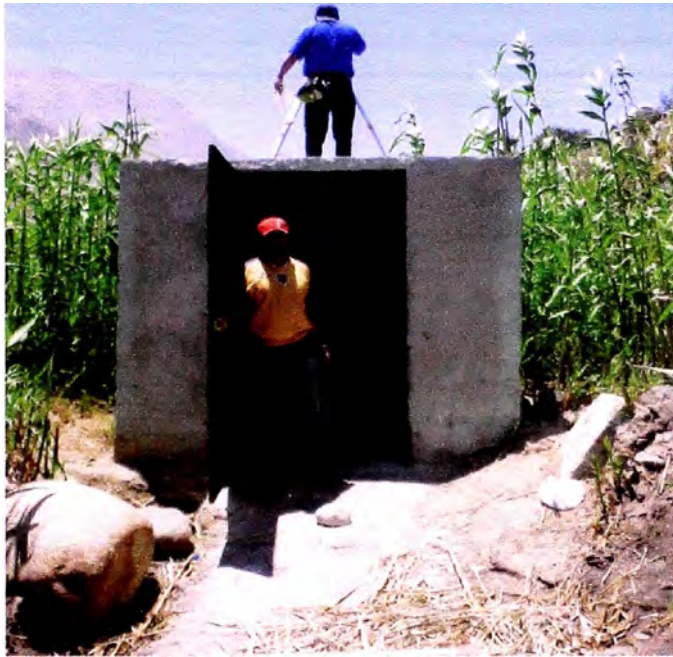
Foto 3.1: Evaluación de la Caseta de Captación e inicio del Levantamiento Topográfico
