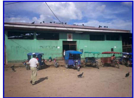
IMAGEN 2- Vista del frontis del Camal Municipal sin proyecto, en la cuadra 9 de la Av Castilla
