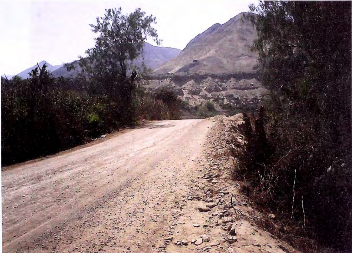
FOTO 07: INICIO DEL TRAMO 58+200, SE NOTA QUE SE HA PROTEGIDO LA LADERA CON CERCO VIVO A AMBOS LADOS DE LA VIA
