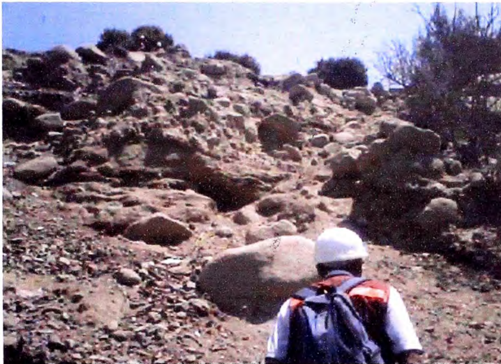
FOTO 03: SE OBSERVA LA GRAN VERTICALIDAD DE LA LADERA, NOTESE DONDE SE ENCUENTRA LA CARRETERA, EL PRECIPICIO ES DE APROXIMADAMENTE 50 M.
