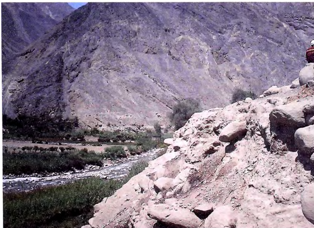
FOTO 06: SE OBSERVA EL RIO CAÑETE, EL TALUD EN EROSION Y EL PERSONAL DE TRABAJO QUE SE ENCUENTRA EN LA VIA
