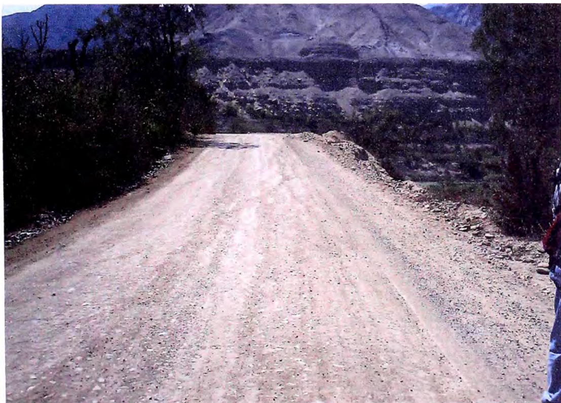
FOTO 08: SE NOTA QUE SOLO UN LADO DE LAVIA TODAVIA TIENE CERCO VIVO, LA OTRA PARTE YA ES PARTE DEL PRECIPICIO
