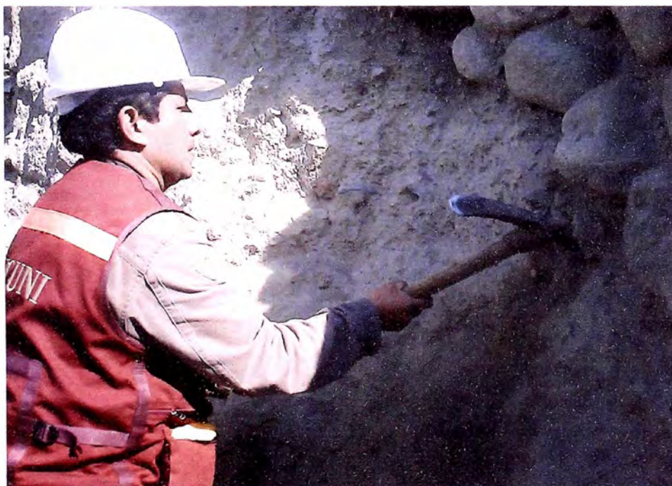
FOTO 04: EL TIPO DE SUELO PREDOMINANTE ES LIMOARCILLOSO COMO SE PUEDE APRECIAR, EXISTEN PIEDRAS GRANDES QUE ES PARTE DE LA PROTECCION DE LA CARRETERA EN EROSION
