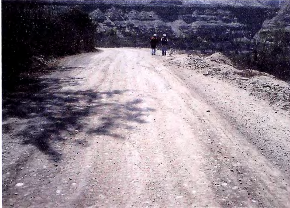
FOTO 09: EL CERCO VIVO CONTINUA EN LA LATERAL IZQUIERDO DONDE SE EXPROPIARA, AL OTRO LADO SE TRATA DE PROTEGER POR LA EROSION CON MATERIAL GRANULAR DE RELLENO
