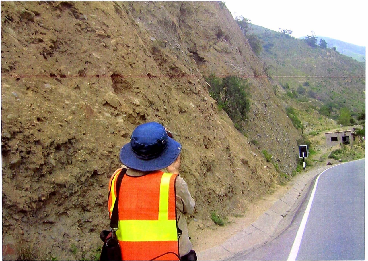
Km 69+450 Deposito aluvial midiendo pendiente del talud 70%
