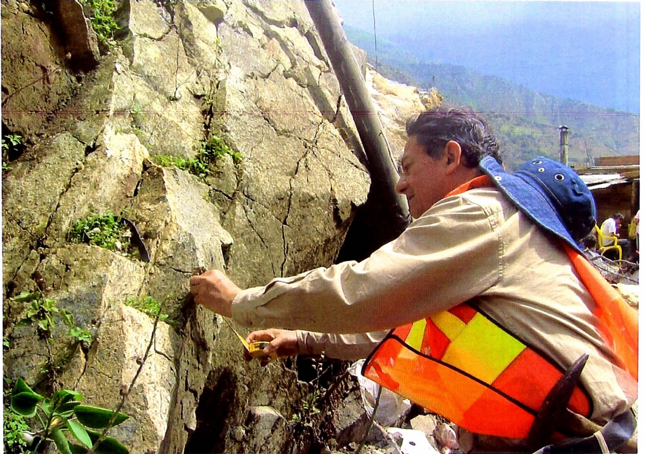
Km 68+250 Roca Intrusiva se aprecia distancia de fracturas de 30cm.
