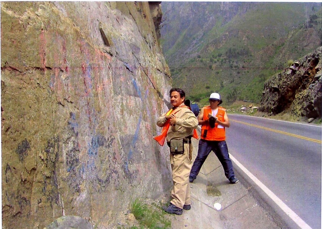
Km 67+800 Roca Intrusiva, pendiente de talud 80%
