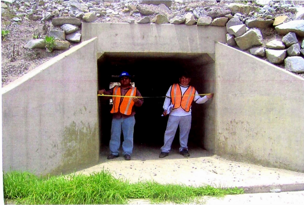
B.2.1 Alcantarilla en buen estado, Km. 67+380.
