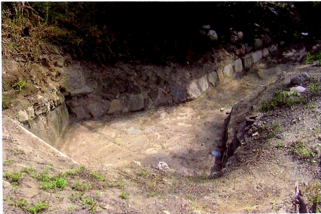
B.2.10 Salida canalizada con mampostería de piedra, Km. 68+913.
