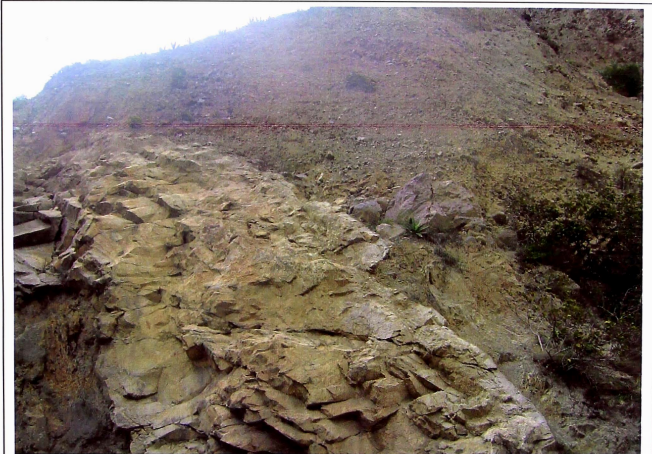
Km 68+500 Roca Intrusiva intemperizada con afloramiento de deposito aluvial.
