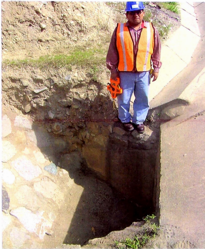
B.2.9 Ingreso limpio y en buen estado, Km. 68+913.
