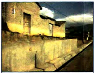
Al ampliar el ancho de vía de acuerdo a las especificaciones técnicas, se requirió el corte de talud pudiendo afectar la vivienda asentada sobre el, para lo cual el proyecto contempló la necesidad de construir un muro de contención como sistema de protección.
