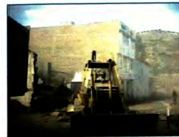
Demolición del muro frontal de la vivienda, requiriendo para el mejoramiento del alineamiento de la carretera, solicitando el propietario al Contratista, proceda a las actividades de demolición y eliminación del material de desmonte resultante.
