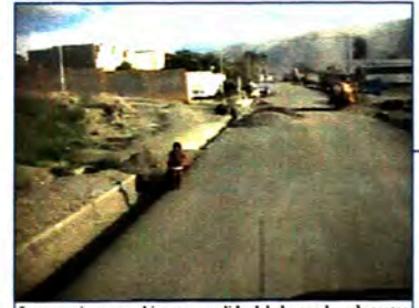
Interrupciones en el ingreso y salida del alumnado y docentes del Colegio Estatal Warivilca debido a las actividades de movimiento de tierra para la conformación de la plataforma y excavaciones de cunetas, durante la etapa constructiva.
