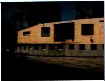
Debido al desnivel del ingreso de la vivienda mostrada en la vista y su ubicación en el tramo en curva de la vía, se podría producir accidentes de tránsito, viéndose perjudicada dicha vivienda, requiriendo la construcción de un muro de concreto para su protección.
