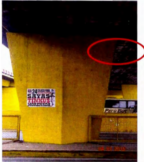
Figura 55.-Vista de una columna del puente Atocongo
