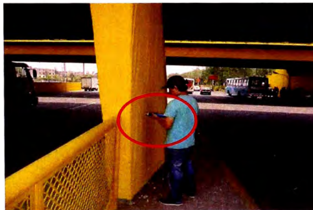
Figura 59.-Ensayo con esclerómetro en el punto 1.
