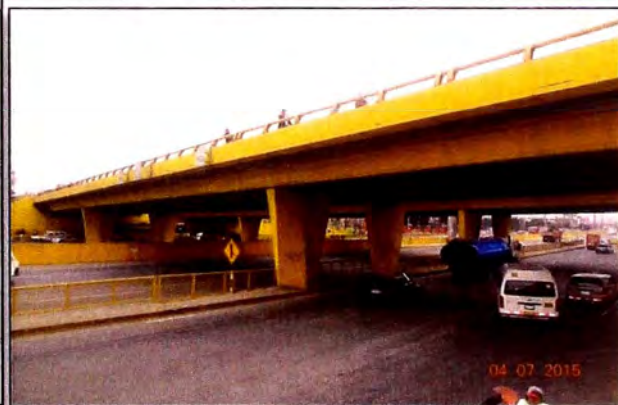
Vista de zona de trabajo
