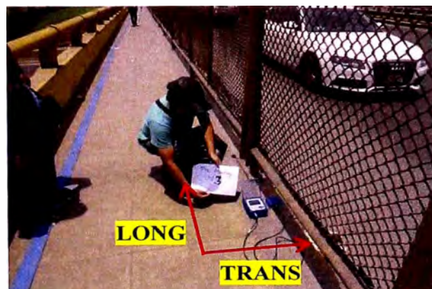
Figura 63.-Ensayo de medición de frecuencias estructurales en el puente Atocongo
