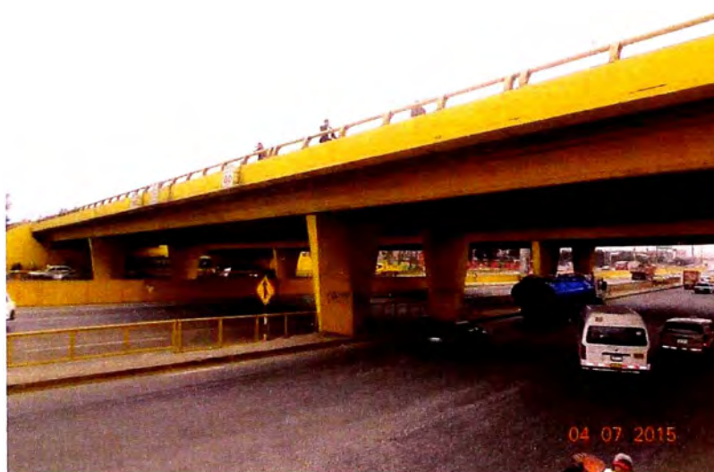
Figura 45.-Vista panorámica del puente Atocongo
