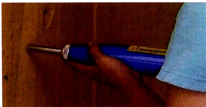
Figura 57.-Vista del ensayo de esclerometria.
