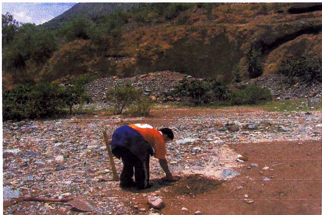
Km 69+850 Elección de un punto en la cantera San Juan para la excavación de la calicata
