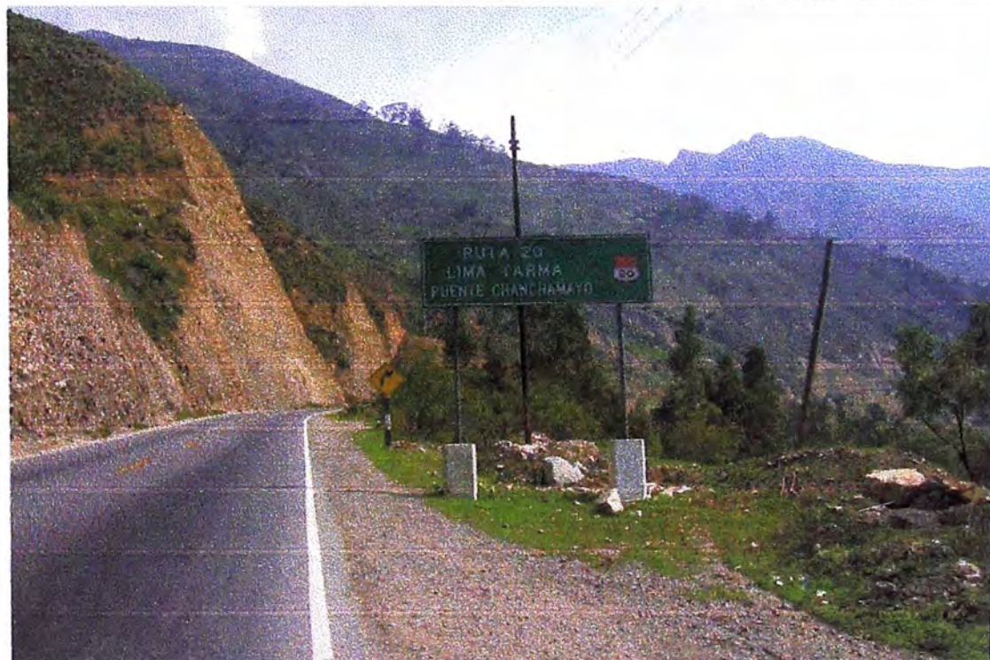
Condiciones actuales de la carretera Cocachacra - Matucana
