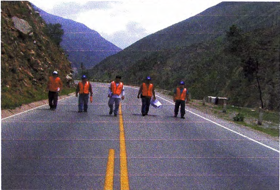
Grupo N° 08 evaluando de las condiciones actuales del pavimento en el tramo Km 67 al Km 70 de la carretera Cocachacra – Matucana.
