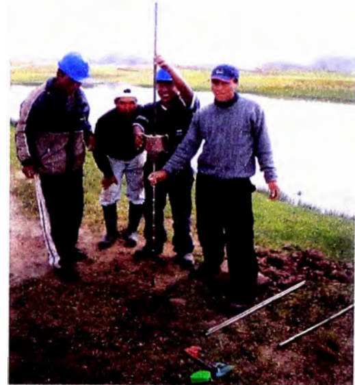
Foto 2: Ensayo PDC ubicado en la progresiva 41+180 lado izquierdo
