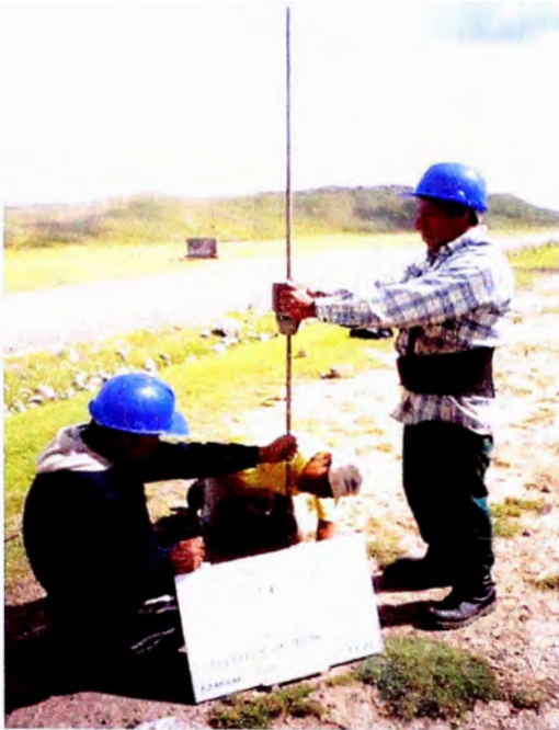
Foto 1: Ensayo PDC ubicado en la progresiva 39+680 lado izquierdo
