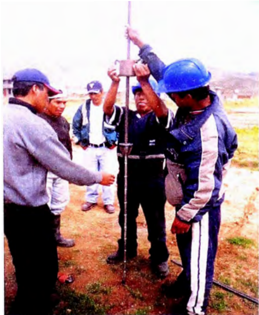
Foto 3: Ensayo PDC ubicado en la progresiva 43+680 lado izquierdo
