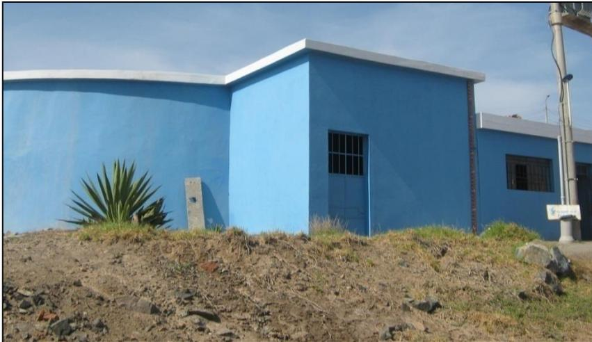
Este reservorio tiene una capacidad de 1650m<sup>3</sup> y una antigüedad aproximada de más de 56 años, las estructuras se encuentran en buen estado de conservación. A partir de este reservorio se abastece de agua potable a la ciudad de Matarani por medio de dos líneas de conducción de diámetros de DN200mm y DN250mm de AC; también, se abastece a los reservorios R-4 y R-5 a través de un sistema de impulsión.
