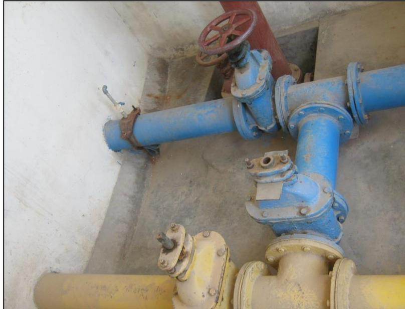
Estos dos reservorios por medio de una línea de aducción de DN200mm de fierro fundido abastecen a su área de influencia. Ambos reservorios tienen macromedidores pero solo del reservorio R-2A está operativo.
