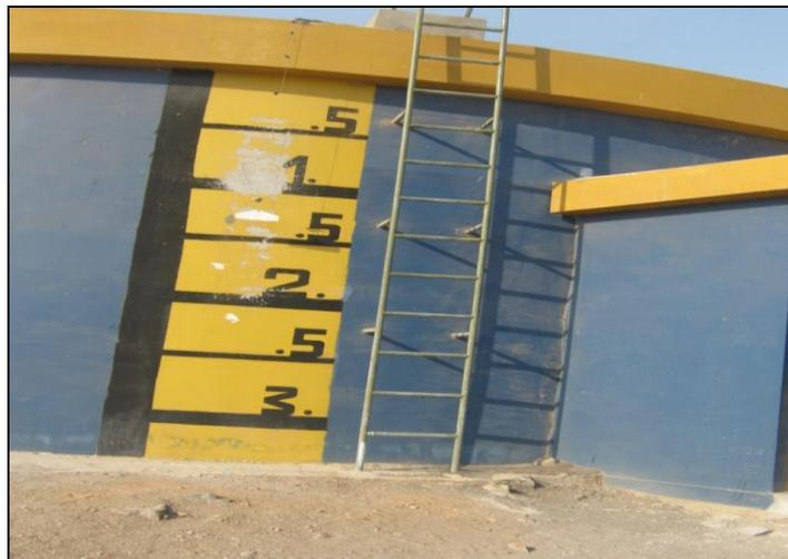
El reservorio tiene una antigüedad de 11 años; tanto sus estructuras como la parte hidráulica se encuentran en buen estado de conservación. El reservorio no cuenta con cerco perimétrico ni suministro eléctrico.
