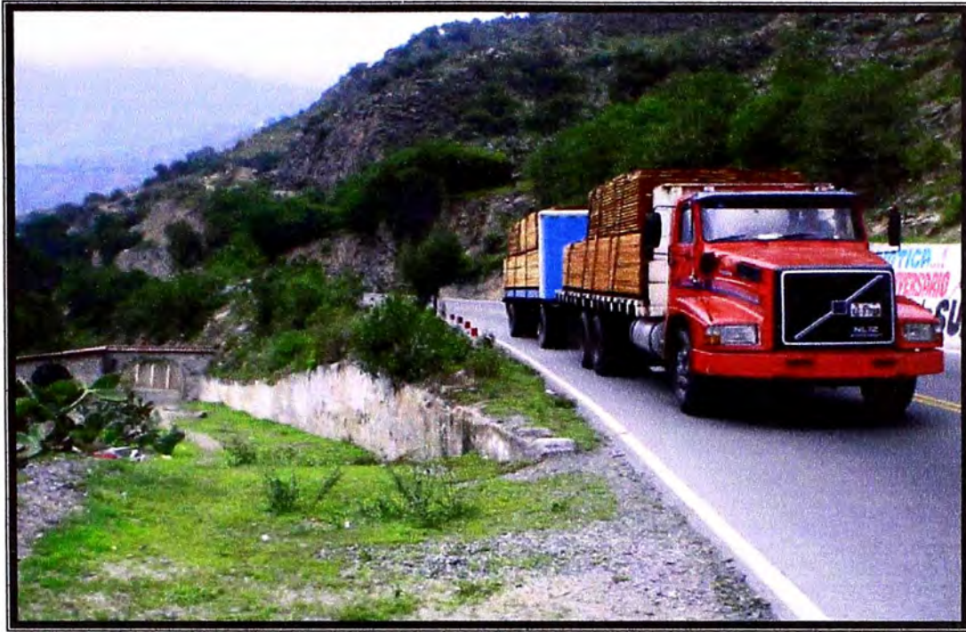
FOTO N° 07. -Muro de sostenimiento del terraplén que conforma la estructura del pavimento de altura variable y 54.00 m de longitud.
