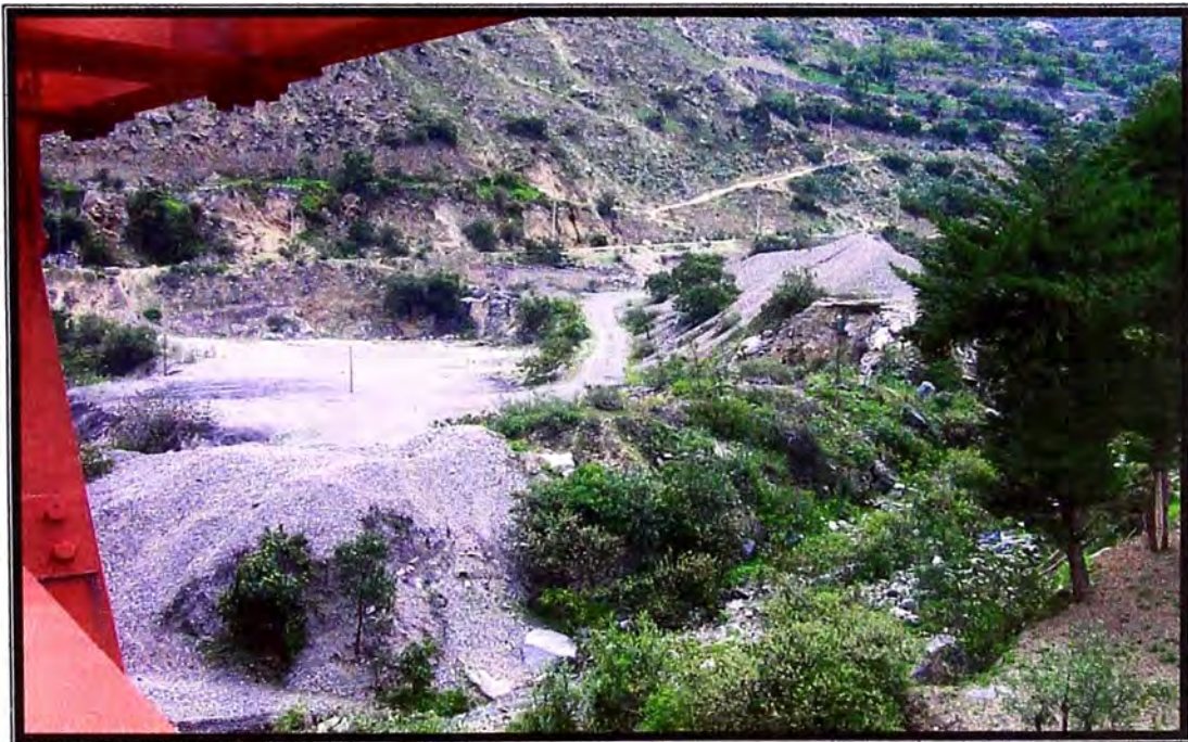
FOTO N° 12. -Cantera San Juan, ubicado en el Km. 69+860 de la carretera Cocachacra-Matucana.
