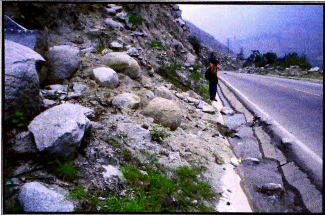
FOTO N° 05.- Material pétreo anguloso y material fino como el limo y la arcilla, cuya composición es estable, pero es sensible a los cambios de temperatura.
