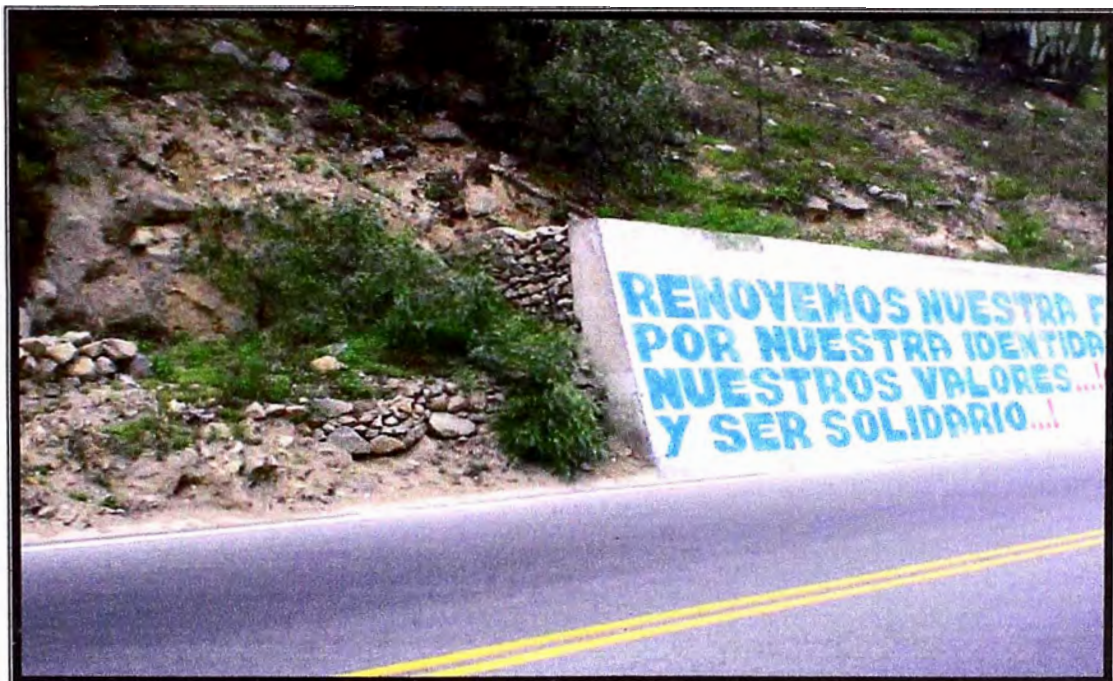
FOTO N° 06.- Muro de contención de concreto armado, de altura variable y 60.00 m de longitud se encuentra estabilizando el talud, evitando desprendimientos y deslizamientos del material.
