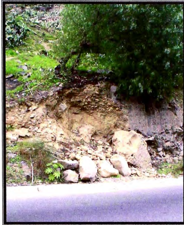
FOTO N° 13.-Material fino que en presencia del agua tiende a aumentar su volumen, generando derrumbes
