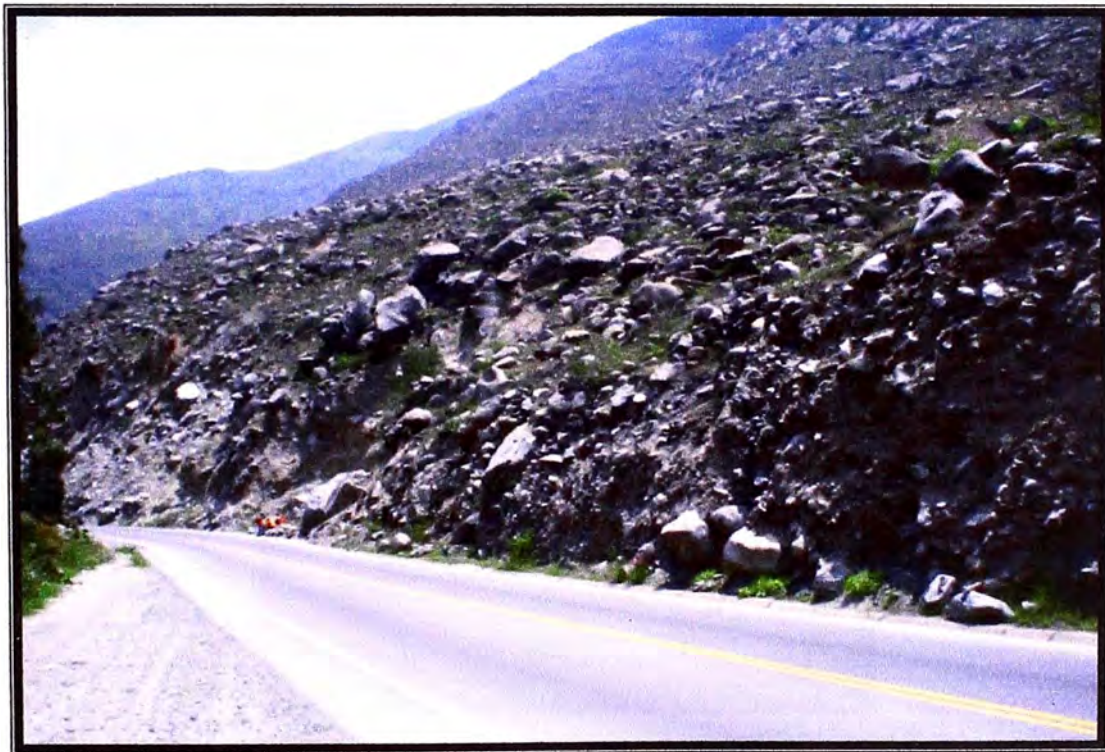
FOTO N° 02.- Material aluvio – coluvial, presencia de material fino y material grueso que varía su diámetro desde los 0.10 m a 1.50 m.
