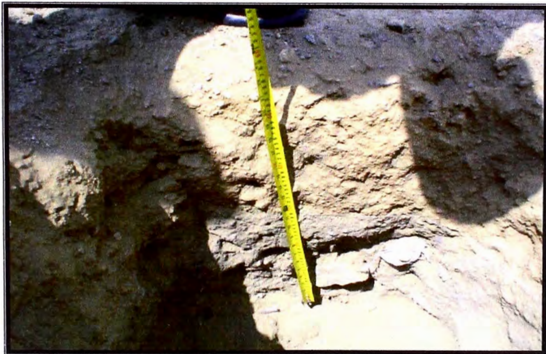
FOTO N° 10. -En la calicata realizada en la berma de la carretera, se puede observar la presencia de tres estratos siendo ellos de composición fina y cambiando sus tonalidades desde amarillo claro hasta grisáceo.
