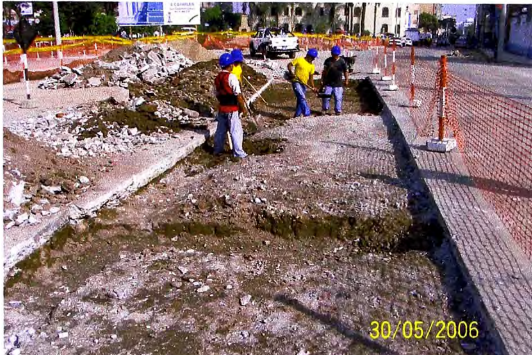
FOTO 7 : EXCAVACION DE PARCHE LOCALIZADO PROFUNDO EN LA OBRA REHABILITACION DE LA AV. ARENALES JUNIO 2006
