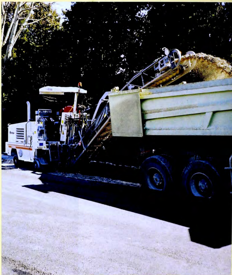
La máquina W 1000 L va fresando la capa de firme rápida y profundamente. El ajuste de la profundidad de fresado garantiza en este caso un resultado de trabajo parejo.
