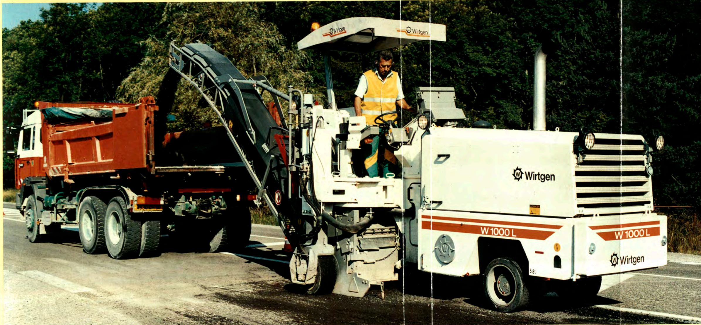
Saneamiento de superficies con la fresadora W 1000 L: El rodillo de fresado se acciona mecánicamente, con gran eficiencia. En consecuencia, se logra un avance óptimo con un alto rendimiento diario.
