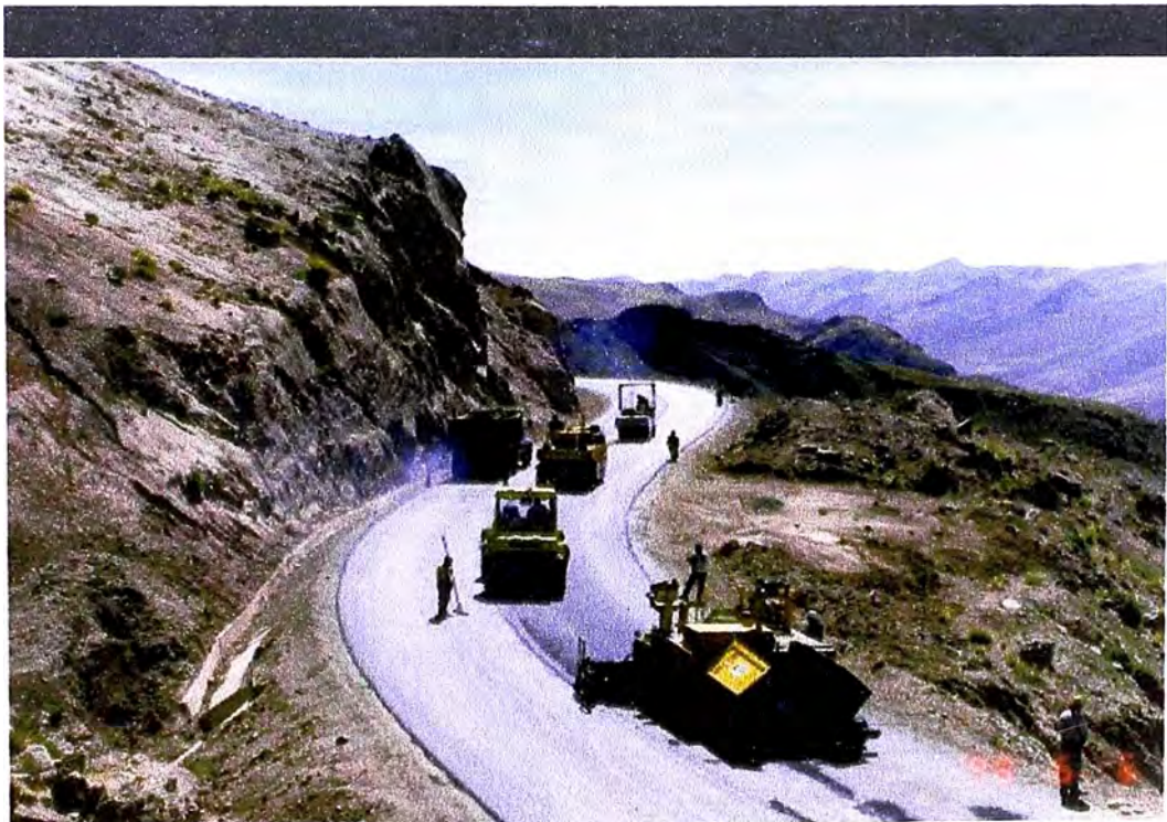
FOTO 16 : COLOCACION DE CARPETA ASAFLATICA CARRETERA PISCO AYACUCHO
