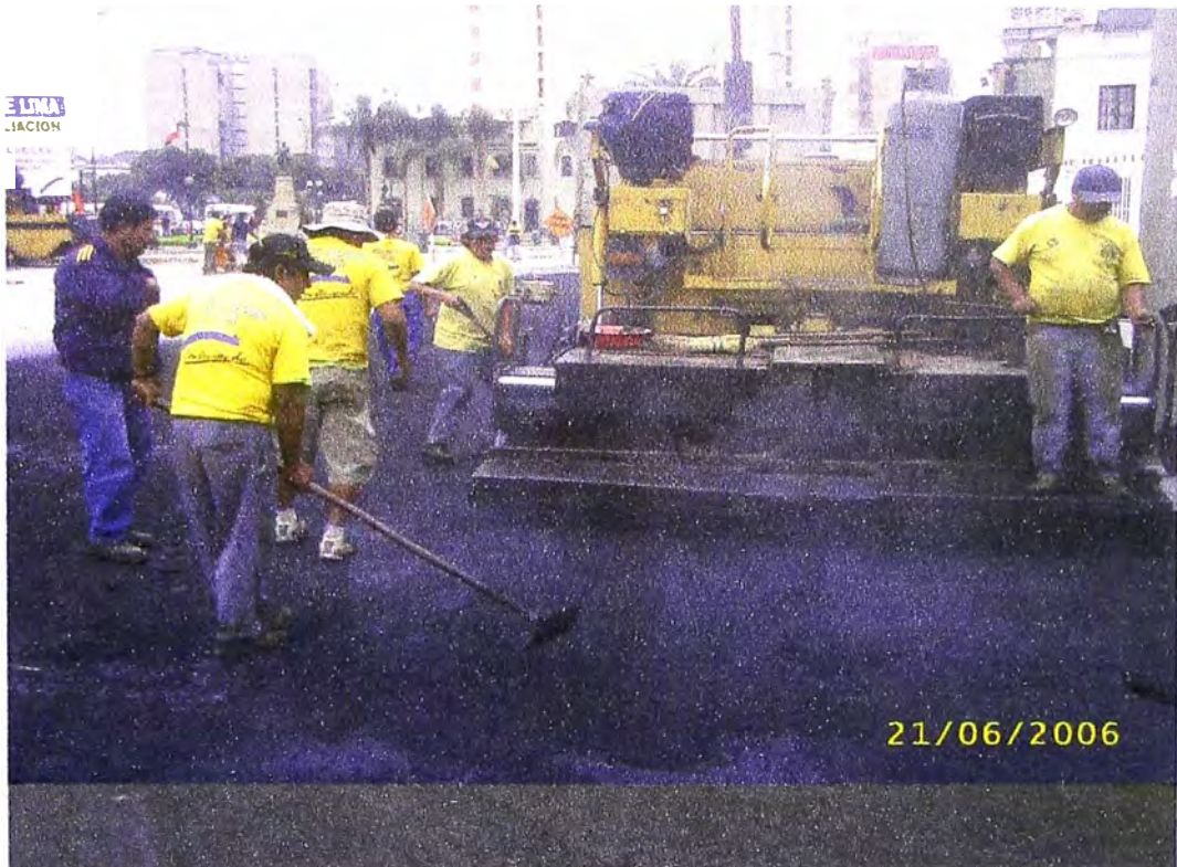
FOTO 15 : COLOCACION DE CARPETA ASFALTICA EN LA OBRA REHABILITACION DE LA AV. ARENALES
