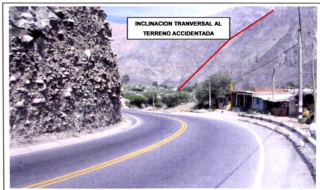
FOTO 2.1 CONDICION OROGRAFICA INCLINACION TRANSVERSAL DEL TERRENO NORMAL AL EJE DE LA VIA MAYOR DE 45° POR LO QUE SE PUEDE DECIR QUE PRESENTA UNA OROGRAFÍA MUY ACCIDENTADA TIPO 4
