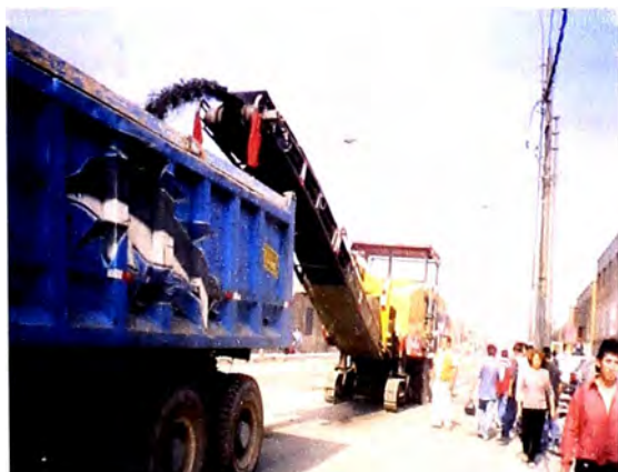
FOTO 3.1 FRESADO DE LA CARPETA ASFALTICA EXISTENTE EN LAS CALLES TRANSVERSALES A LA AV. GRAU – CERCADO DE LIMA JUNIO – 2006
