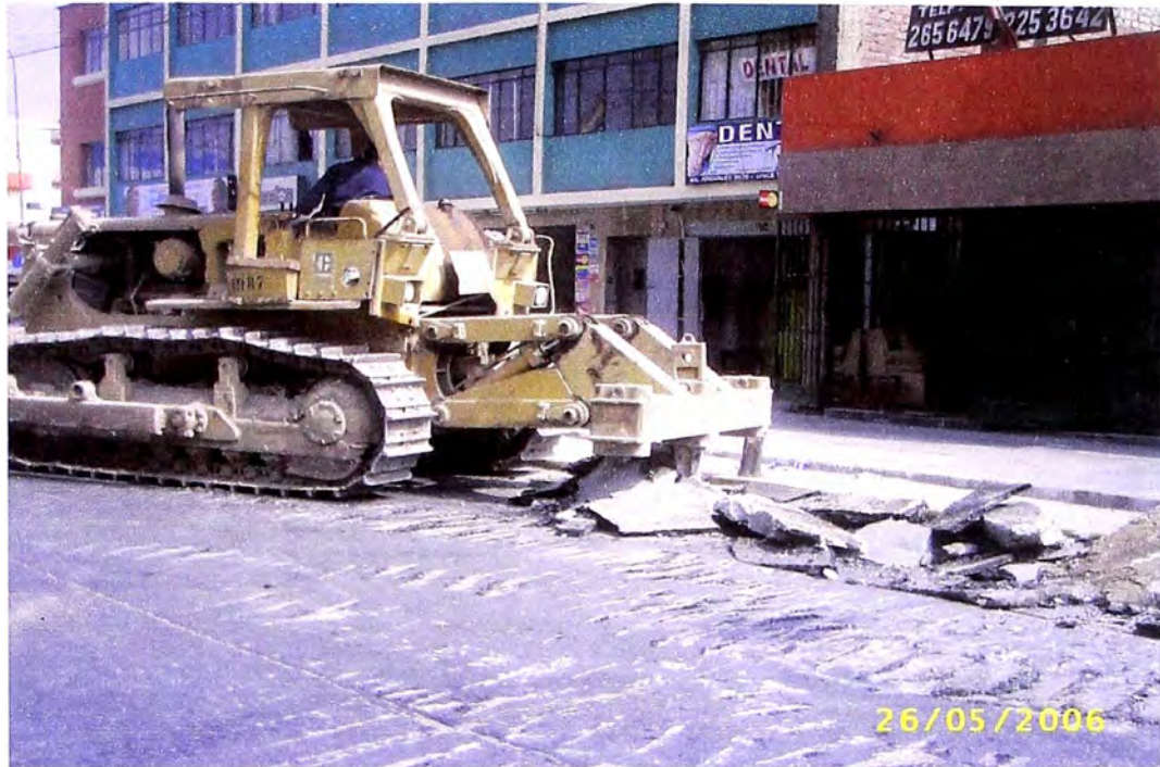
FOTO 5 Y 6 : RETIRO DE LA CARPETA ASFALTICA DETERIORADA POR MEDIO DEL TRACTOR SOBRE ORUGAS EN LA OBRA REHABILITACION DE LA AV. ARENALES MAYO 2006
