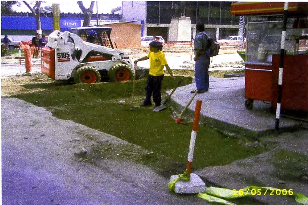
FOTO 9 Y 10 : EXTENDIDO DEL MATERIAL AFIRMADO PARA BASE
