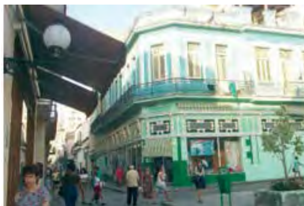
Recuperación de fachada en Ca. Obispo
