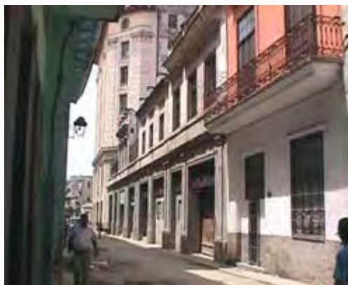
Recuperación de vivienda Mz. 148
