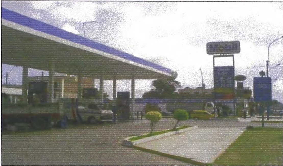
Ilustración A.8: Grifo Mobil, esq Av. Guardia Civil cdra 7 y Av. El Sol
