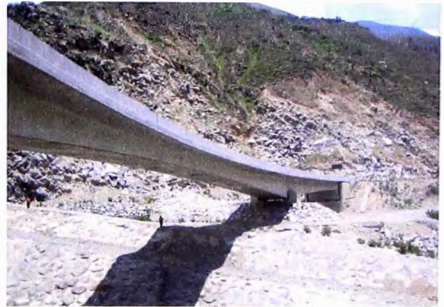
Foto 26. Progresiva Km 71+600. Estrido Derecho del Puente Collana.
