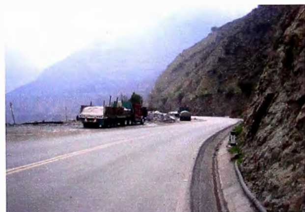
Foto 17. Progresiva Km 70+900. (Vista Atrás)
