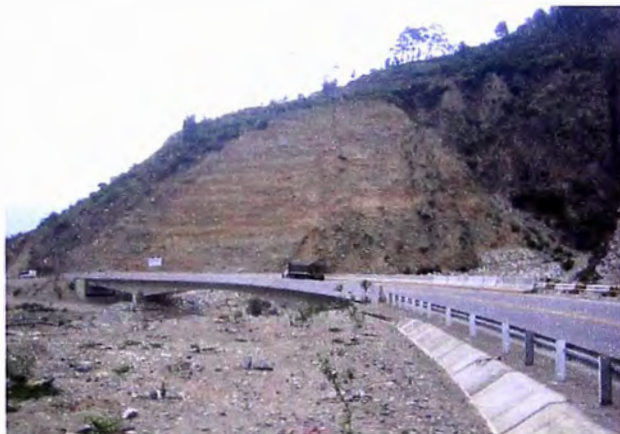
Foto 27. Progresiva Km 71+760. Banqueo de Talud (Vista Atrás)
