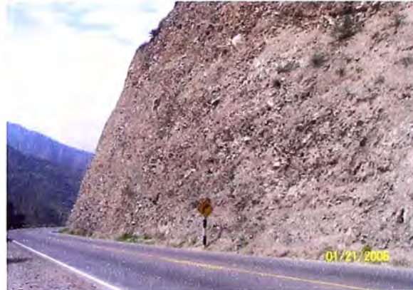
Foto 4. Progresiva Km 69+200 (Vista Atrás).
