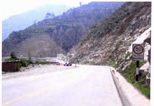
Foto 28. Progresiva Km 71+830 (Vista Atrás)
