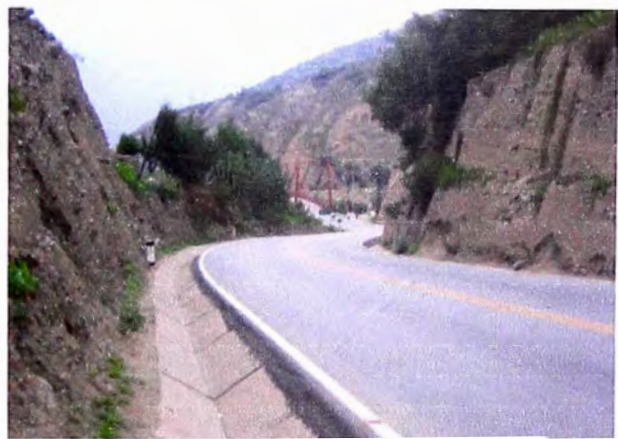
Foto 10. Progresiva Km 70+020 (Vista Atrás)
