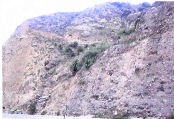
Foto 6. Progresiva Km 69+570 (Vista Atrás).
