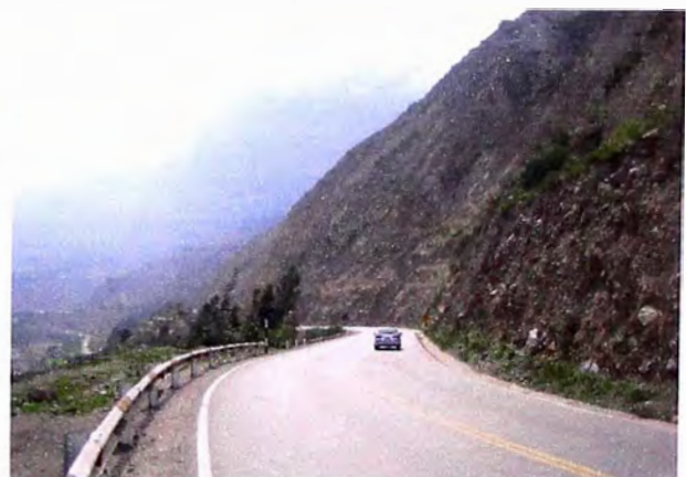
Foto 22. Progresiva Km 71+300. (Vista Atrás)
