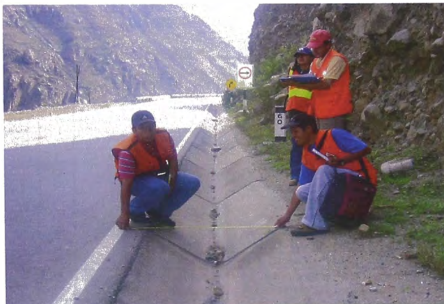
Foto 5-36 - Cuneta ubicada entre las progresivas Km. 59+807 y Km. 60+000. Como se aprecia se encuentra limpia y en buen estado de conservación. Las dimensiones típicas son de 0,60 m de ancho superficial, 0,40 m de tirante y talud Z=0,75 .
