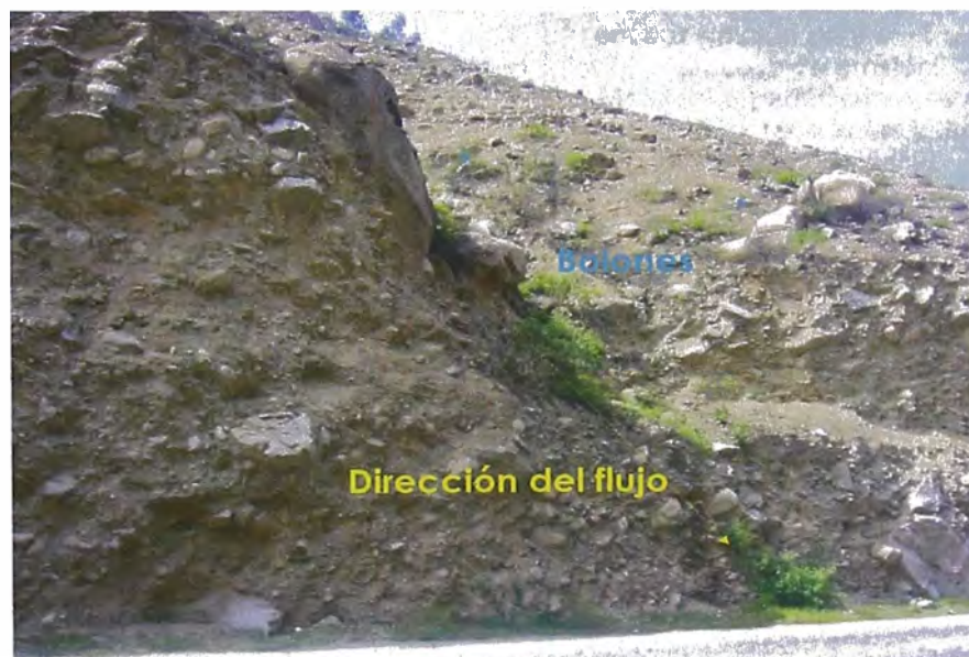
Foto 4-01 - Talud inestable ubicado en el Km. 59+850. Se aprecia claramente la formación de la cárcava.
