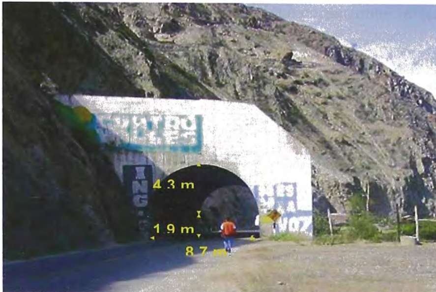
Foto N° 1-02.- Falso túnel (Km. 58+670)
