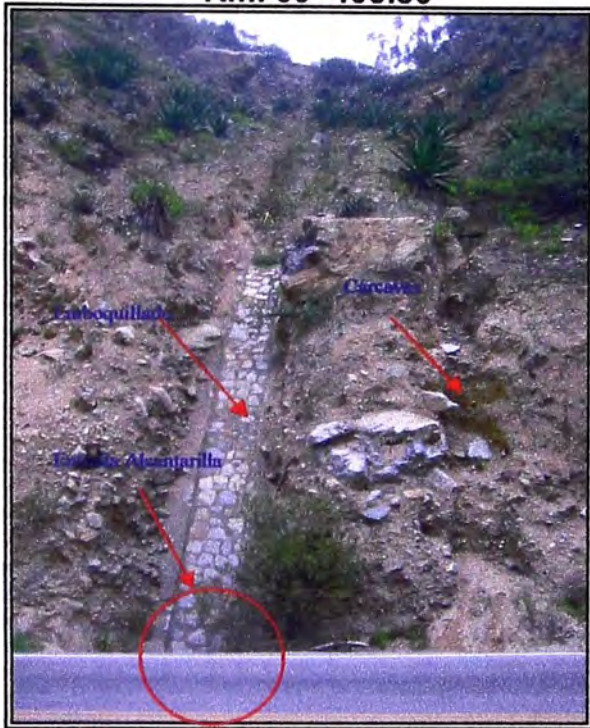
Alcantarilla N° 03 Km. 69+408.80
