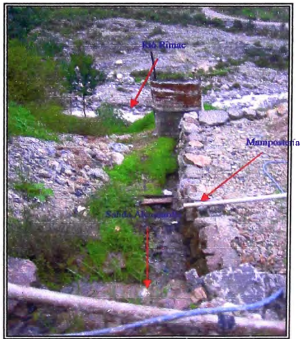
Alcantarilla N° 11 Km. 71+160.00
