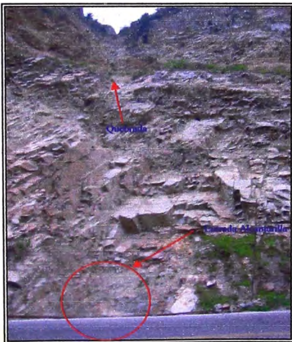
Alcantarilla N° 11 Km. 71+160.00
