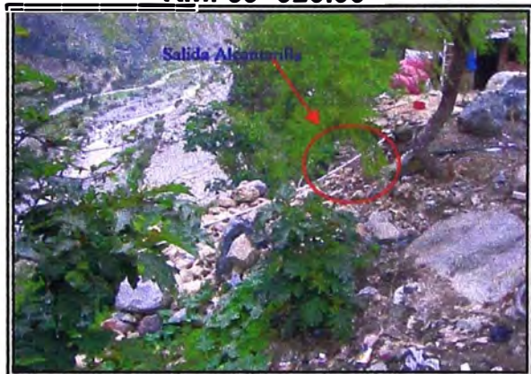
La salida ha sufrido modificaciones por los mismos pobladores, encontrándose enterrado con relleno.
