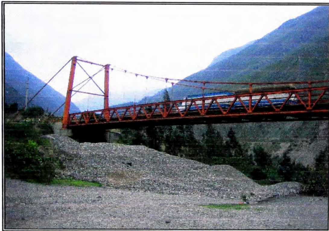
Foto N° 01 Puente Eduardo de Habich
