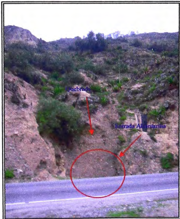
Alcantarilla N° 06 Km. 70+316.40
