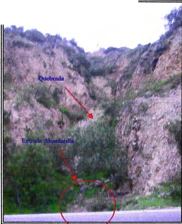
Alcantarilla N° 05 Km. 70+195.00
