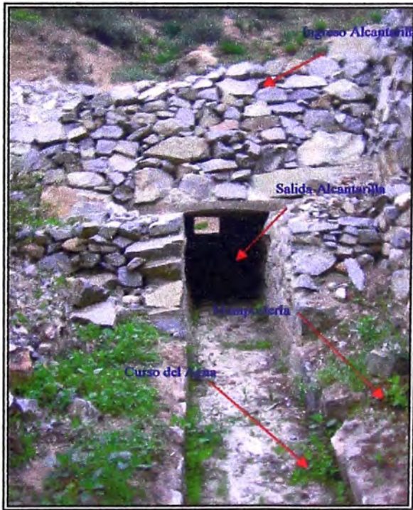
Alcantarilla N° 06 Km. 70+316.40
