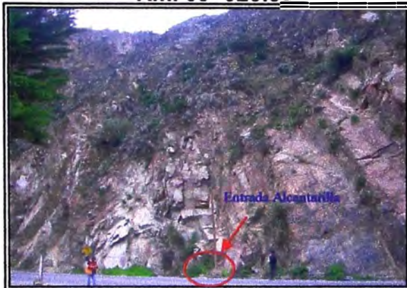
El ingreso se ve interrumpido por tubería Provisionales
