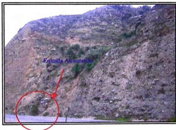
Alcantarilla N° 04 Km. 69+530.50
