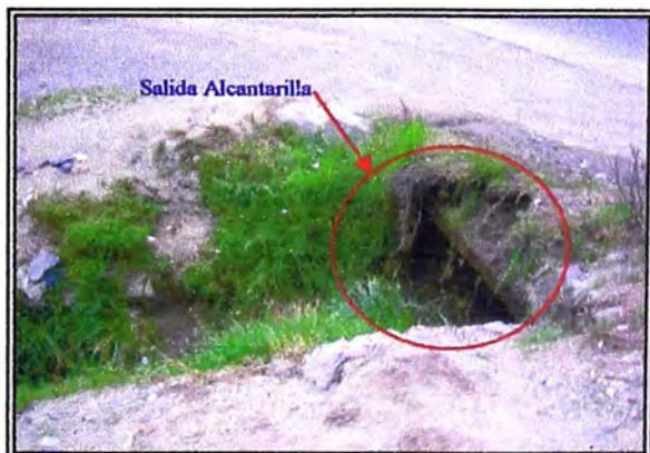
Alcantarilla N° 04 Km. 69+530.50
