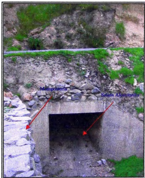
Alcantarilla N° 07 Km. 70+347.60
