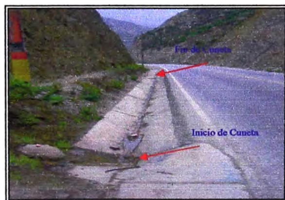
Foto N° 04 Cuneta Triangular en Sección Cajón
