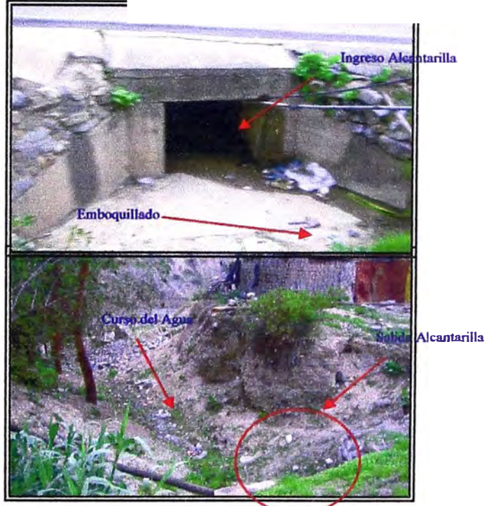
Alcantarilla N° 05 Km. 70+195.00
