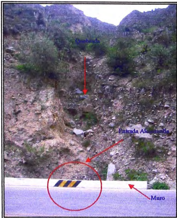
Alcantarilla N° 10 Km. 70+937.50
