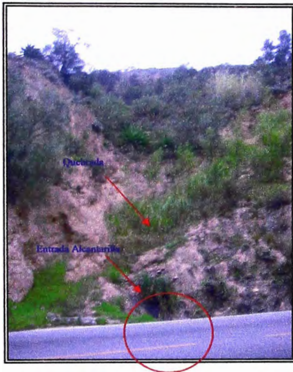
Alcantarilla N° 07 Km. 70+347.60
