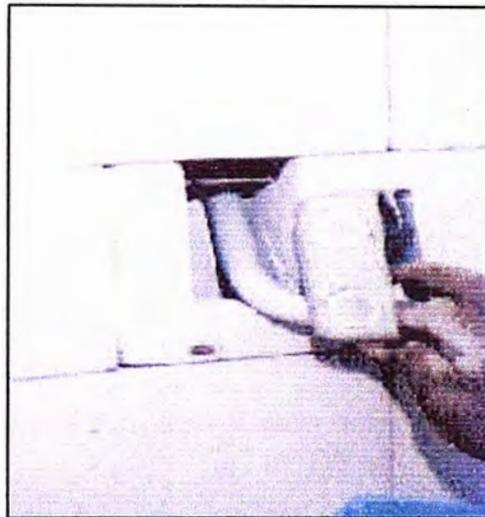
**Figura N° 3.05:** Bloques que alojan las cajas de las Instalaciones Eléctricas.
