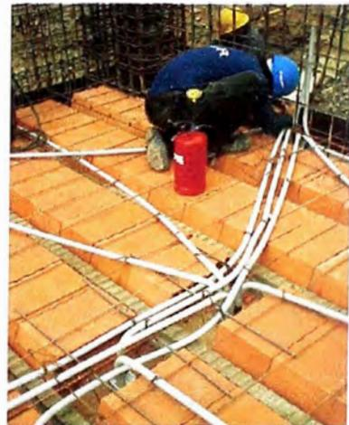
Se debe usar malla de temperatura en doble sentido cuando las luces exceden los 5.00 m y en las azoteas. Las instalaciones eléctricas se colocan como en un aligerado convencional.
