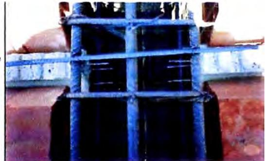
Para esto se deja una huella en la sección A-A con un cincel de punta plana de  $\varnothing 1/2"$  y luego se quita el concreto con una comba (zona de cables vistos)
