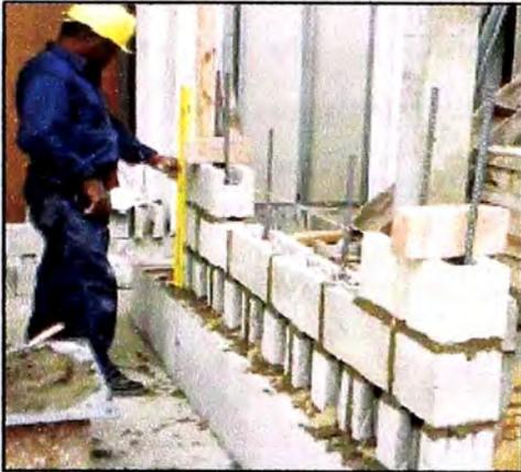
Verificación del aplomo del muro durante su asentado.
