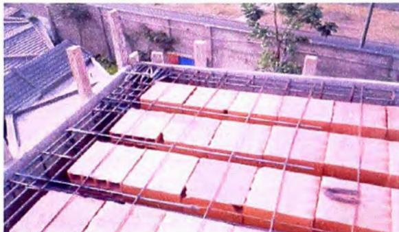
El acero negativo es el mismo que se calcula para una losa aligerada convencional (espaciado a 40 cm), con la diferencia que el espaciamiento ahora es de 50 cm (sobre c/ vigueta pretensada).
