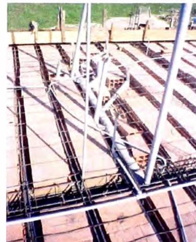
En caso de que la tubería tenga que atravesar la vigueta, ésta se podrá picar hasta 5 cm. (máx) como se ve en la figura.
