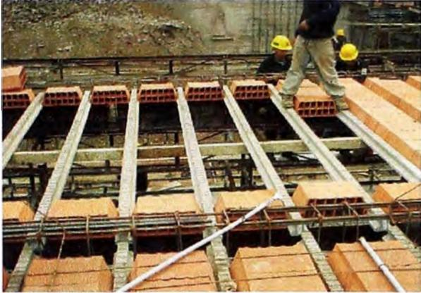
Colocar las bovedillas en los extremos como elementos distanciadores de las viguetas.
