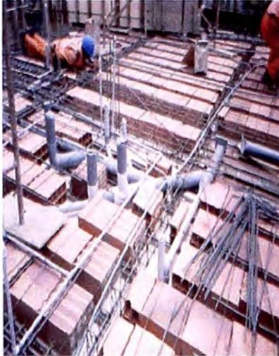
Tubería de desagüe, atravesando las viguetas pretensadas.
