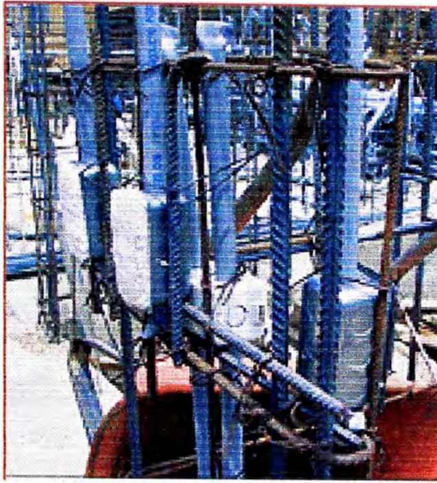
Fig. 1.28 - Saturación de tuberías y refuerzo
