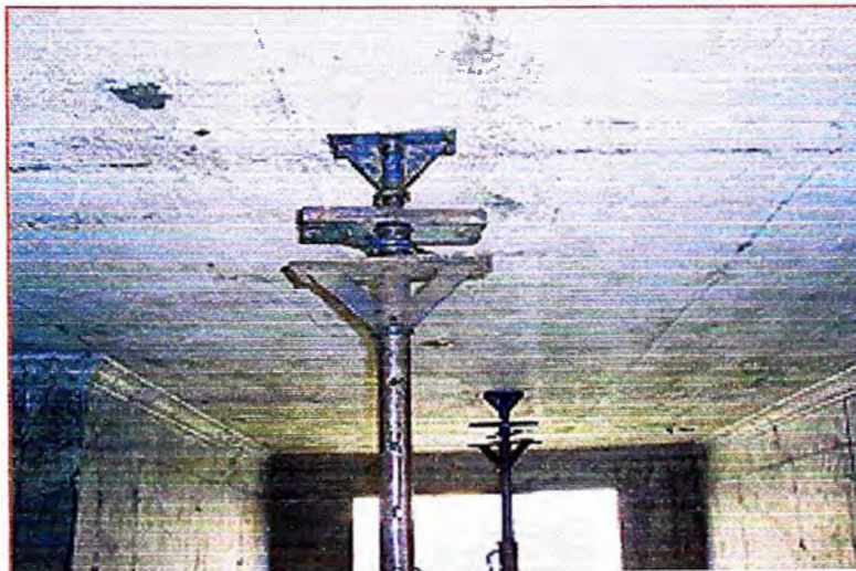
Fig. 1.16 - La losa se desencofra al día siguiente dejándola apuntalada
