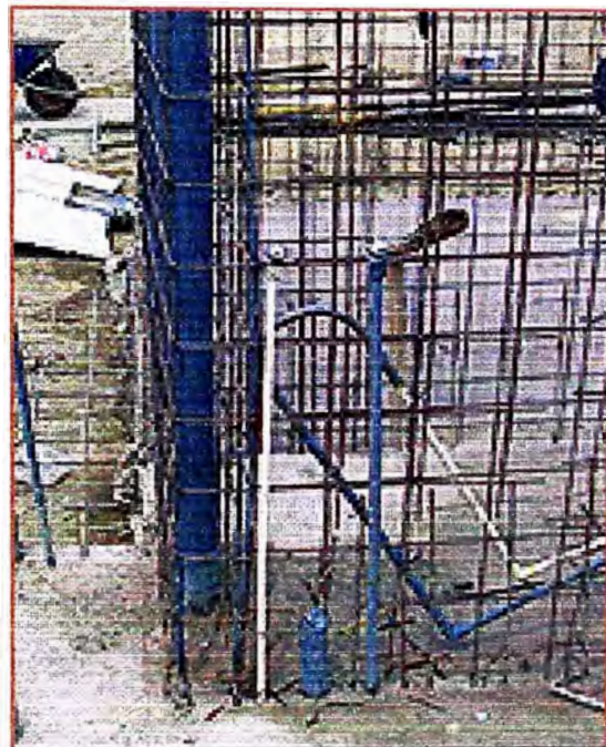
Fig. 1.29 - Ensanche de muro para paso de Montante
