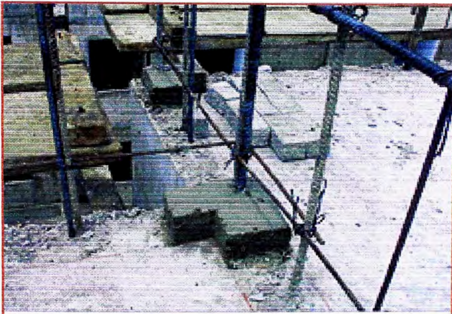
Fig. 1.40 - Dados de concreto para facilitar la colocación del encofrado
