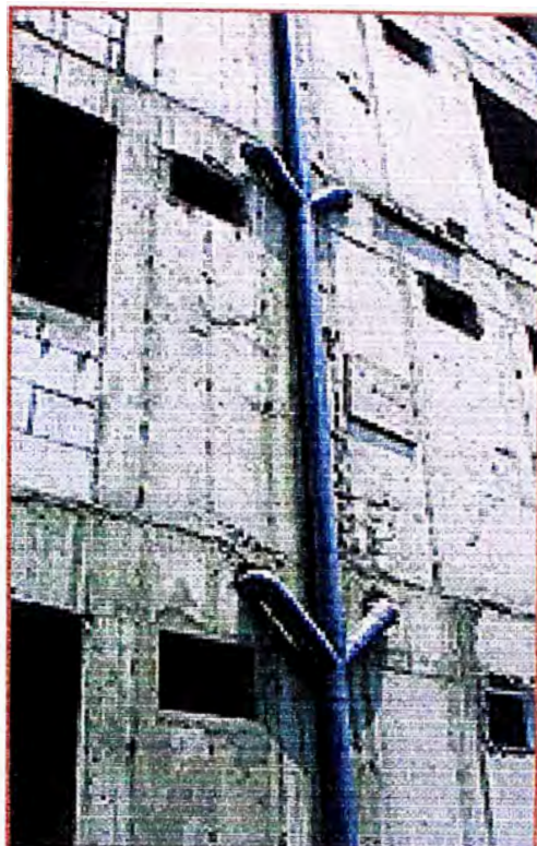
Fig. 1.26 - Paso de montantes por afuera del edificio
