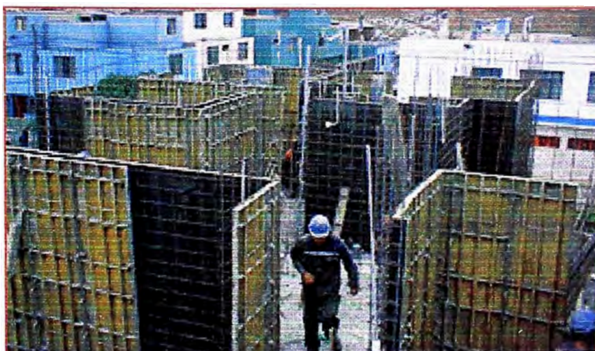
Fig. 1.38 - Disposición y encofrado de muros
