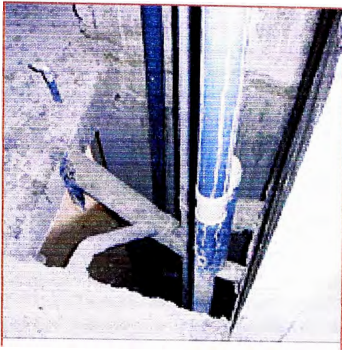
Fig. 1.32 - Uso de Ducto para Montantes
