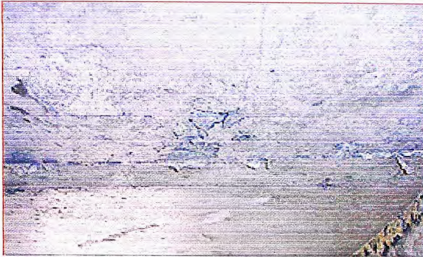
Fig. 1.20 - Cangrejas en Losa
