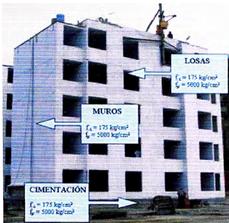
Fig. 1.1 - Edificio de Muros dúctiles
