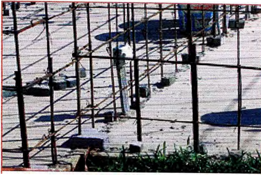
Fig. 1.41 - Dados de concreto para facilitar la colocación del encofrado
