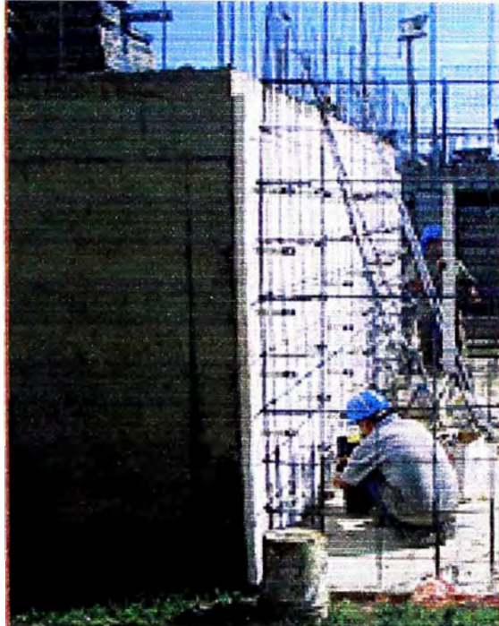
Fig. 1.22 - Junta entre bloques de un edificio
