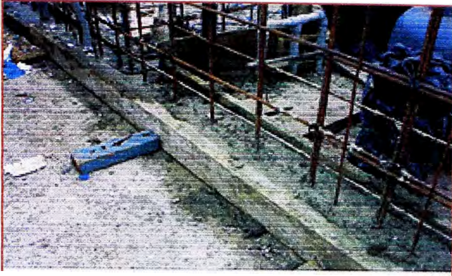
Fig. 1.39 - Tratamiento previo para facilitar la colocación del encofrado
