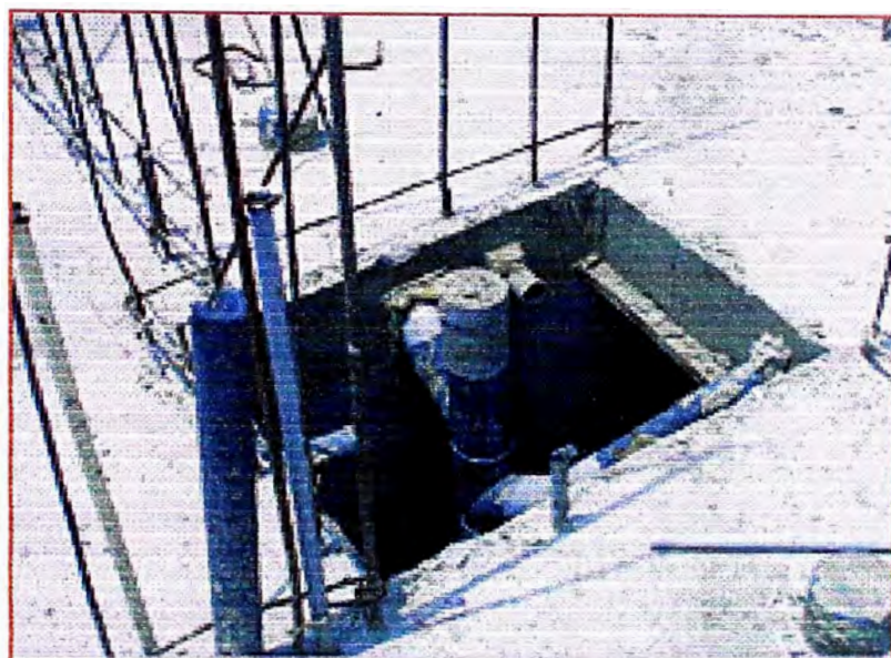
Fig. 1.31 - Uso de Ducto para Montantes
