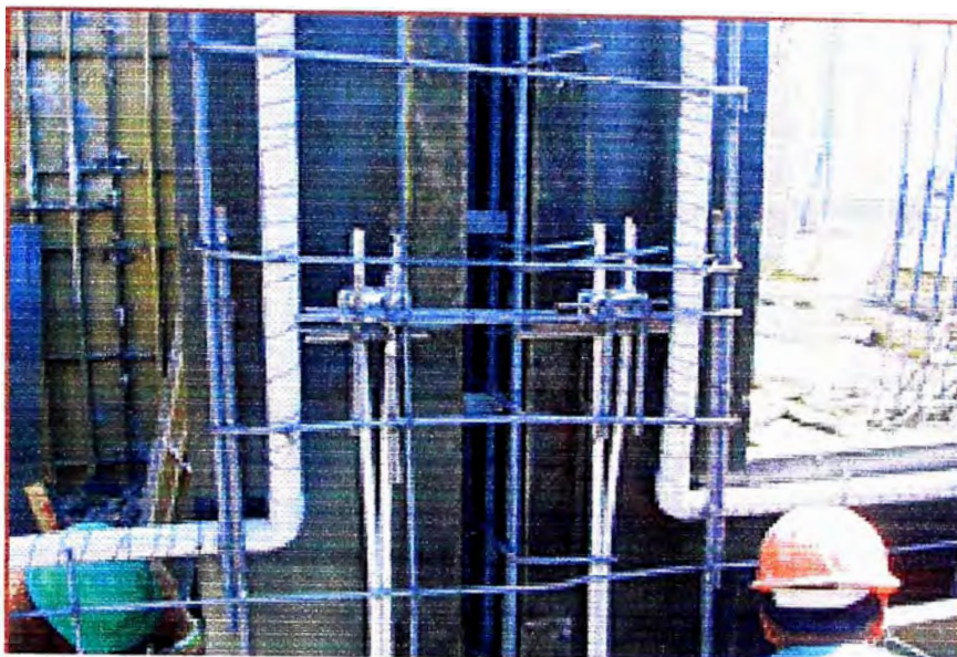
Fig. 1.30 - Saturación de refuerzo para fijar tomacorrientes
