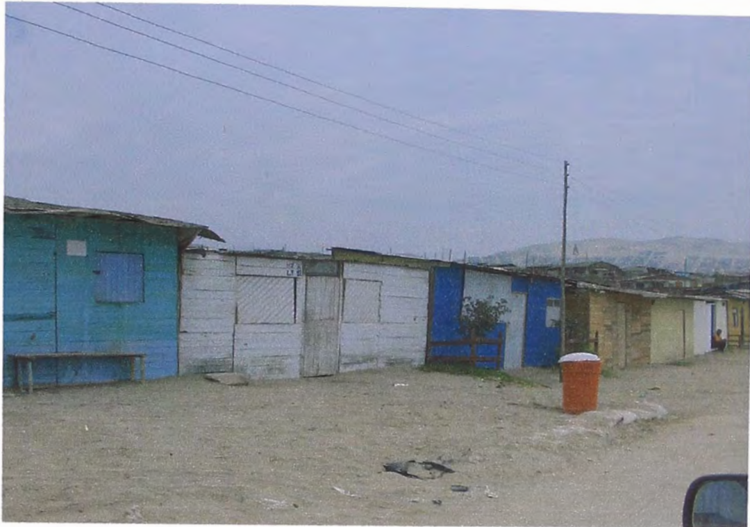
Fig. 11: Material empleado en la construcción de viviendas
