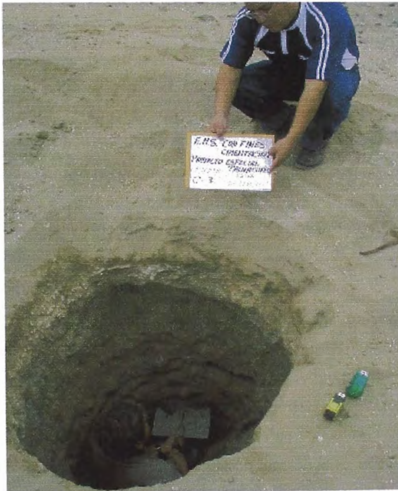
Fig.4: Ubicación de calicata C-3, se observa la capa superficial de caliche de baja compactación.
