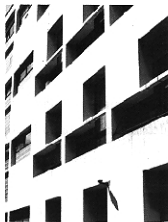
Fig. 32. Detalle de fachadas.
