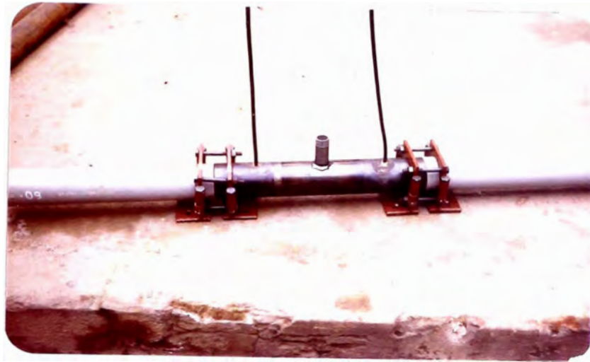
Instalación de la probeta de corrosión en el sistema de tuberías
