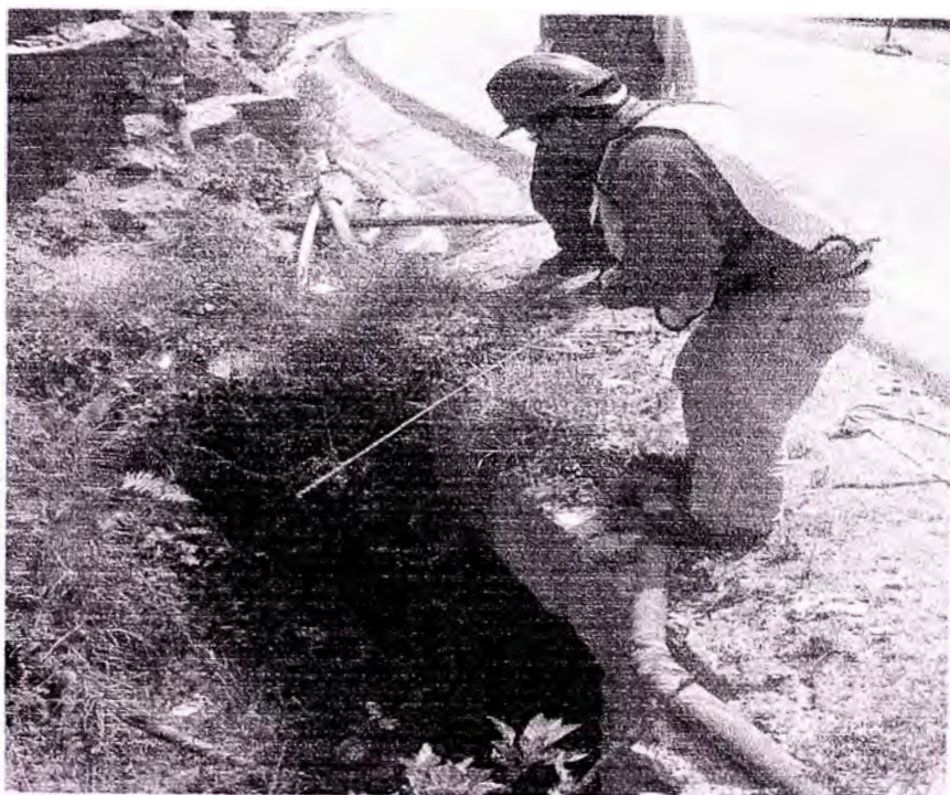
Foto No 04: km 67+580 Alcantarilla No 04
