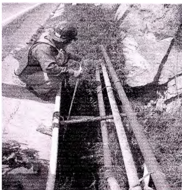
Foto No 10: km 69+100 Alcantarilla No 10
