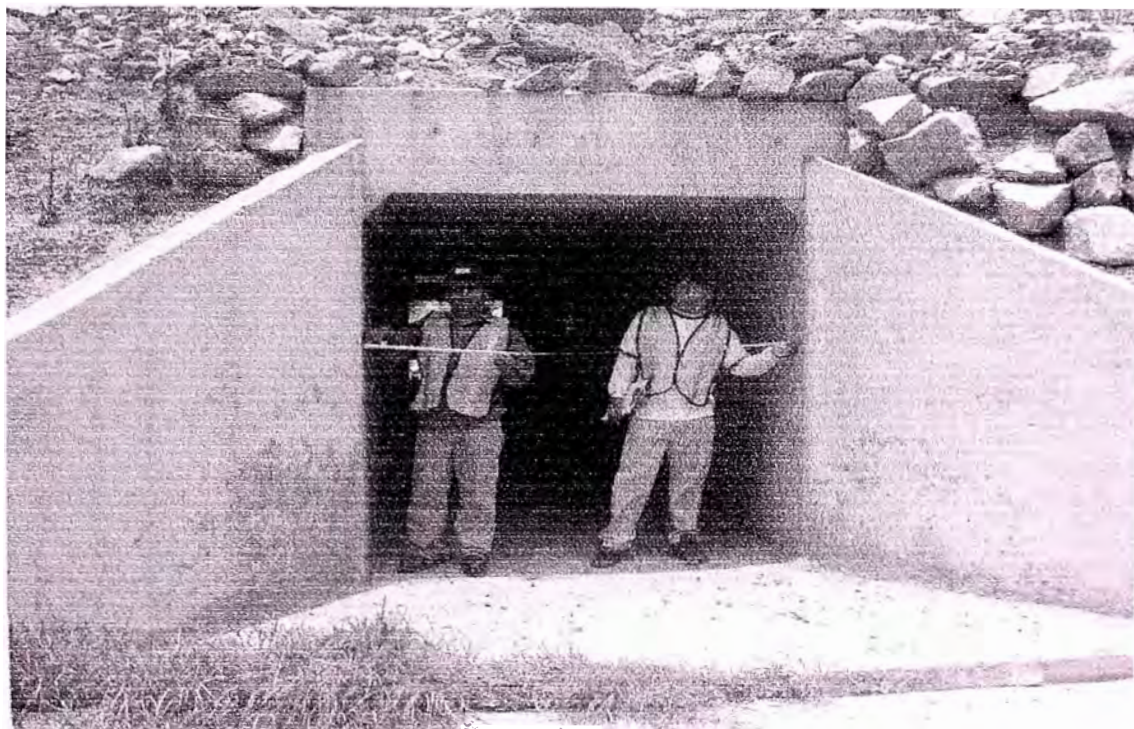
Foto No 02: km 67+324 Alcantarilla No 02
