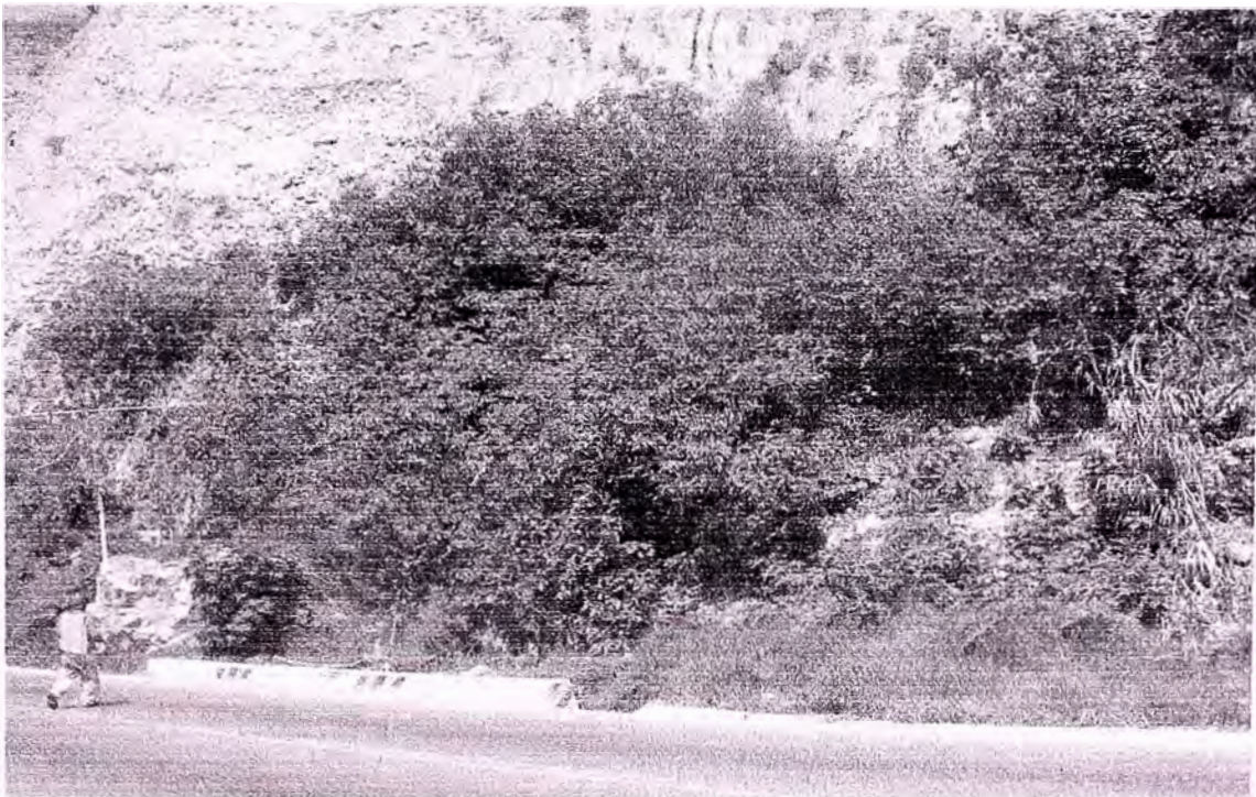
Foto No 06: km 68+340 Alcantarilla No 06
