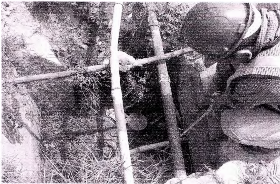
Foto No 01: km 67+020 Alcantarilla No 01
