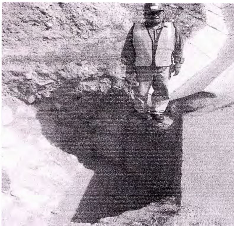
Foto No 09: km 68+913 Alcantarilla No 09
