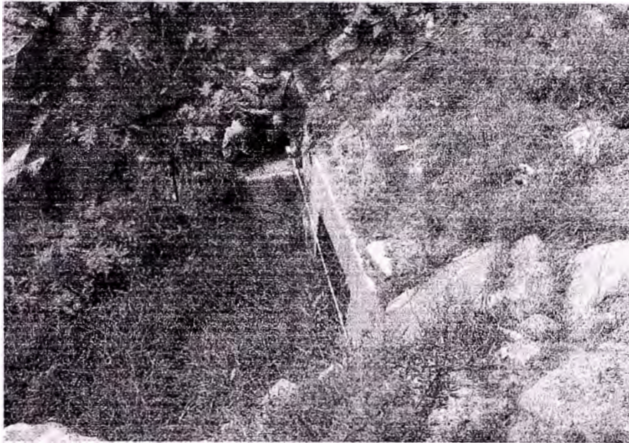
Foto No 07: km 68+497 Alcantarilla No 07
