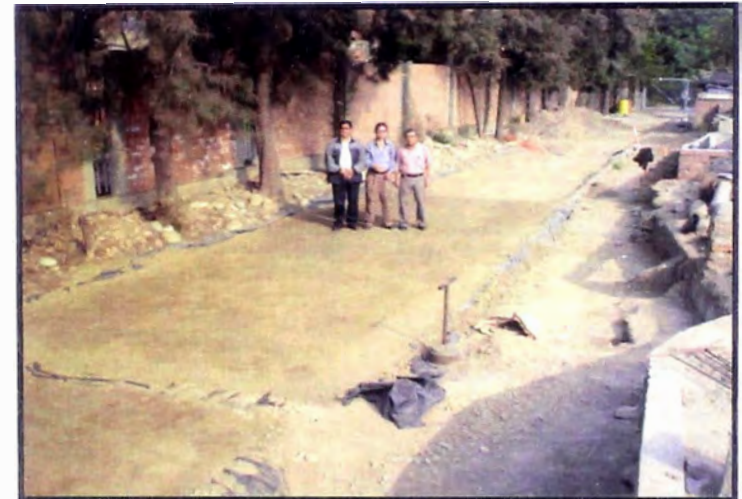
FOTO N° 20 Integrantes del grupo, y la via terminada
