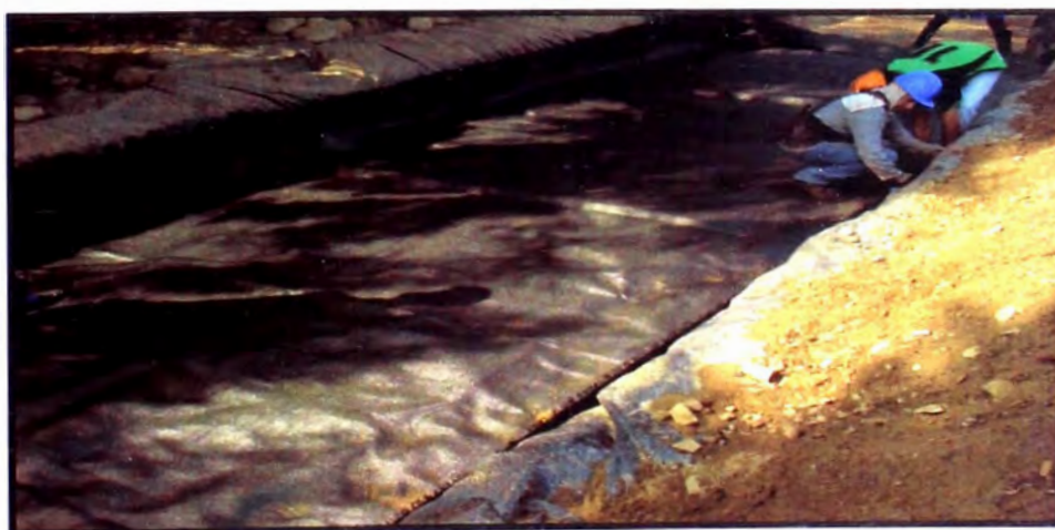
Fig. 11- 24 Colocación del geotextil tejido TR4000, como refuerzo
