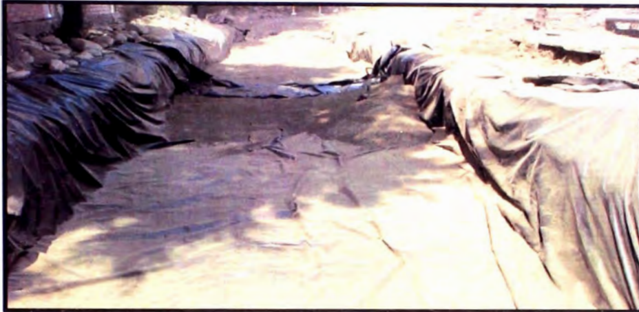
Fig. 11- 18 Impermeabilización de la excavación
