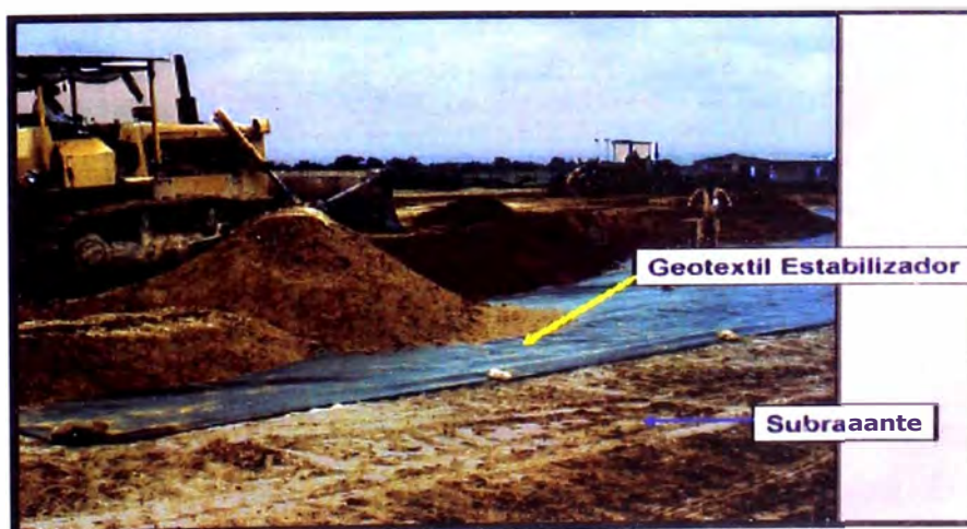
Fig. 1-18 Función del Geotextil como Estabilizador
