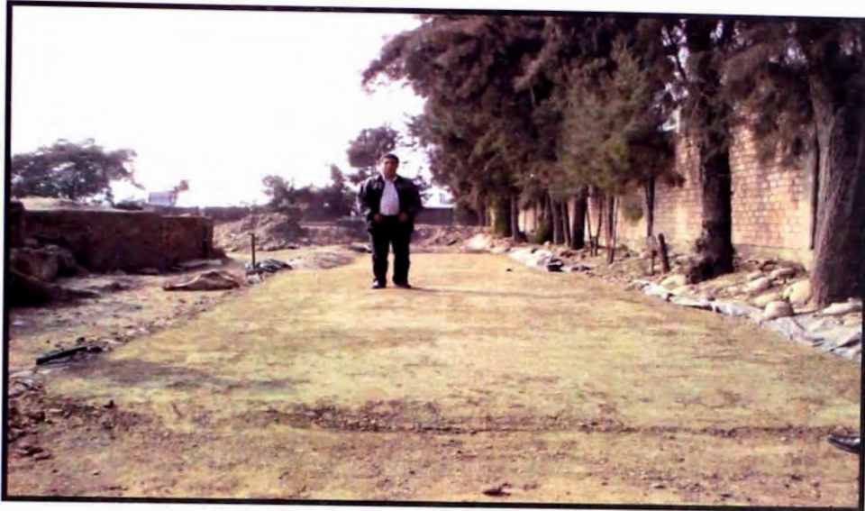
Fig. 11- 31 Vista de la vía afirmada reforzada con geotextil tejido TR 4000 terminada
