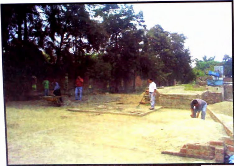
FOTO N° 01 Limpieza del terreno
