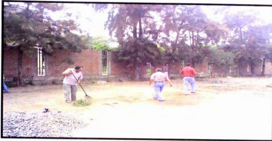
Fig. 11- 7 Otra vista de los trabajos de limpieza previa a la excavación
