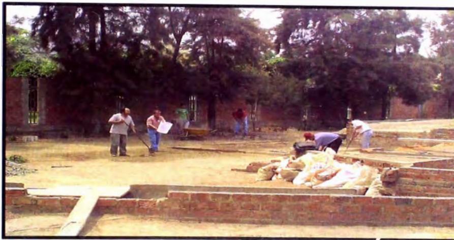
Fig. 11- 8 Otra vista de la preparación de la zona
