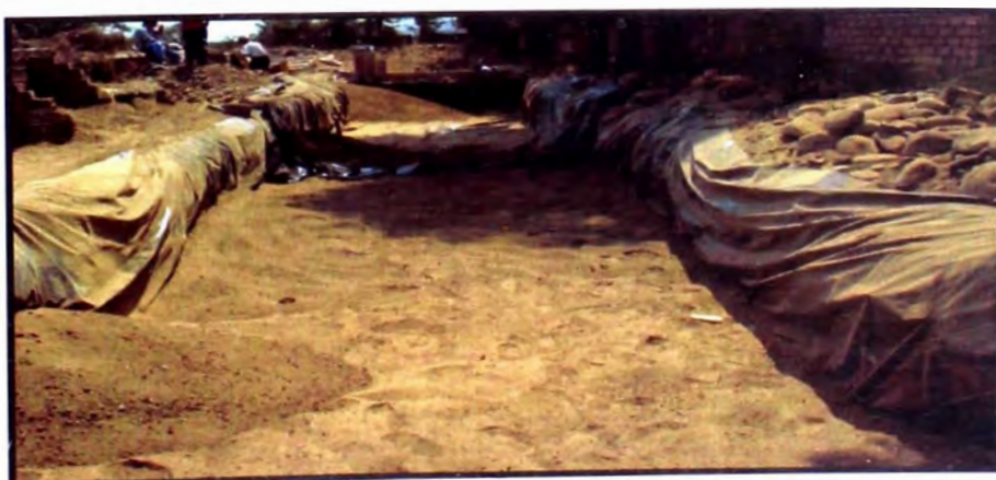
Fig. 11- 20 Avance del relleno con el material fino
