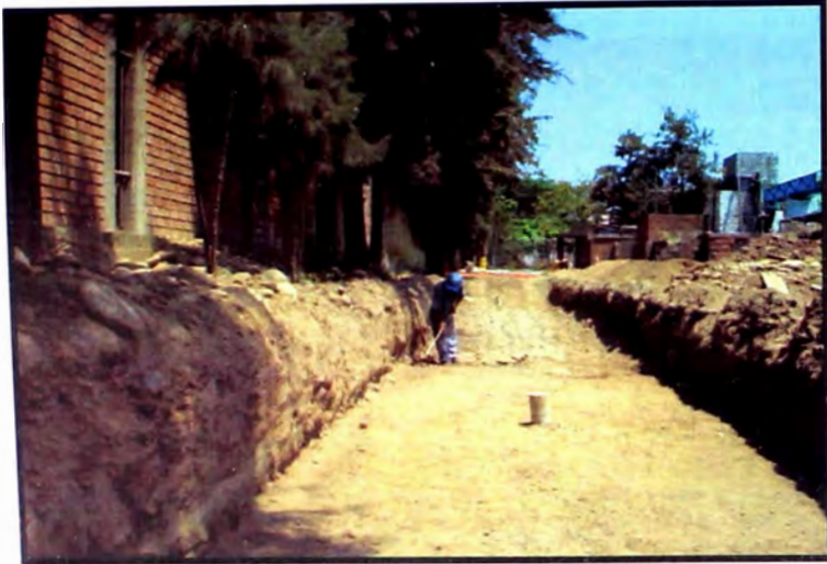
FOTO N° 05 Relleno con material degradado
