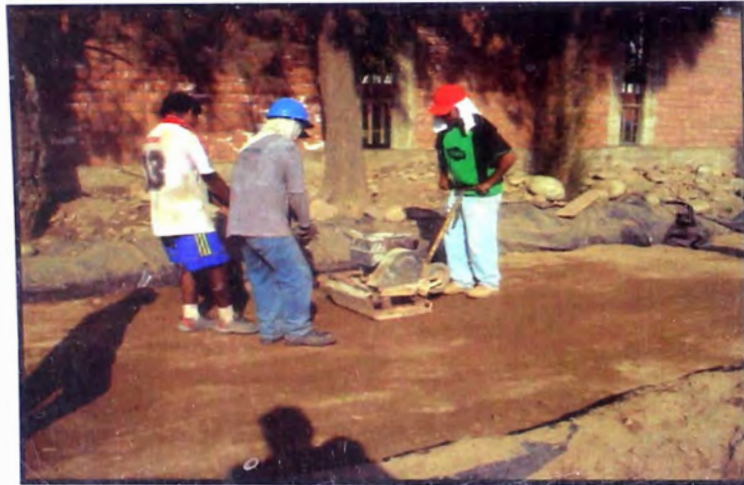
FOTO N° 15 Compactación mediante plancha vibratoria capa 2
