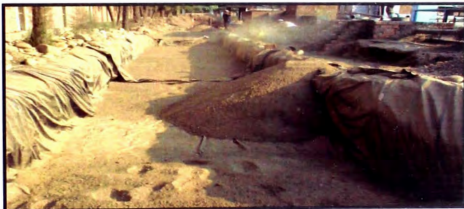
Fig. 11-19 Relleno con material arcilloso limoso
