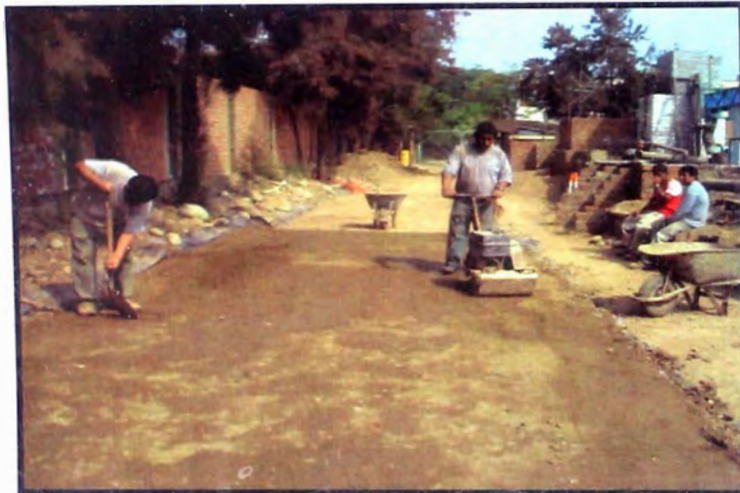
FOTO N° 19 Compactación de la capa superficial
