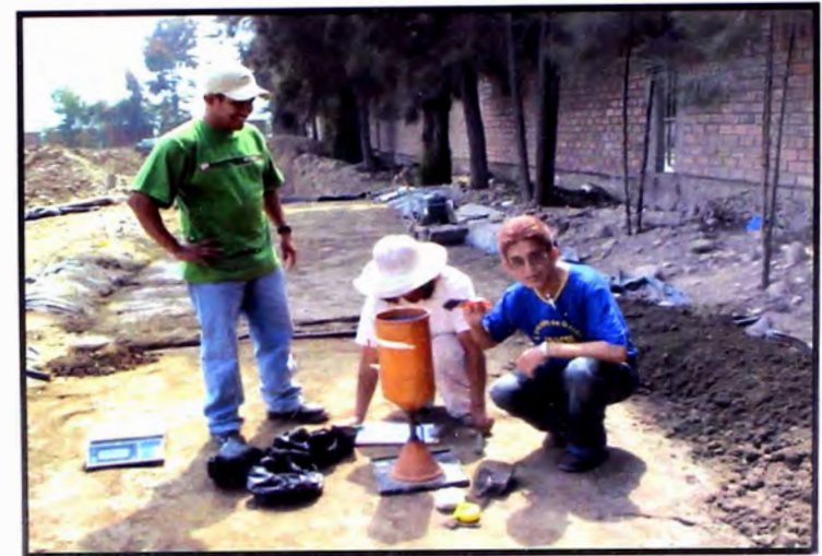
FOTO N° 18 Control de compactación de la ultima capa
