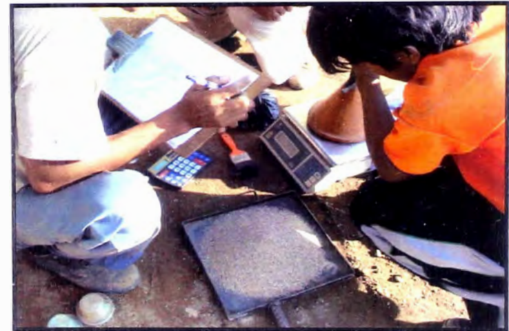
FOTO N° 16 Control de compactación segunda capa
