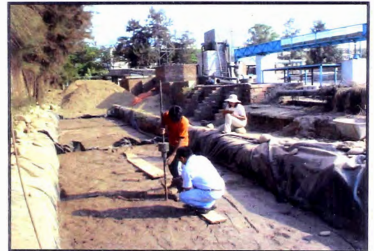
FOTO N° 08 Ensayo DPL para determinar el CBR In-situ
