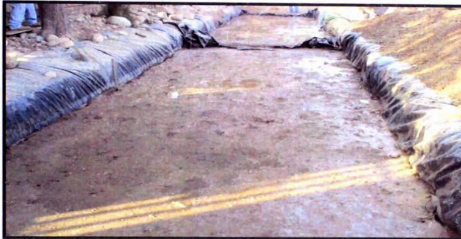
Fig. 11- 23 Vista del suelo degradado con CBR igual a 0.7 %
