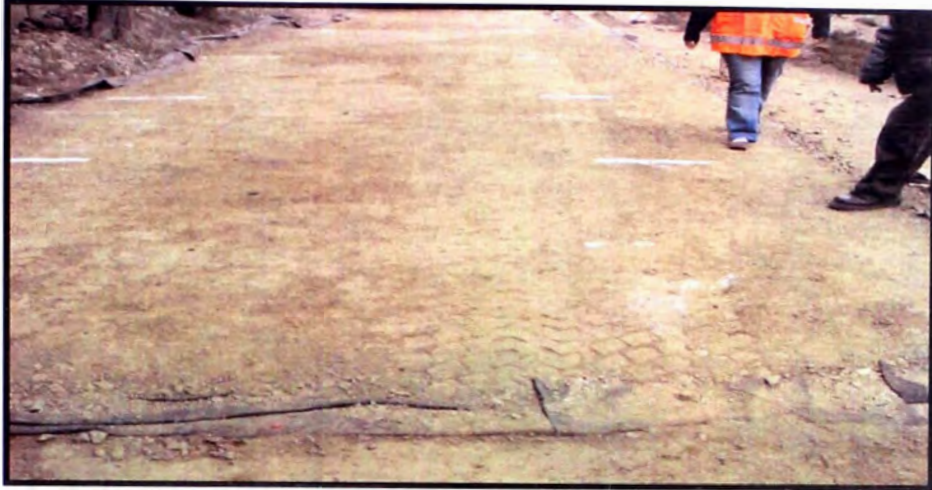
Fig. 11- 33 Demarcado de los puntos para ensayos de deflexiones
