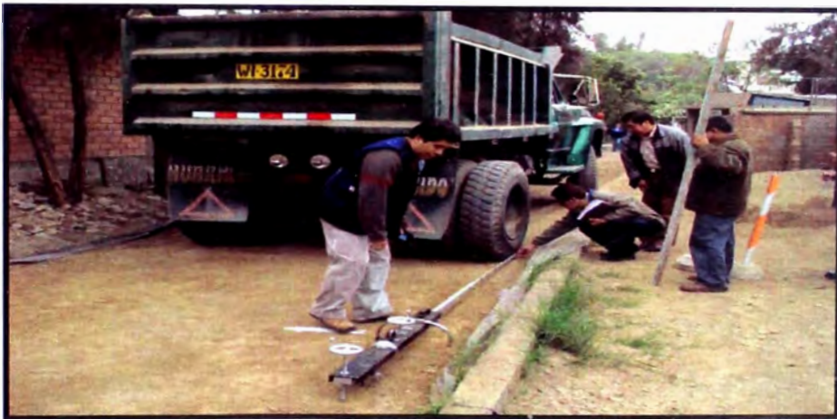
Fig. 11- 34 Posicionamiento de la viga para su demarcación, respecto al eje del volquete
