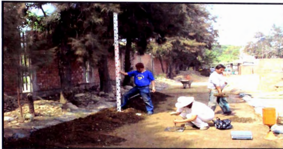
Fig. 11- 29 Vista de colocación plantilla para la capa 4, y control compactación capa 3
