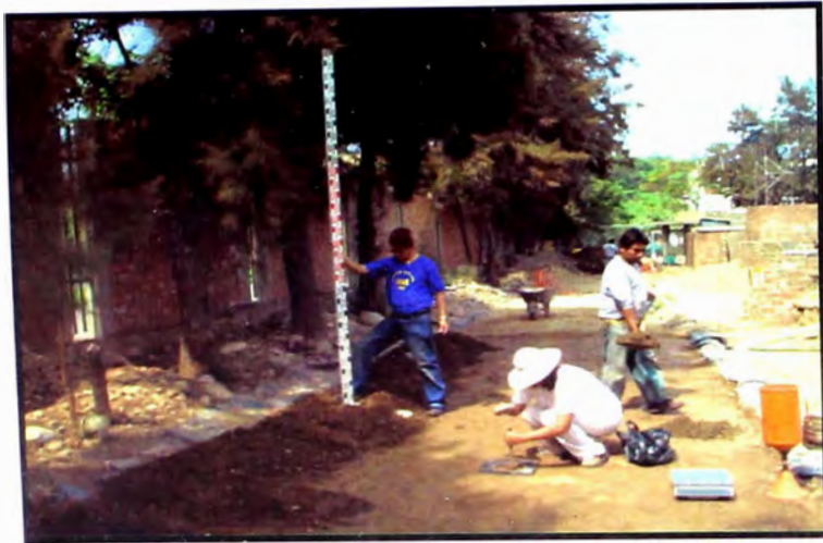
FOTO N° 17 Emplantillado de la última capa y control compactación capa 3
