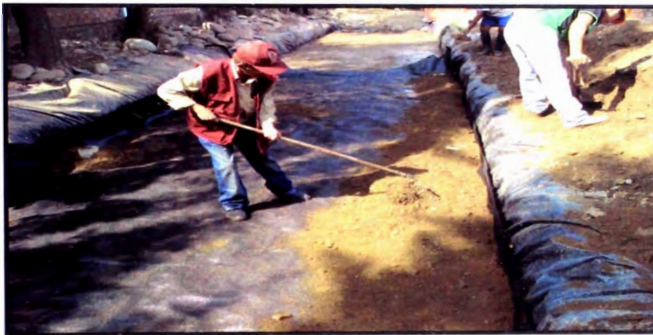
Fig. 11- 25 Conformación de la primera capa de afirmado sobre el geotextil
