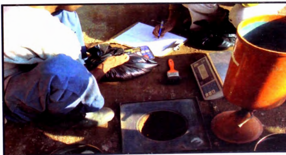
Fig. 11- 28 Vista de la prueba de densidad en la capa 2
