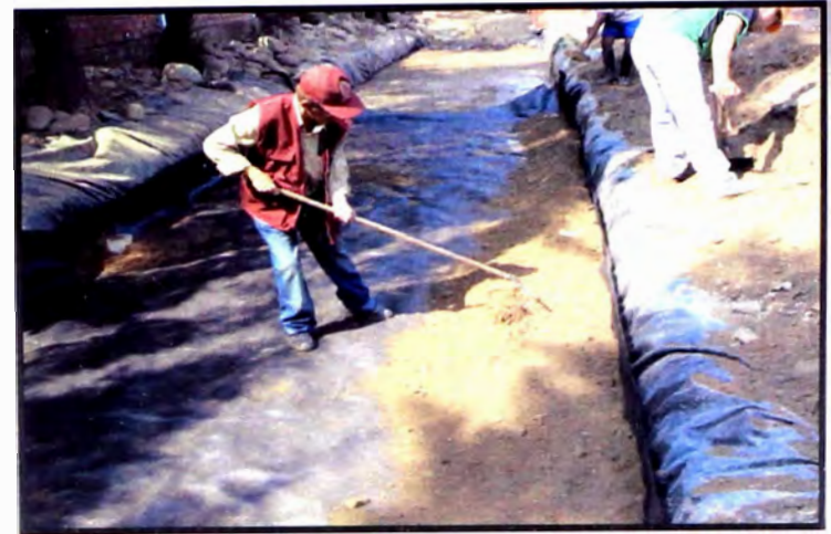
FOTO N° 10 Conformación de la primera capa
