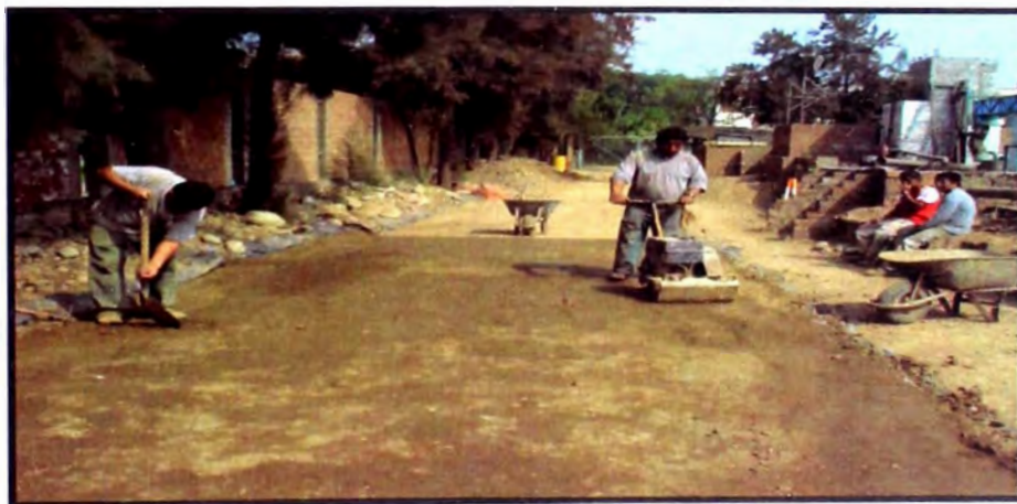
Fig. 11- 30 Compactación de la capa final
