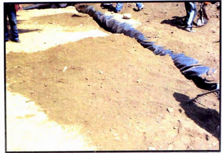
FOTO N° 14 Conformación de la segunda capa
