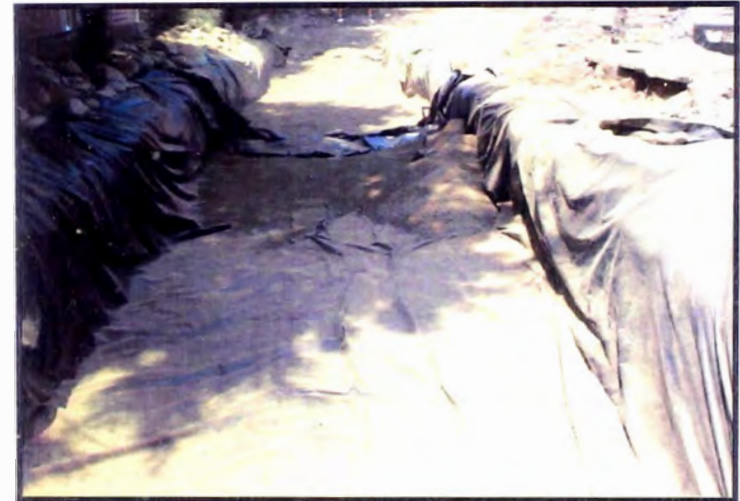
FOTO N° 04 Impermeabilización mediante plástico
