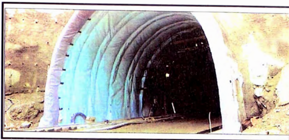
Fig. 1- 33 Forro completado de una sección de túnel
