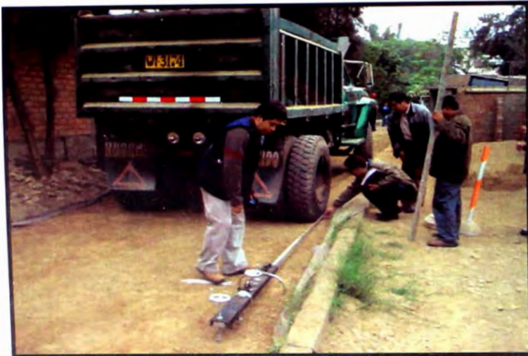
FOTO N° 21 Marcado en los brazos de la viga, para las lecturas
