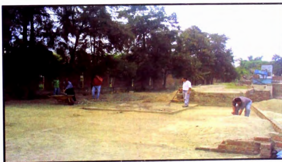
Fig. 11- 6 Limpieza de la zona de trabajo
