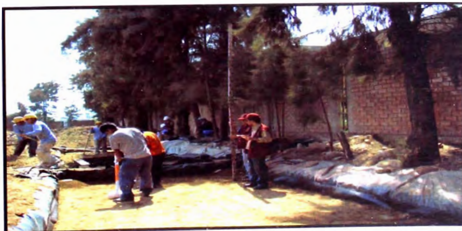
Fig. 11- 26 Compactación mediante pisones manuales para la 1ra capa
