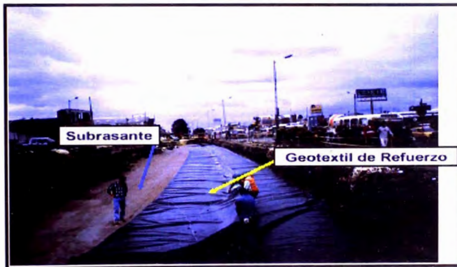
Fig. 1-19 Función del Geotextil como Refuerzo
