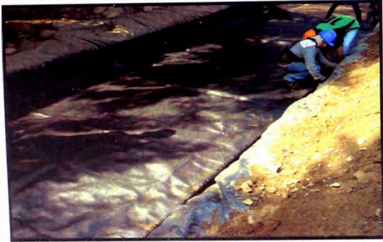
FOTO N° 9 Colocación del geotextil sobre el suelo blando
