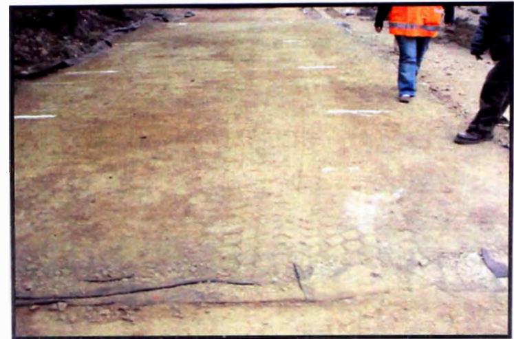
FOTO N° 22 Marcado en la vía donde se medirá las deflexiones
