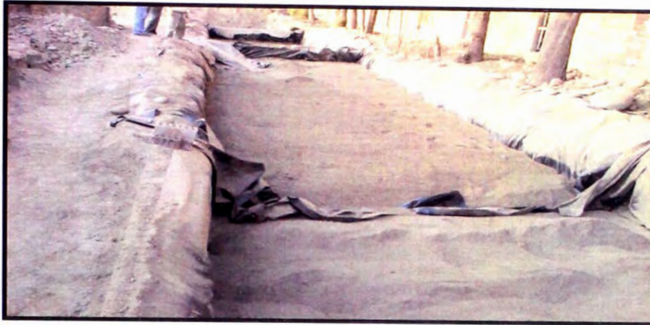
Fig. 11- 21 Relleno casi a nivel de subrasante terminada
