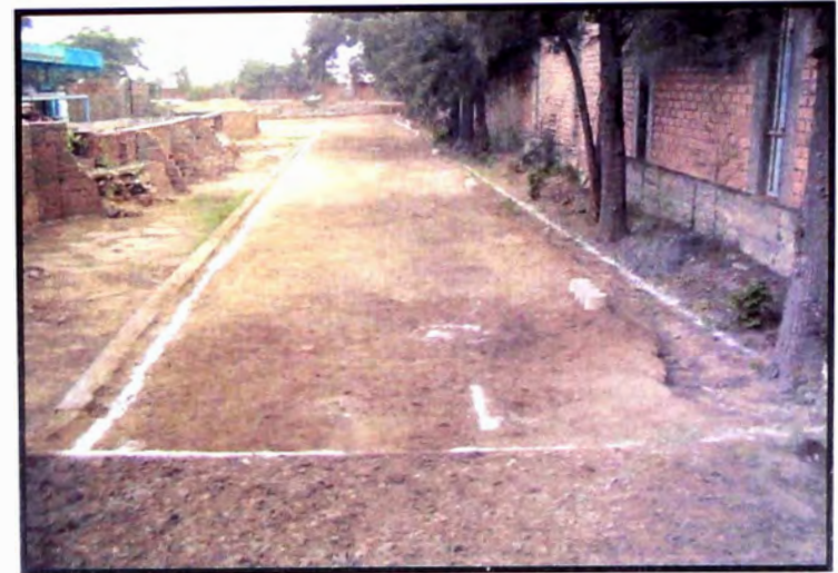
FOTO N° 02 Trazo y Replanteo
