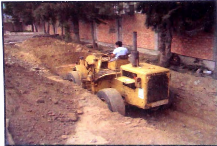
FOTO N° 03 Excavación masiva en terreno natural
