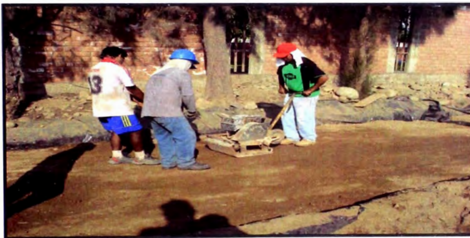
Fig. 11- 27 Compactación mecánica de la capa 2
