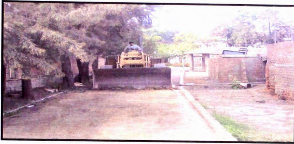
Fig. 11- 10 Inicio de la excavación con el cargador frontal
