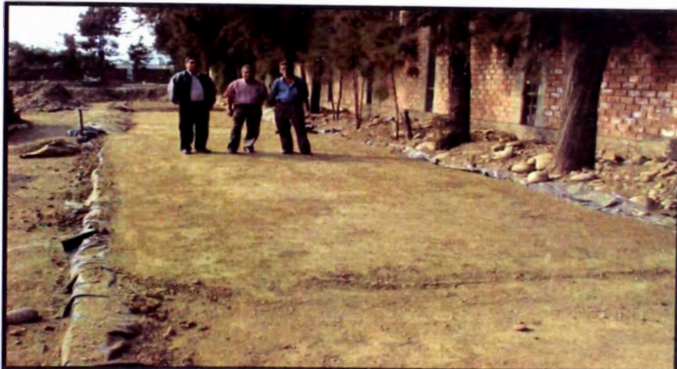
Fig. 11- 32 Otra vista de la vía terminada
