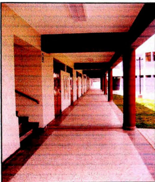
Foto 1.2.- Pasadizos 1er nivel – Pabellón de Educación Física
