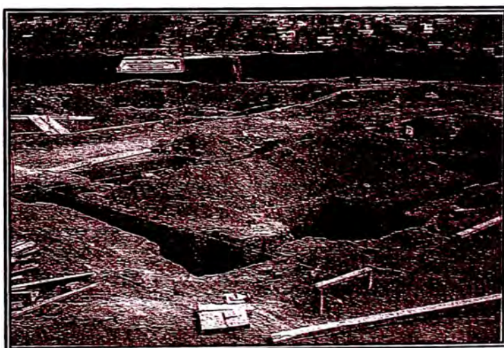
Foto 2.3.- Excavación de zanjas en pabellón administrativo.
