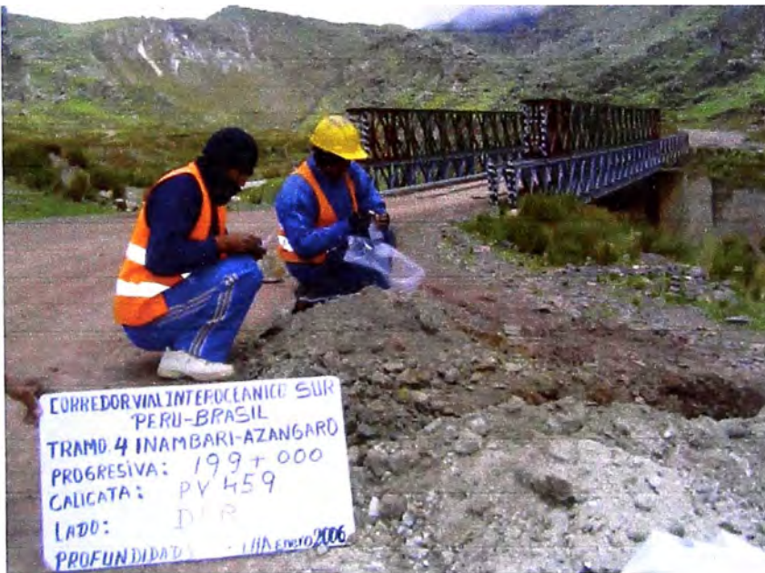
Calicata PV- 459, Km. 198+755, vista panorámica
