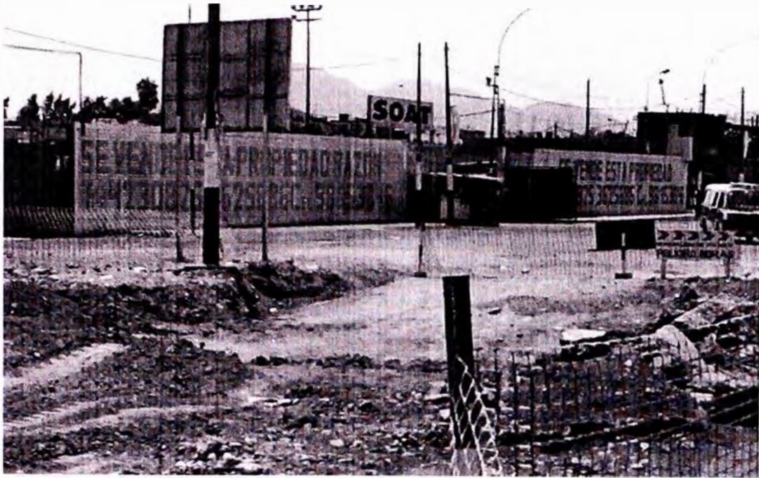
FOTO N° 1 Vista del Acceso por la Av. Ruisefiores, se observa los trabajos de Ampliación de dicha Avenida
