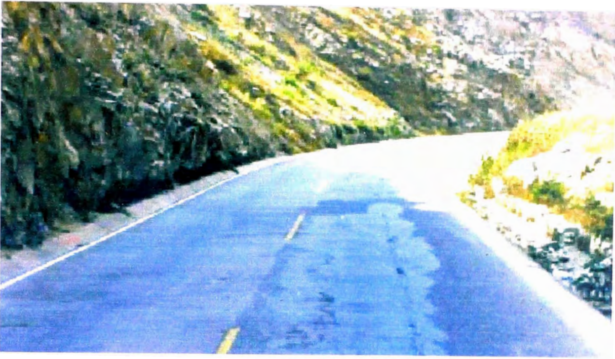
FOTO Nº 7: Pavimento antes de la rehabilitación KM 68+000.
