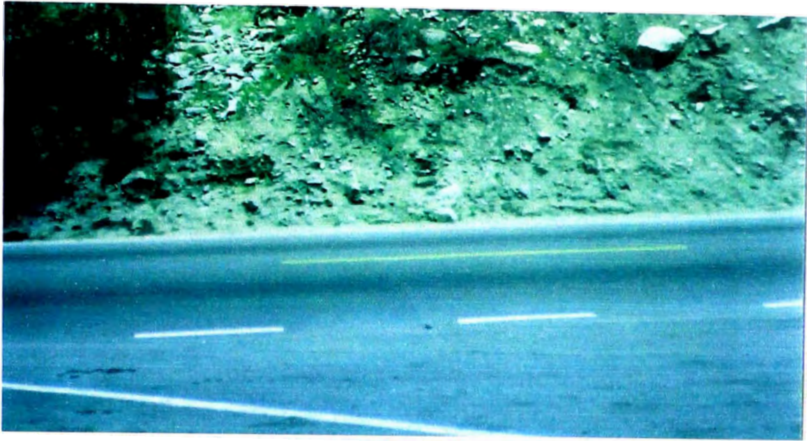
Foto N° 11: Pista rehabilitada en progresiva KM 66+220
