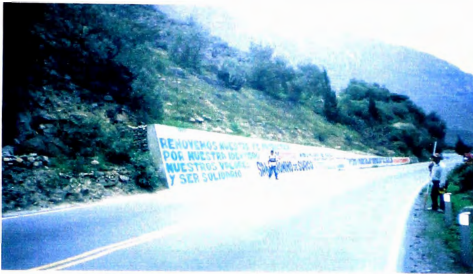
Foto N° 9: Pista rehabilitada entre las progresivas KM 65+520 KM 65+580 vista hacia atrás.
