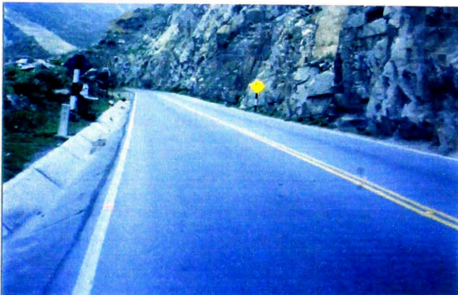
Foto N° 12: Pavimento en perfectas condiciones luego de la Rehabilitación. KM 66+500 vista hacia atrás
