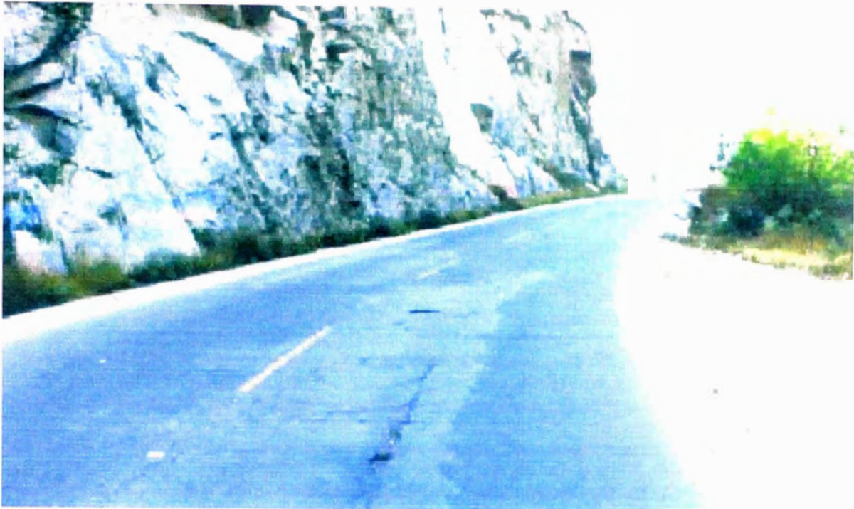
FOTO Nº 5: Pavimento antes de la rehabilitación KM 67+000.
