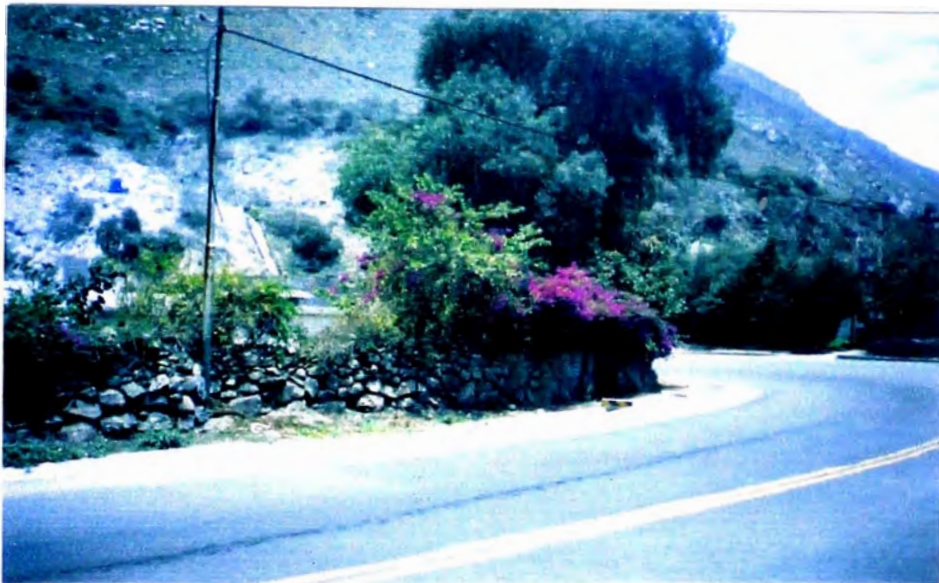
Foto Nº 8: Pista rehabilitada KM 65+200, vista hacia delante.
