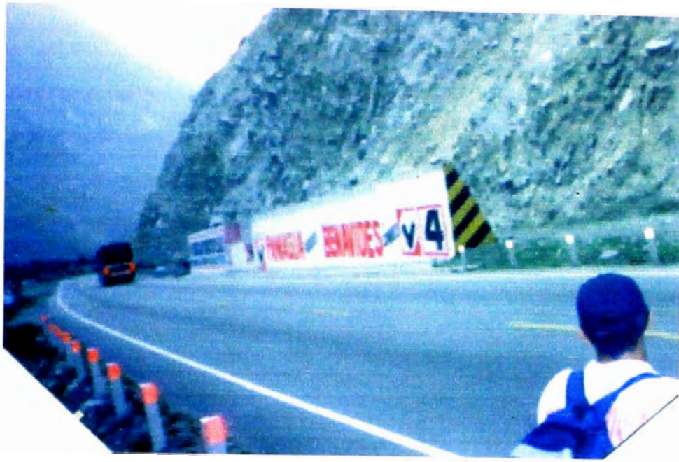
Foto N° 13: Pista rehabilitada entre el KM 67+500.
