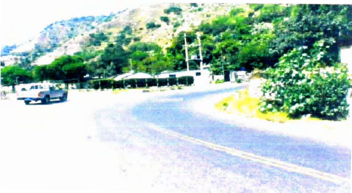
FOTO Nº 2: Pavimento antes de la rehabilitación KM 65+200.
