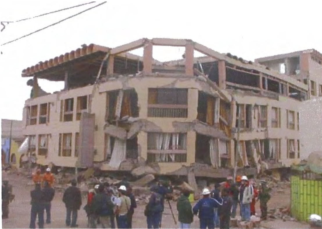
Figura 4.7.1.a Vista del Hotel Embassy luego del colapso
