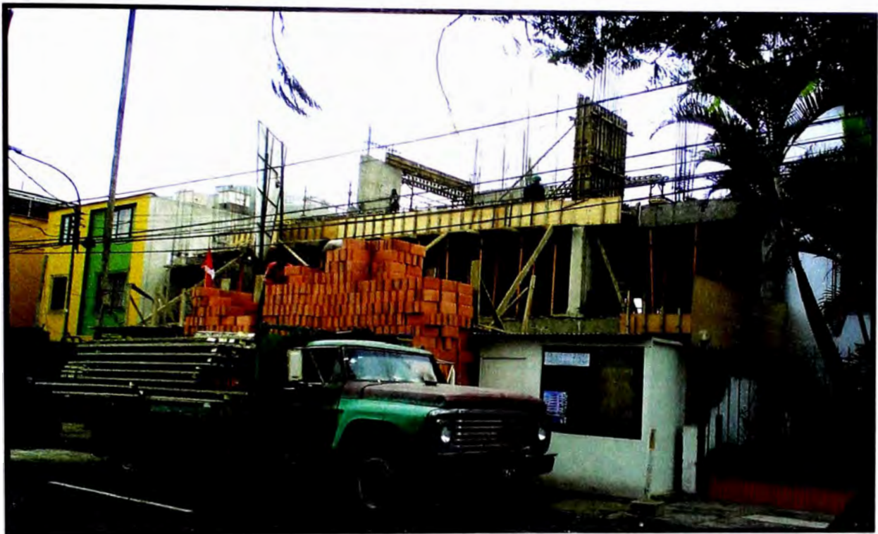
FOTO N° 03: DURANTE LA CONSTRUCCION
