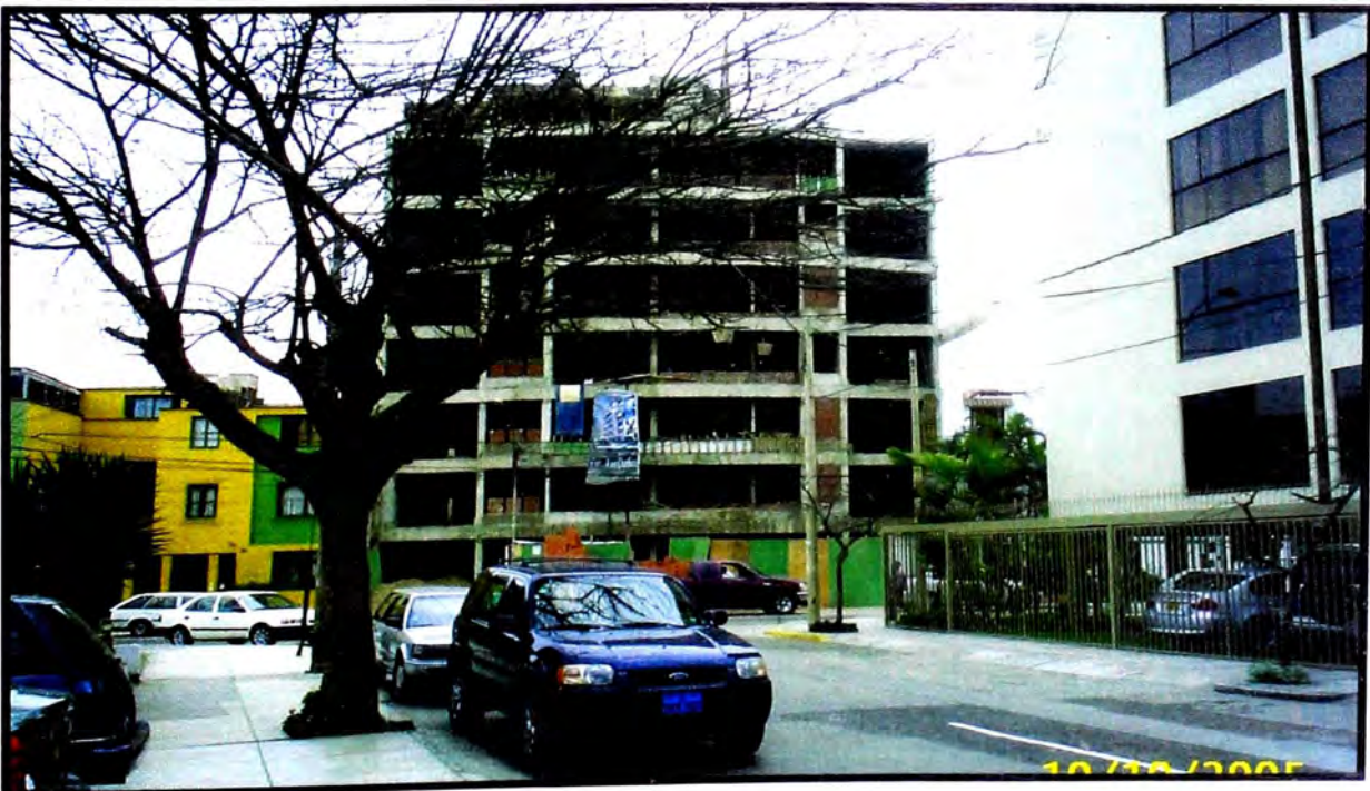
FOTO N° 02: DESPUES DE LA EJECUCION DEL PROYECTO
