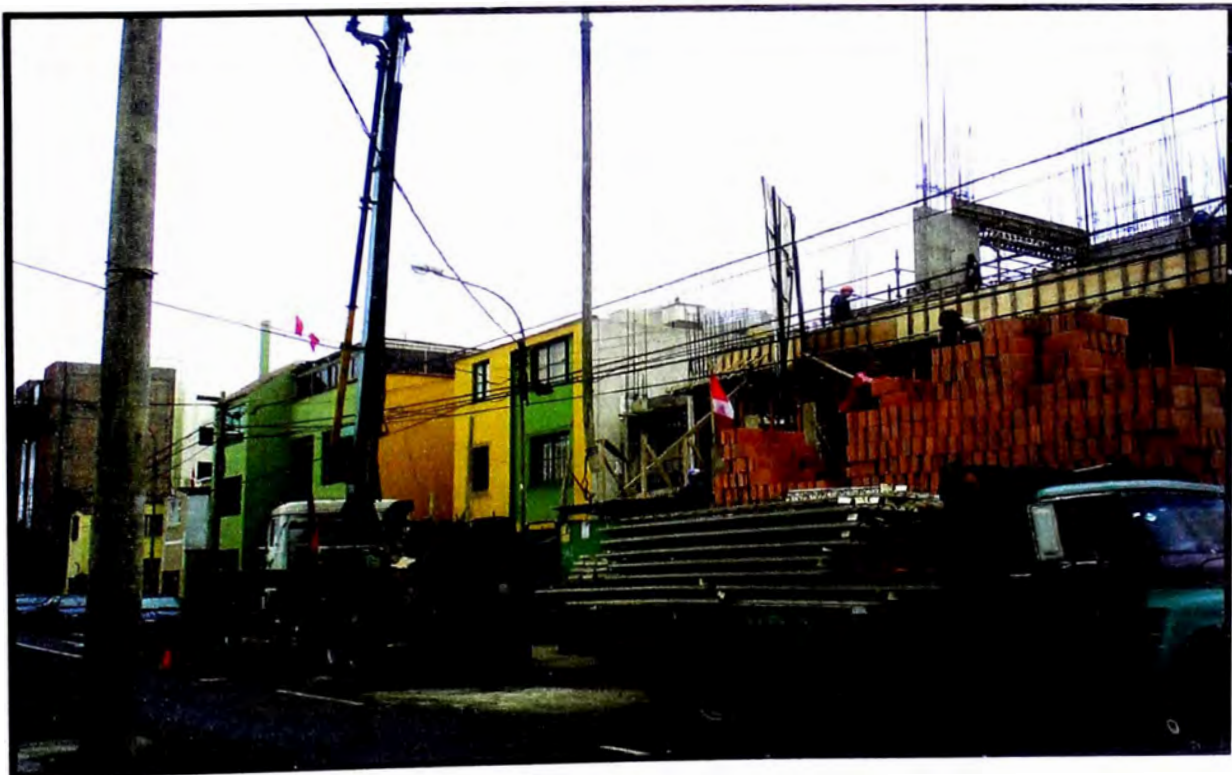
FOTO N° 04: DURANTE LA CONSTRUCCION
