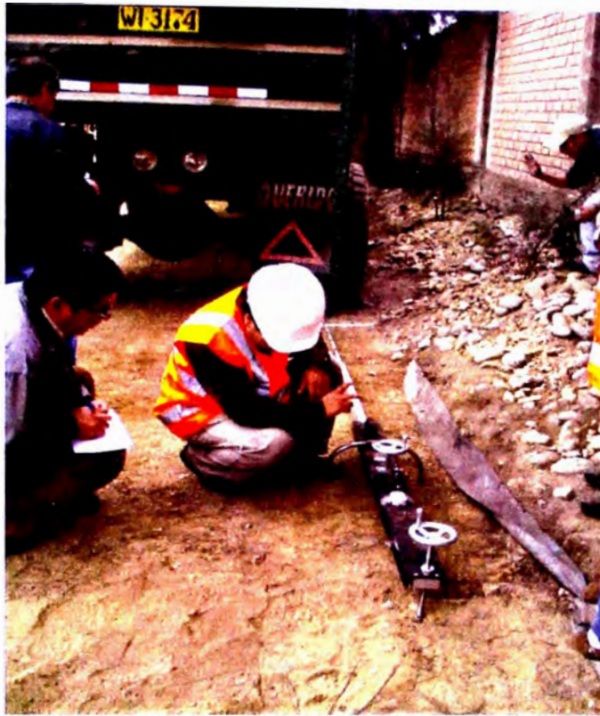
Fig. 4.6 Ejecución del ensayo.
