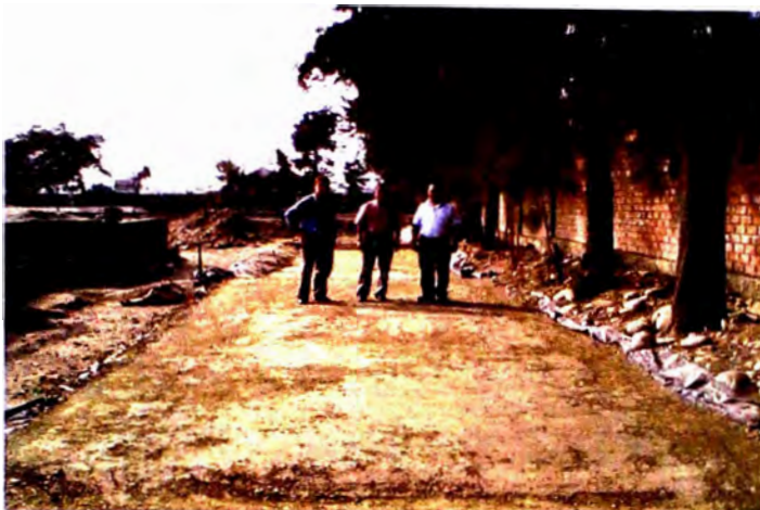
Fig. 2.32 Otra vista de la via terminada.
