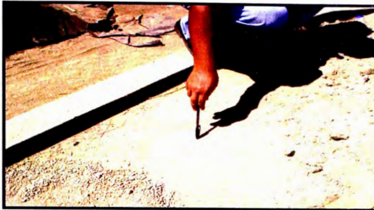
Fig. 2.5 Otra vista del punto de control.
