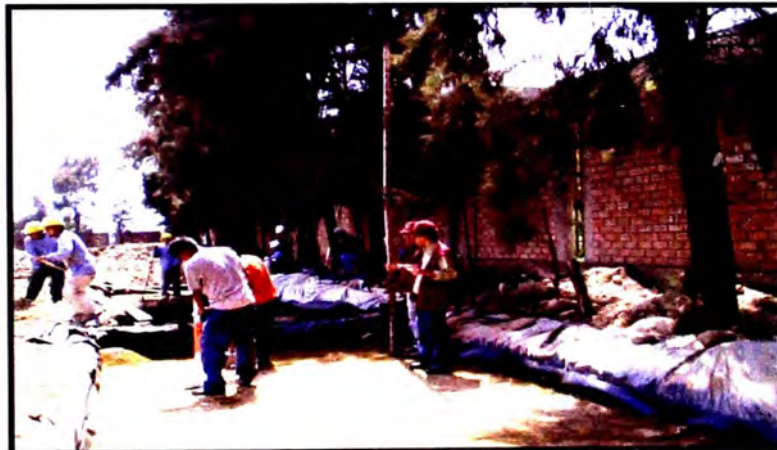
Fig. 2.26 Compactación mediante pisones manuales para la 1ra capa
