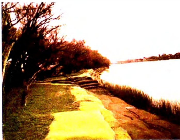
Fig 1.27 Aplicación del geotextil en defensa ribereña.
