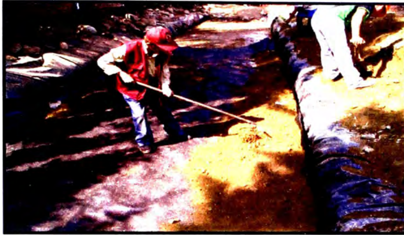
Fig. 2.25 Conformación de la primera capa de afirmado sobre el geotextil.
