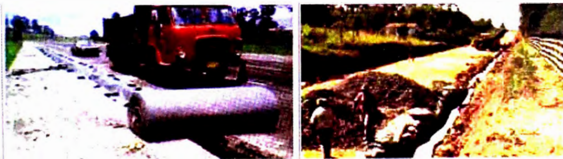
Fig. 1.7 Colocación del geotextil en una zanja
