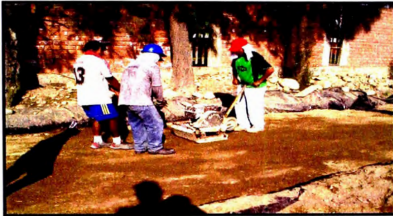
Fig. 2.27 Compactación mecánica de la capa 2.
