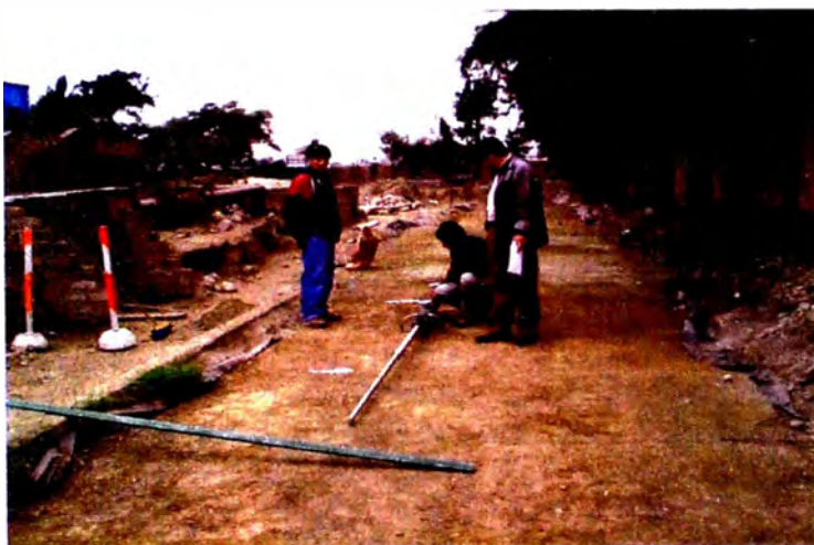
Fig. 4.4 Realizando el marcado de las estaciones de medición.
