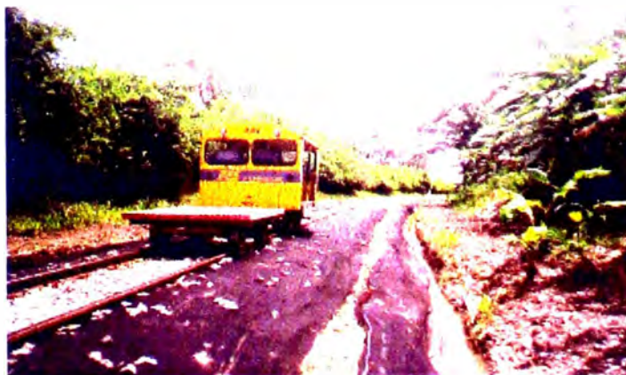
Fig. 1.24 Via férrea con geotextil
