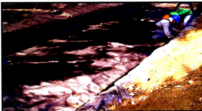
Fig. 2.24 Colocación del geotextil tejido TR4000, como refuerzo.
