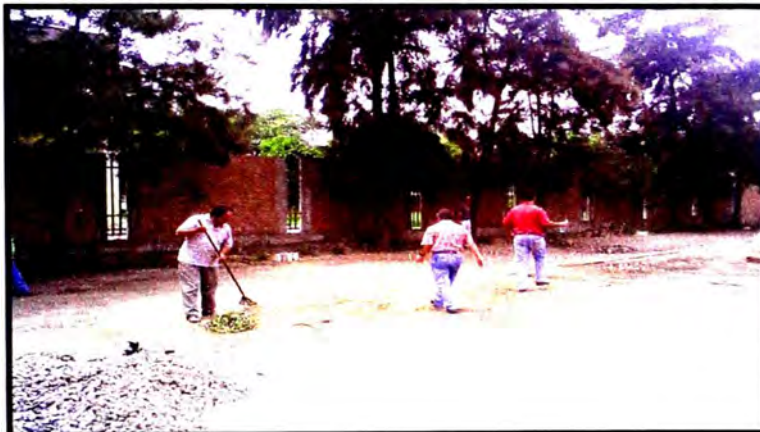
Fig. 2.7 Otra vista de los trabajos de limpieza previa a la excavación.
