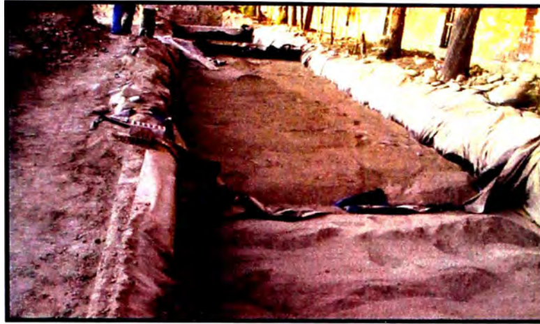
Fig. 2.21 Relleno casi a nivel de subrasante terminada.
