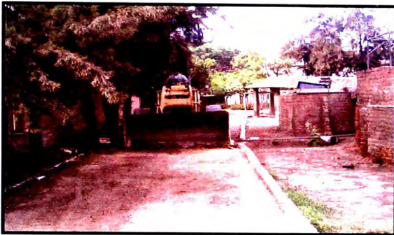
Fig. 2.10 Inicio de la excavación con el cargador frontal
