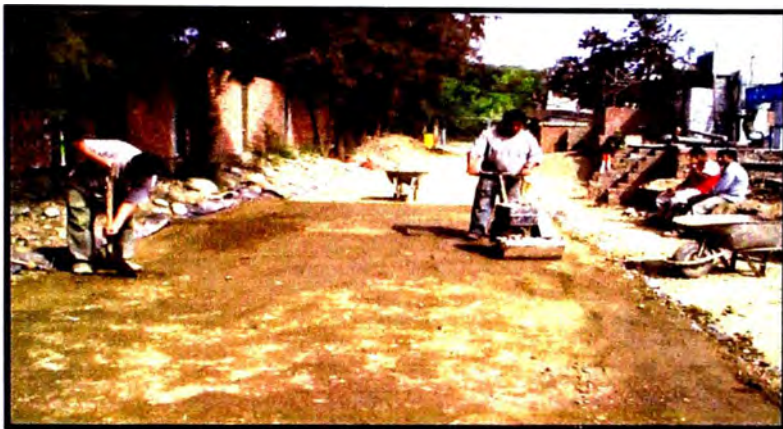
Fig. 2.30 Compactación de la capa final.
