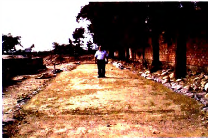
Fig. 2.31 Vista de la vía afirmada reforzada con geotextil tejido TR 4000 terminada.
