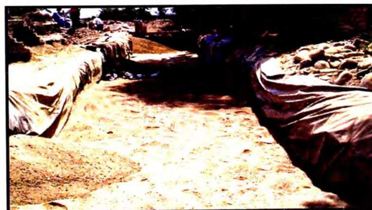
Fig. 2.20 Avance del relleno con el material fino.
