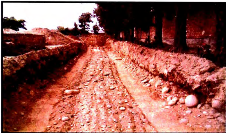
Fig. 2.11 Vista parcial de la excavación se aprecia el suelo granular del fondo.
