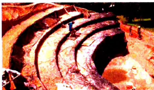
Fig 1.25 Muro de contención con geotextiles
