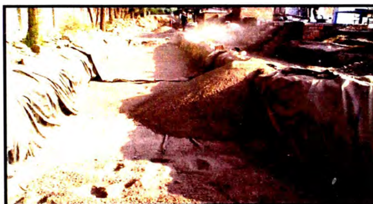
Fig. 2.19 Relleno con material arcilloso limoso.
