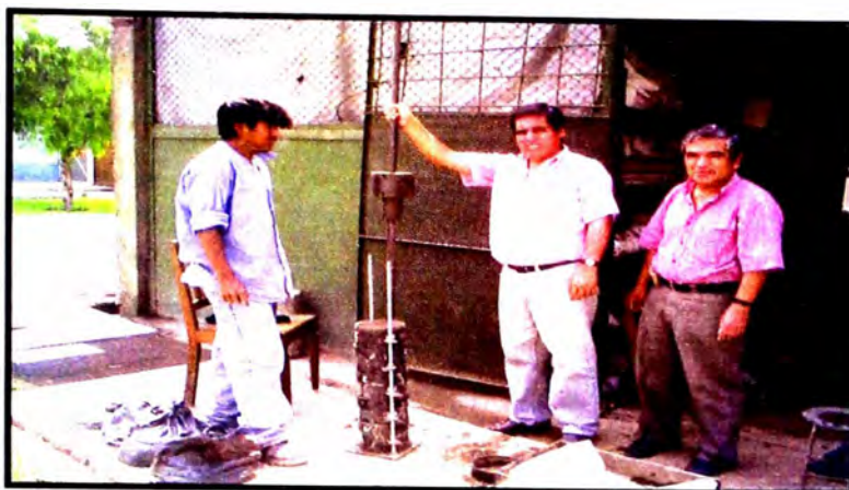
Fig. 2.16 Ensayo de penetración con equipo DPL
