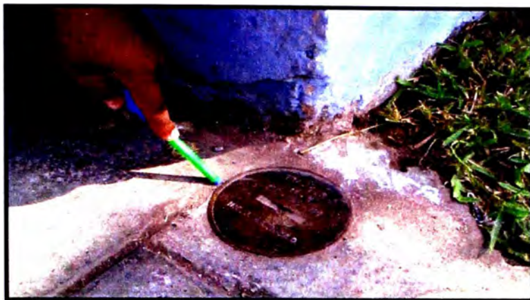
Fig. 2.3 BM topográfico (placa de bronce).
