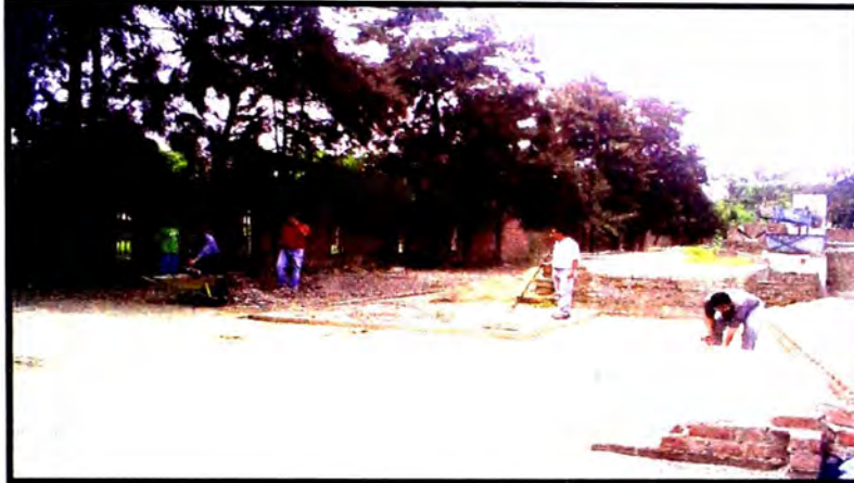
Fig. 2.6 Limpieza de la zona de trabajo.
