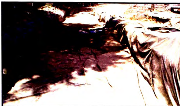
Fig. 2.18 Impermeabilización de la excavación.
