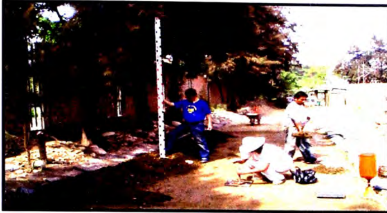
Fig. 2.29 Vista de colocación plantilla para la capa 4, y control compactación capa 3.
