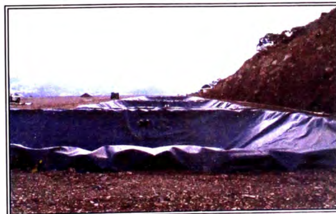
Obra Hidráulica:Poza de Relaves Fig. 1- 2
