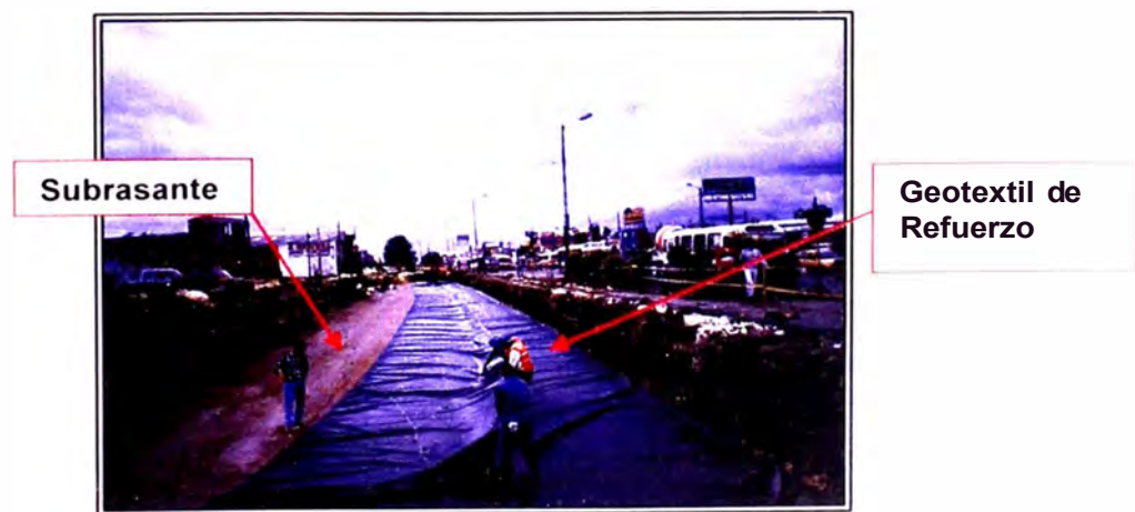
Función del Geotextil como Refuerzo
