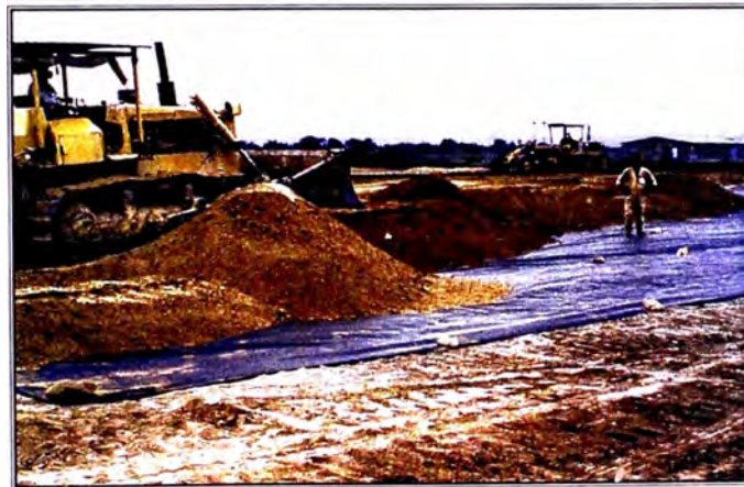
Obra Vial Fig. 1- 1
