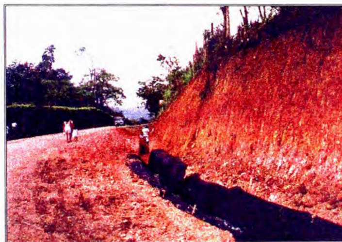
Drenaje en Vías
