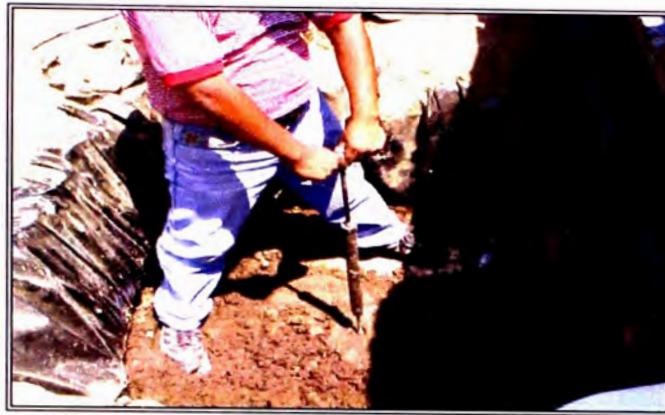
Prueba de resistencia del suelo con Penetrómetro
