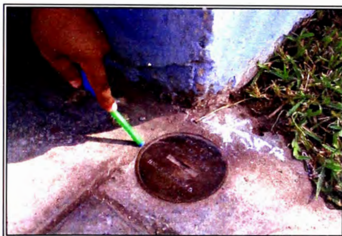
BM topográfico (placa de bronce)
