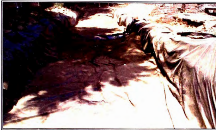
Colcación del Plástico como Impermeabilizante
