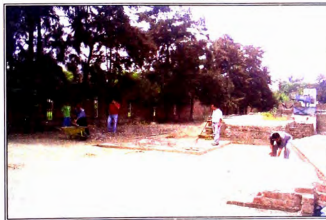
Limpieza de la zona de trabajo
