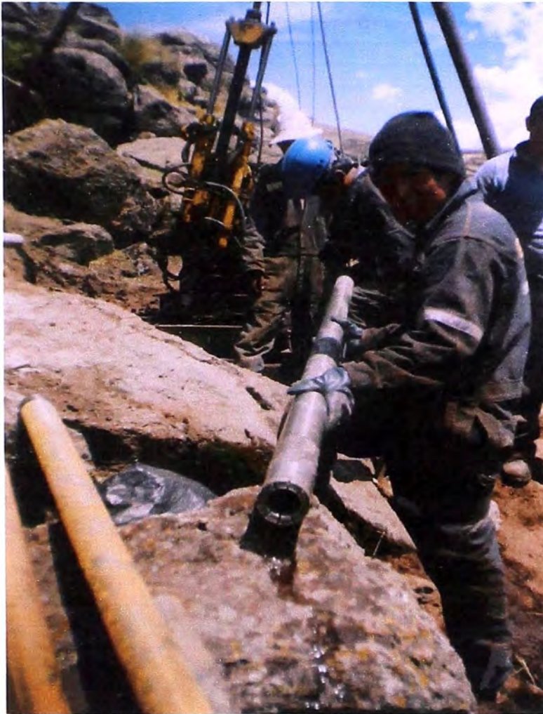
Foto 7: Equipo de perforación diamantina en el estribo derecho del eje de la Presa Vizcachani.
