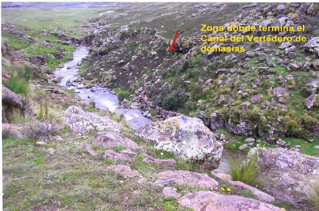
Foto 6: Zona donde termina el canal del vertedero de demasías.
