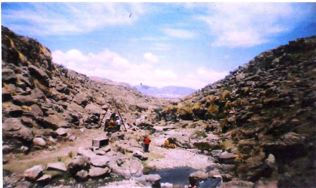
Foto 8: Perforación diamantina en el eje de la Presa Vizcachani.
