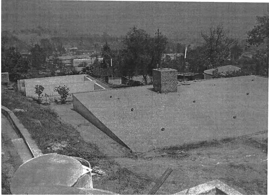
Reservorio R1. En la toma inferior se aprecia una de las fisuras existentes en el techo.
