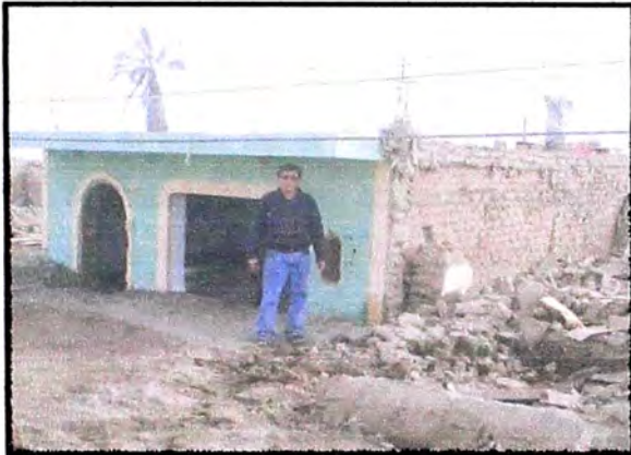
Fig.1. Suelos no aptos para la construcción. Licuación en Tambo de Mora en el sismo de Pisco del 15-08-2007 (izq.), y arcilla expansiva en Talara (derecha).
