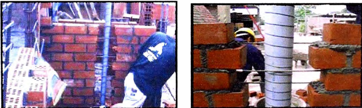
Fig.3.- Falsa columna. Nótese las mechas horizontales embutidas en la albañilería, para conectar las partes divididas del muro.
