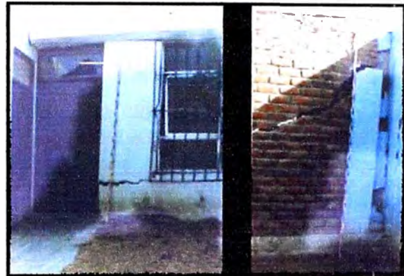
Fig.1. Suelos no aptos para la construcción. Licuación en Tambo de Mora en el sismo de Pisco del 15-08-2007 (izq.), y arcilla expansiva en Talara (derecha).
