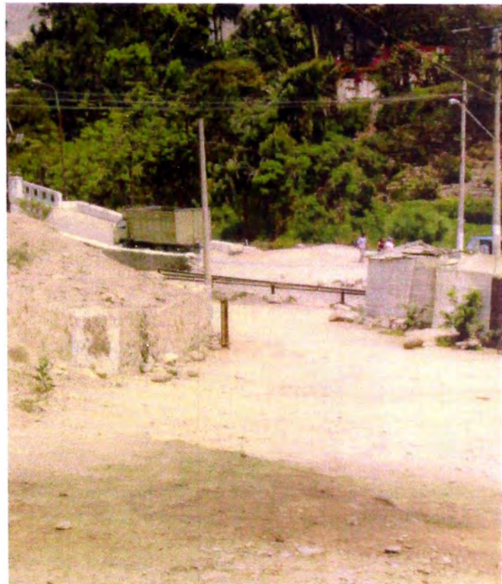
FOTO 2: Tramo recto de vía a construir Progresiva 0 + 360
