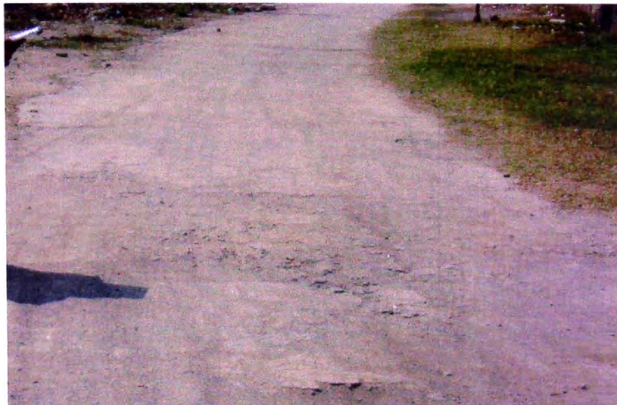
FOTO 4: Calle Circunvalación Progresiva 0 + 720
