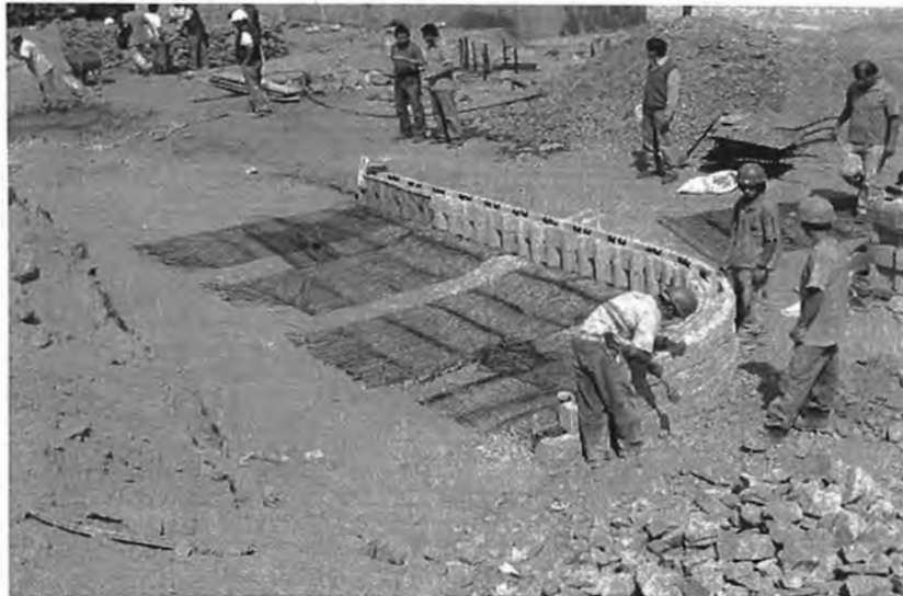
Colocación de las hiladas superiores
