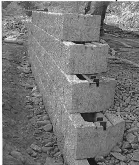
Colocación de las hiladas superiores
