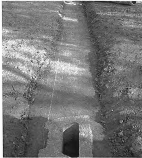
Losa de Nivelación
