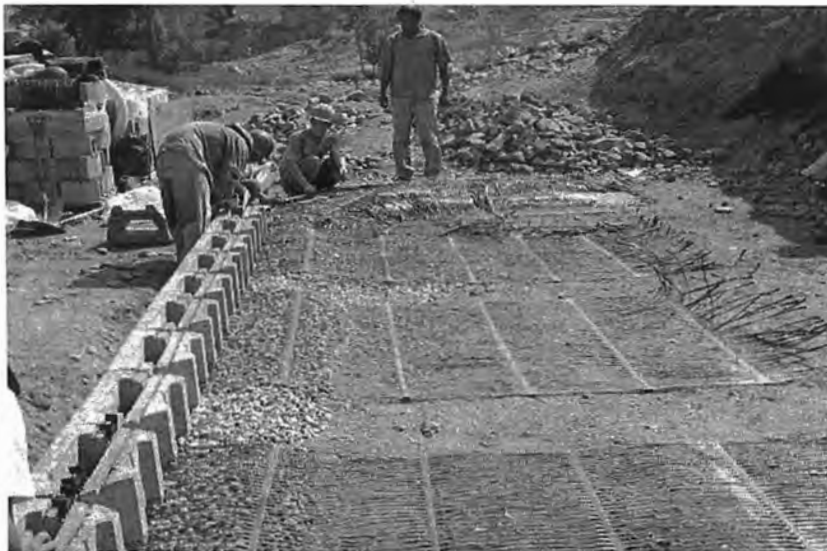
Colocación de geomallas
