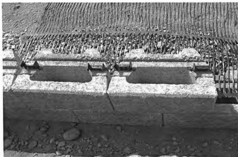
Colocación de geomallas
