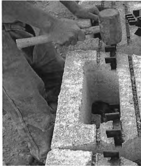
Colocación de conectores
