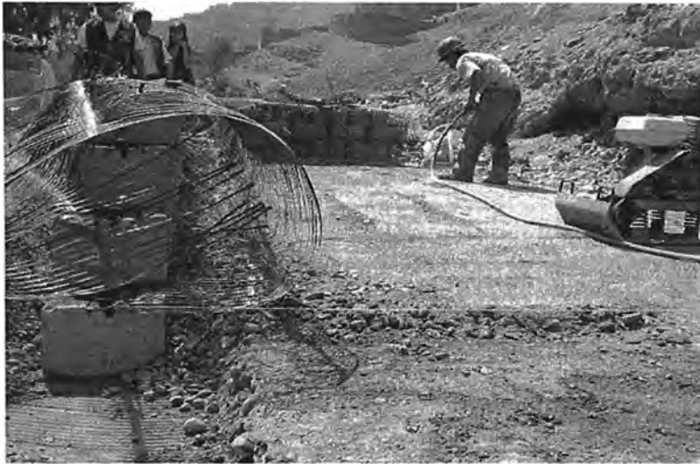
Retiro de la geomalla para compactar
