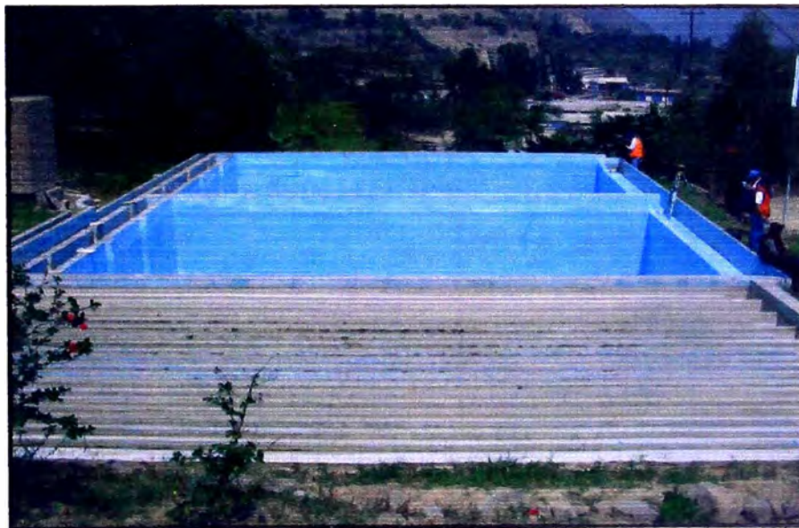
FIGURA 2.4: FLOCULADOR Y DECANTADOR - ACTUAL
