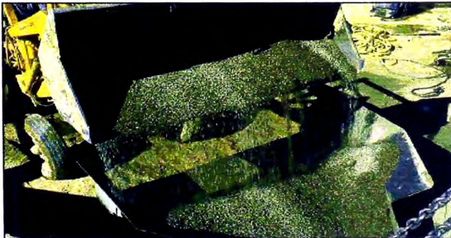
FIGURA 1.11: TRANSPORTE DE GRAVA
