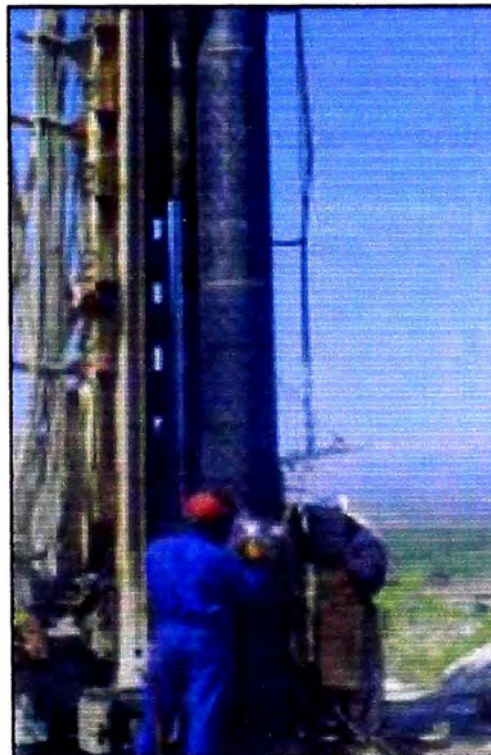
FIGURA 1.8: DESCENSO DE LA COLUMNA DE ENTUBADO Y REJILLA
