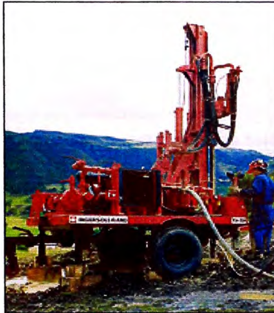
FIGURA 1.6: PERFORACIÓN DE POZO – METODO PERCUSIÓN
