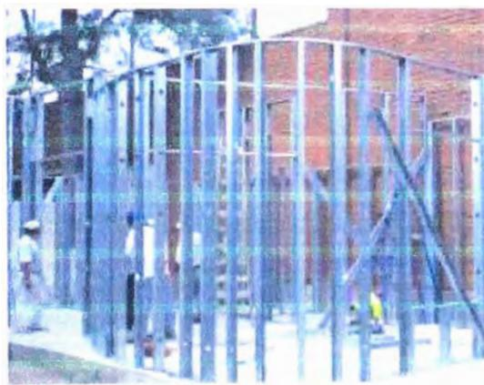
**Figura 7 - Perfiles de acero galvanizado del sistema Drywall**
