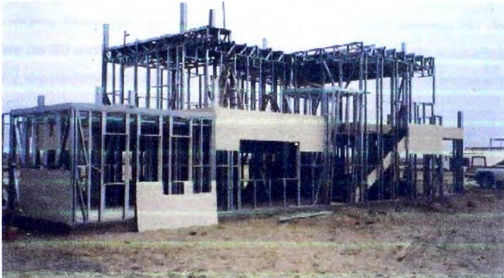
**Figura 6 - Construcción de una casa de dos pisos con el sistema Drywall**
