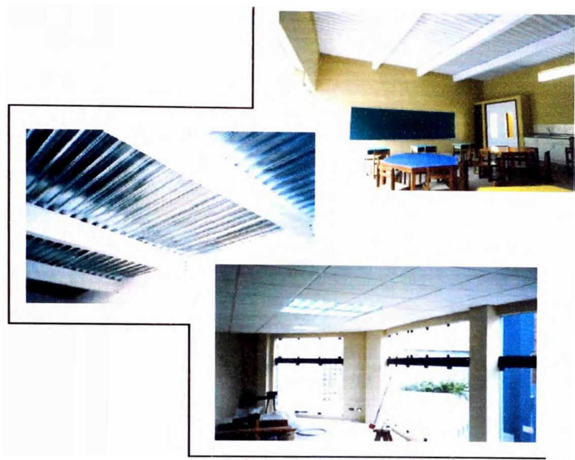
**Figura 18** Diferentes tipos de acabado con la losa de placa colaborante.
