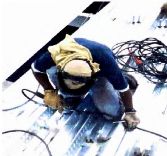
**Figura 14- Soldado de Conectores de corte.**
