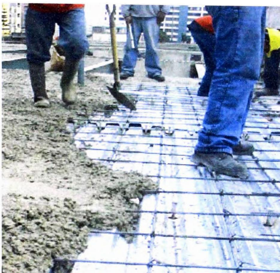
**Figura 16 Vaciado de losa de concreto.**
