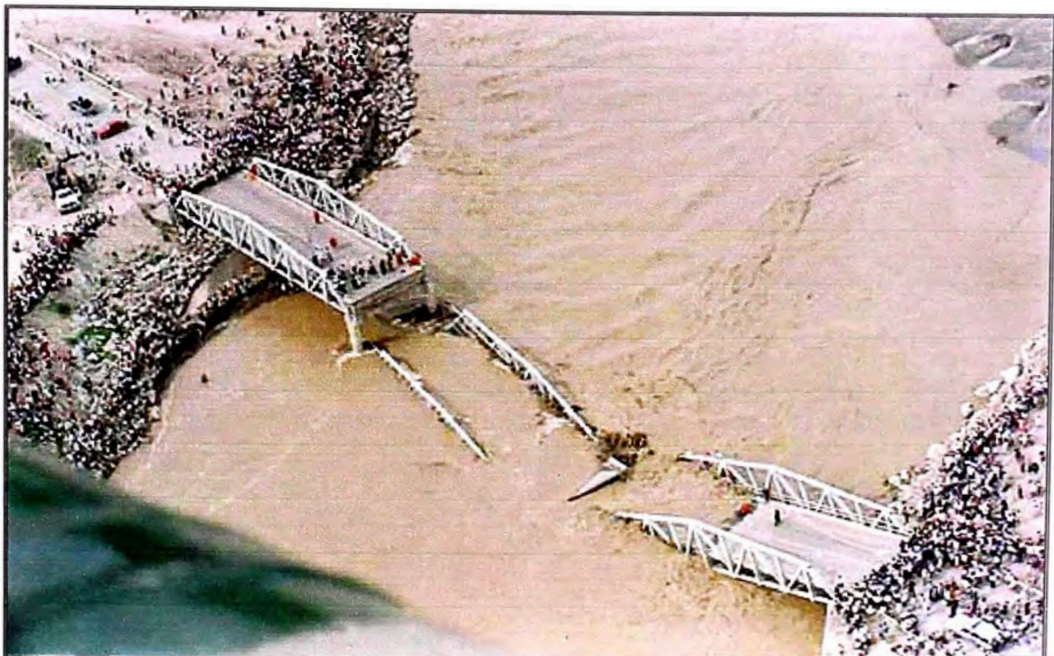
Foto 2: Colapso del Puente Reque antiguo por efectos del fenómeno “EL Niño” en el año 1998, el cual estaba conformado por tres tramos de estructuras metálicas reticuladas tipo MAN de 33 m de largo cada uno.
