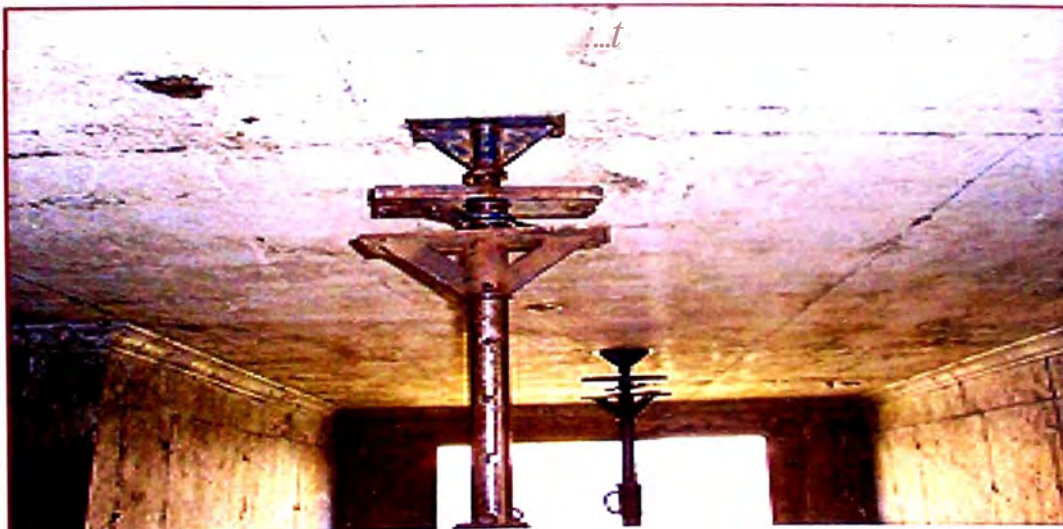
La losa se des.encofra al día siguiente. dejandola apuntalada .
