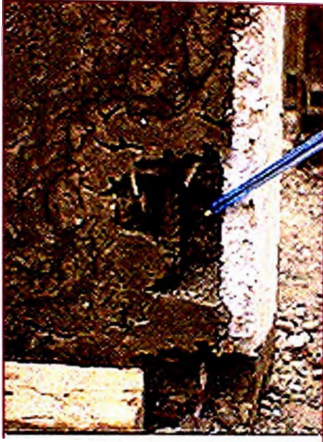
Refuerzo sin recubrimiento por Cangrejera
