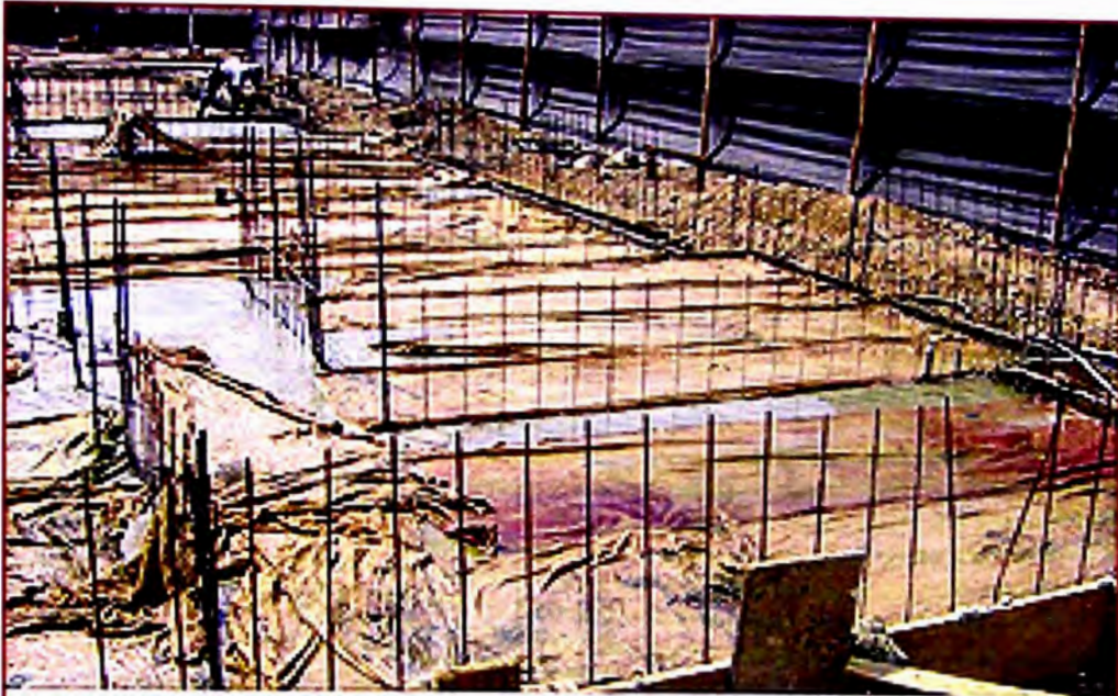
Curado de Platea de Cimentación con agua y yute, por un periodo de 7 días.
