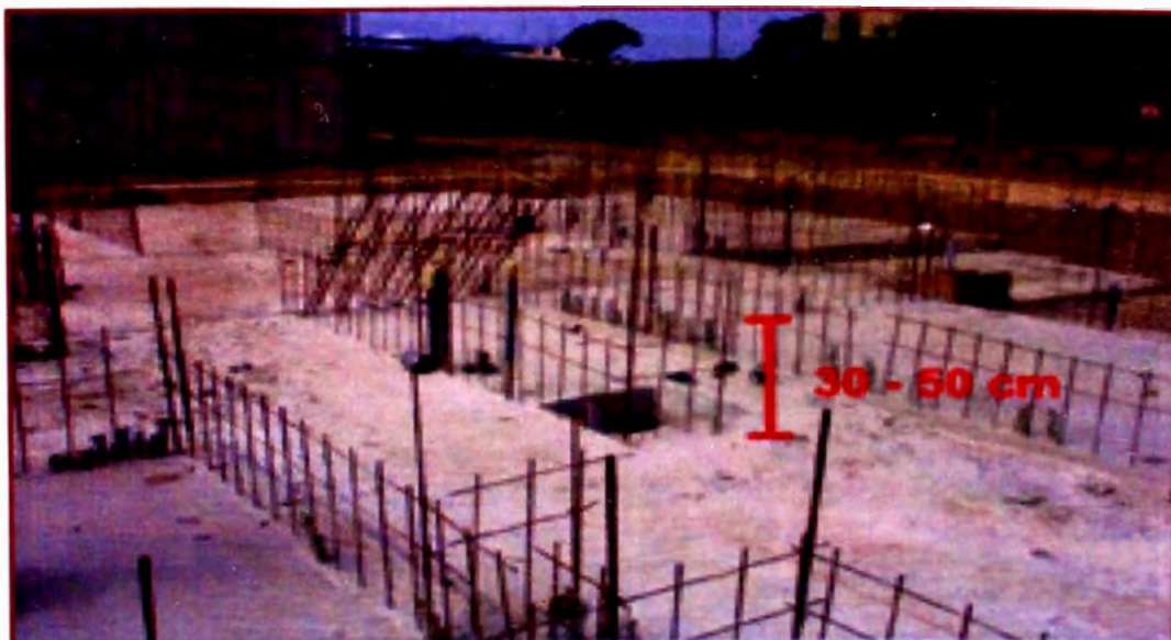
Espigas de Platea de Cimentación
