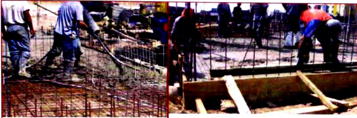
Vaciado de Platea de Cimentación ( f_c = 175 \text{ kg/cm}^2 )
