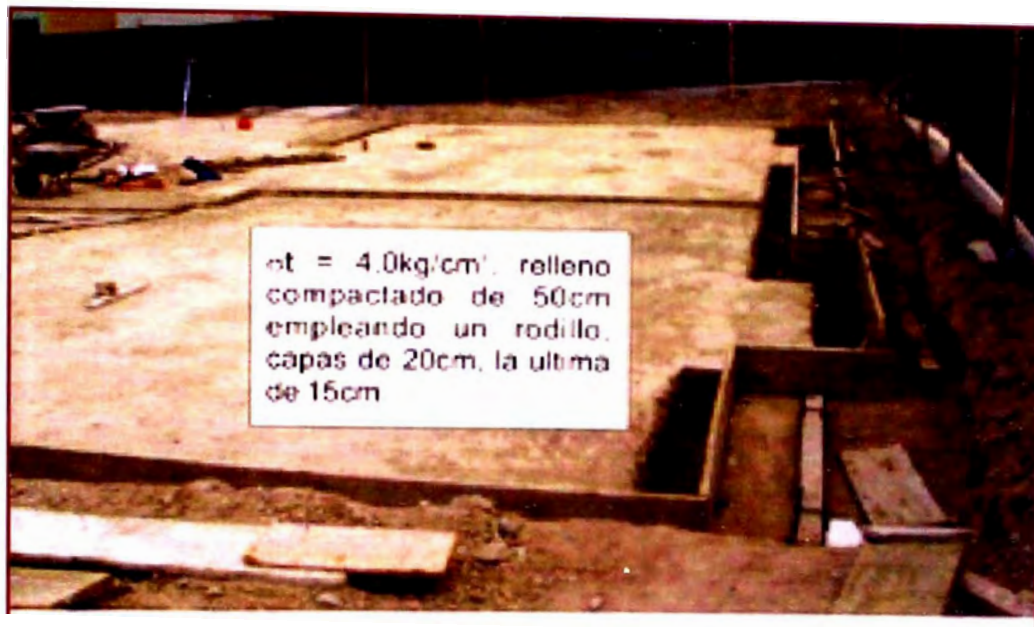
Compactado de Estrato de Cimentación
