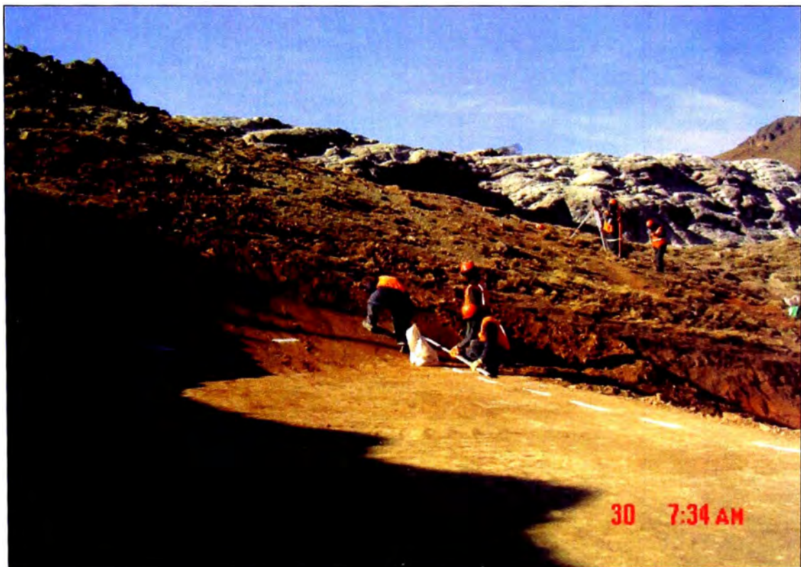
Foto N° 6: Trazo y replanteo para la conformación de siguiente capa de terraplén.
