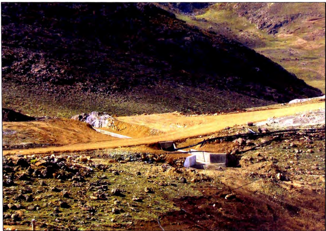
Foto N° 35: Canal vertedero de emergencia terminado. Fecha 15/12/05.
