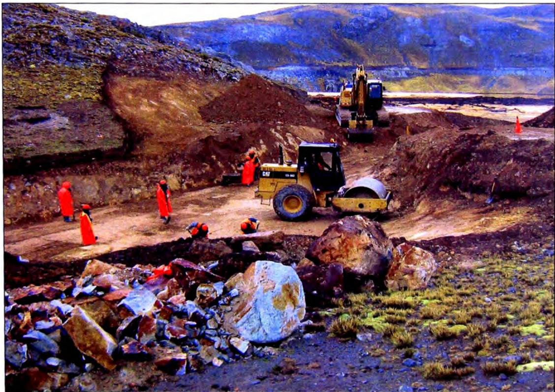
Foto N° 19: Trabajos de conformación y compactación del suelo de cimentación de la Presa Lateral N° 1.
