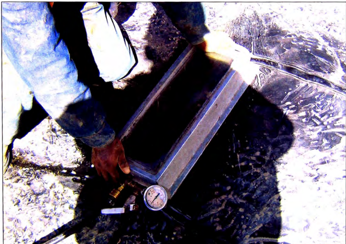
Foto N° 31: Ejecución del ensayo caja de vacío en el extremo de los parches.
