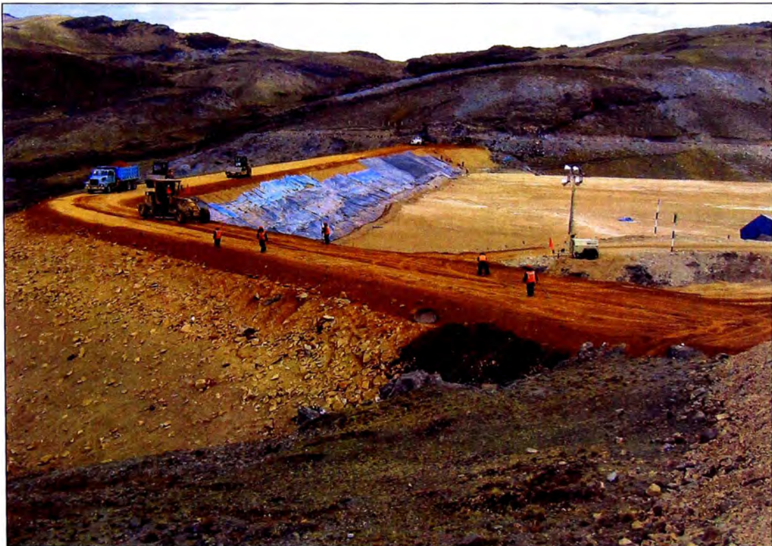
Foto N° 17: Vista panorámica de la Presa Explorador al 30/11/05, véase la compactación de las últimas capas del recrecimiento.
