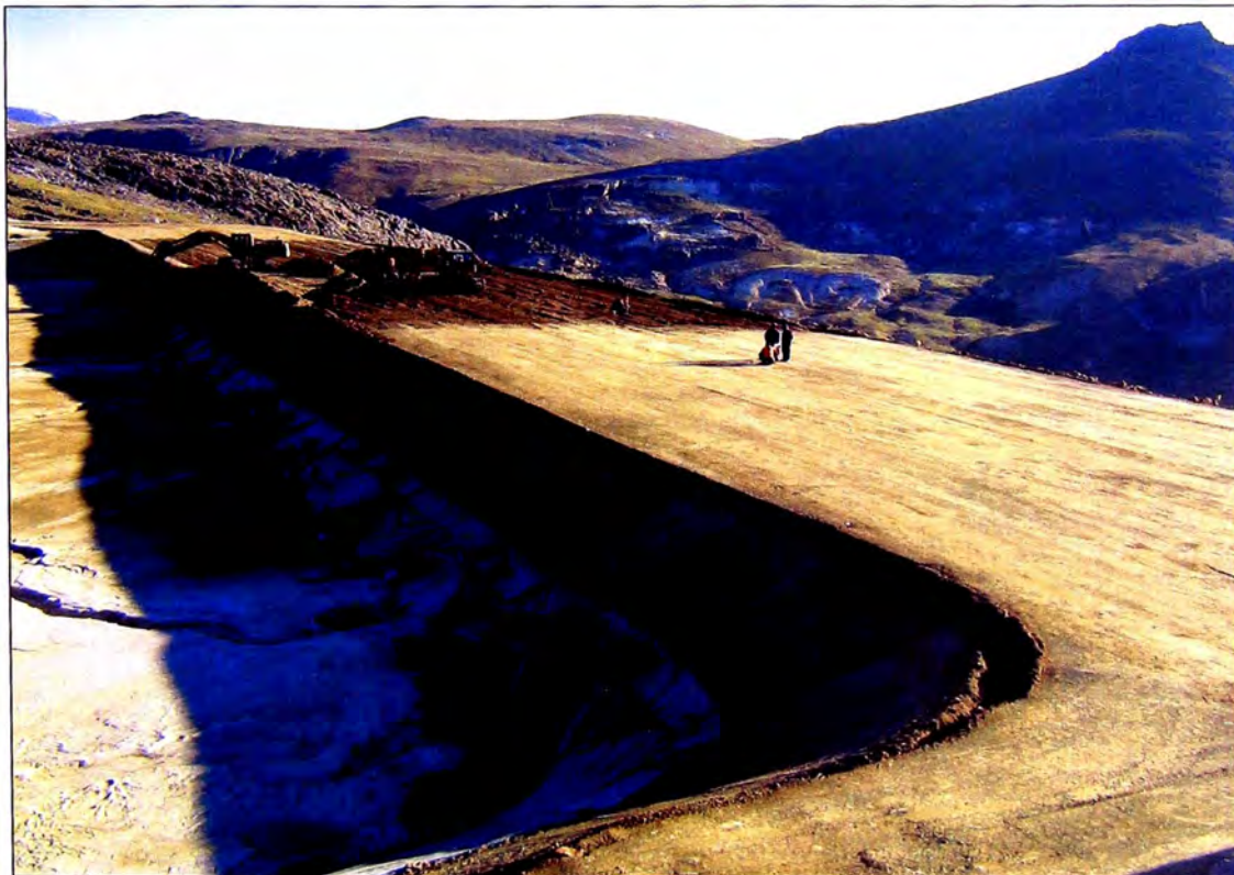
Foto N° 15: Vista panorámica del la Presa Explorador al 23/11/05, véase al fondo el perfilado mecánico del talud aguas arriba de la presa.
