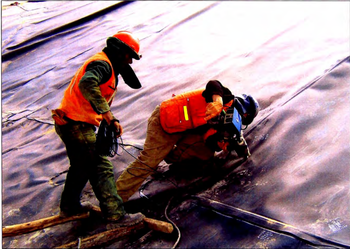
Foto N° 30: Instalación de parches mediante soldadura por extrusión.
