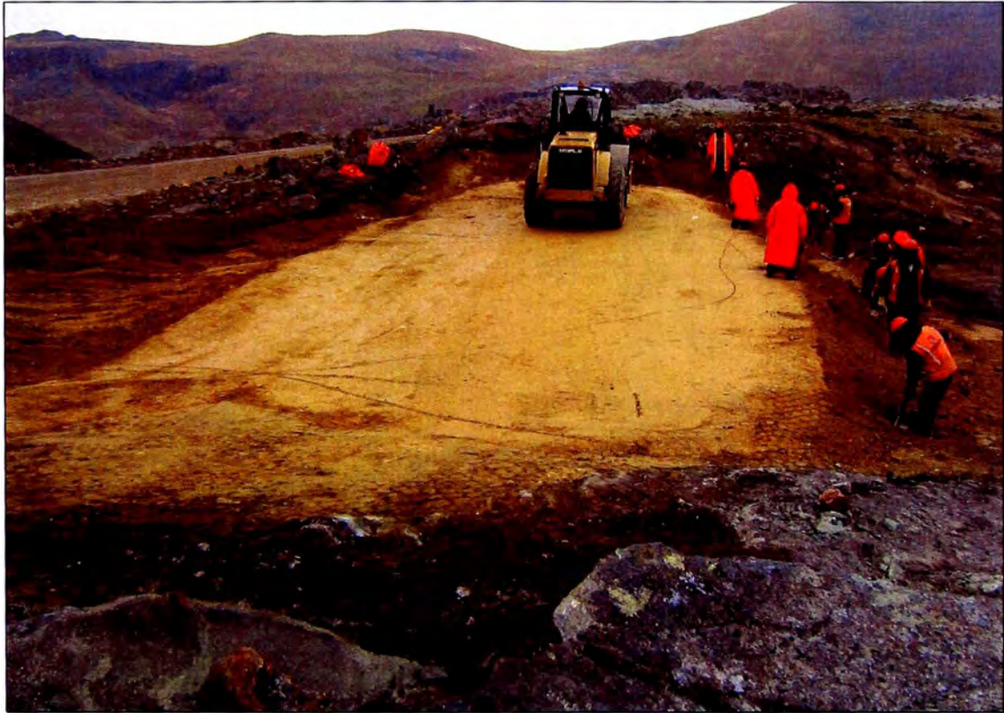
Foto N° 18: Trabajos de conformación y compactación del terraplén de relleno de la Presa Lateral N° 2.
