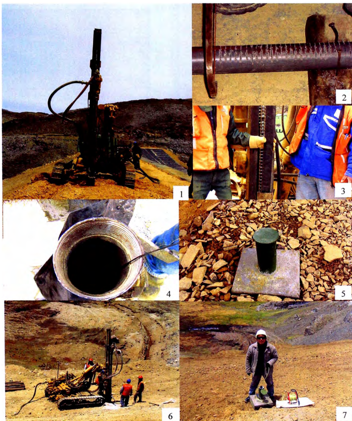
Foto N° 27: Instalación de los piezómetros de tubo abierto PZ-01 y PZ-02. 1. Perforación para la instalación del piezómetro PZ-01. 2. Tubería de PVC de \varnothing = 2'' ranurada cada 1 cm. 3. Instalación del piezómetro PZ-01. 4. Tubería de PVC de \varnothing = 2'' y tubería Casing de 5". 5. Piezómetro PZ-02 instalado totalmente. 6. Perforación para la instalación del piezómetro PZ-01. 7. Medición del nivel freático en el piezómetro PZ-02.
