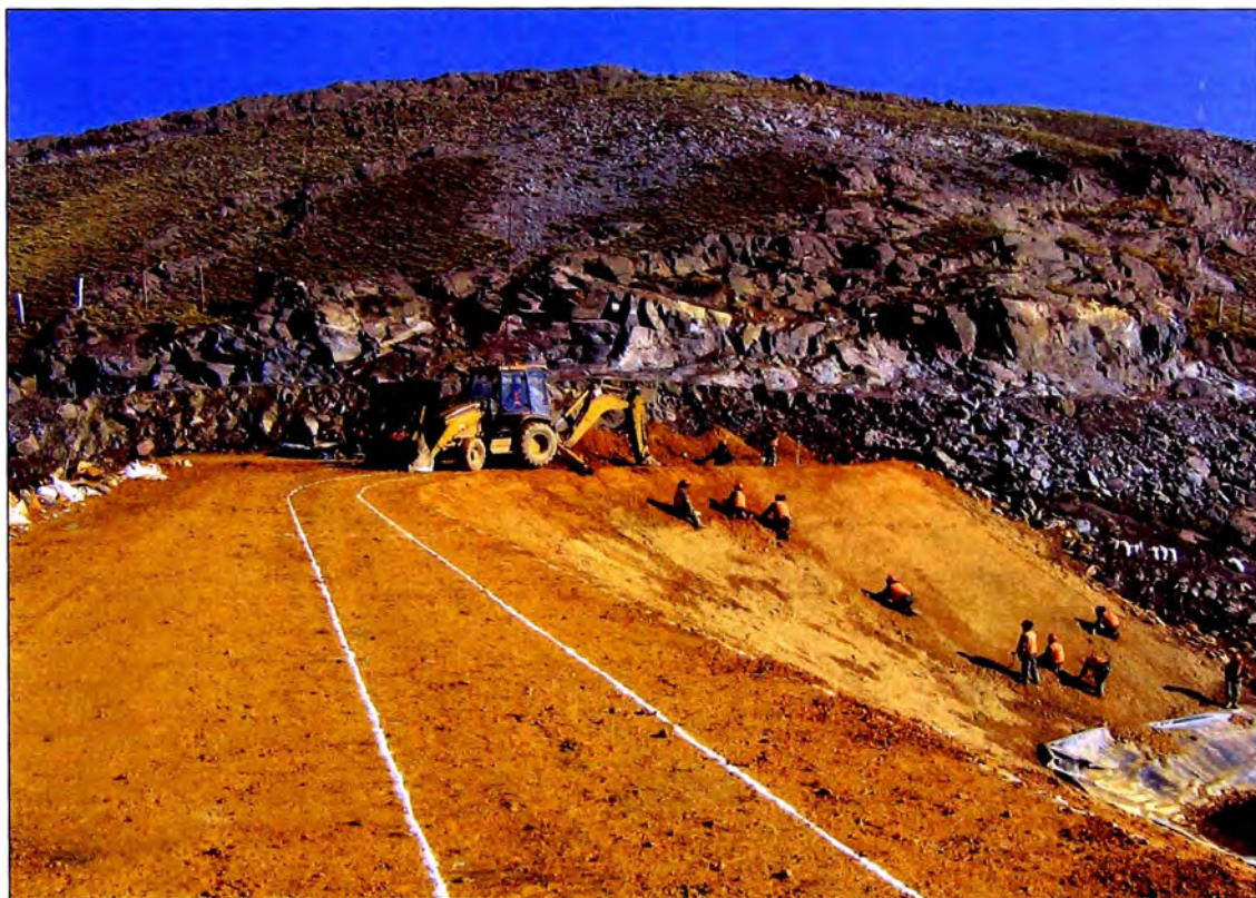
Foto N° 23: Excavación de la zanja de anclaje de la geomembrana en la cresta y trabajos de limpieza, rastrillado y eliminación de todo material punzo-cortante de la superficie del talud de aguas arriba de la Presa Explorador.
