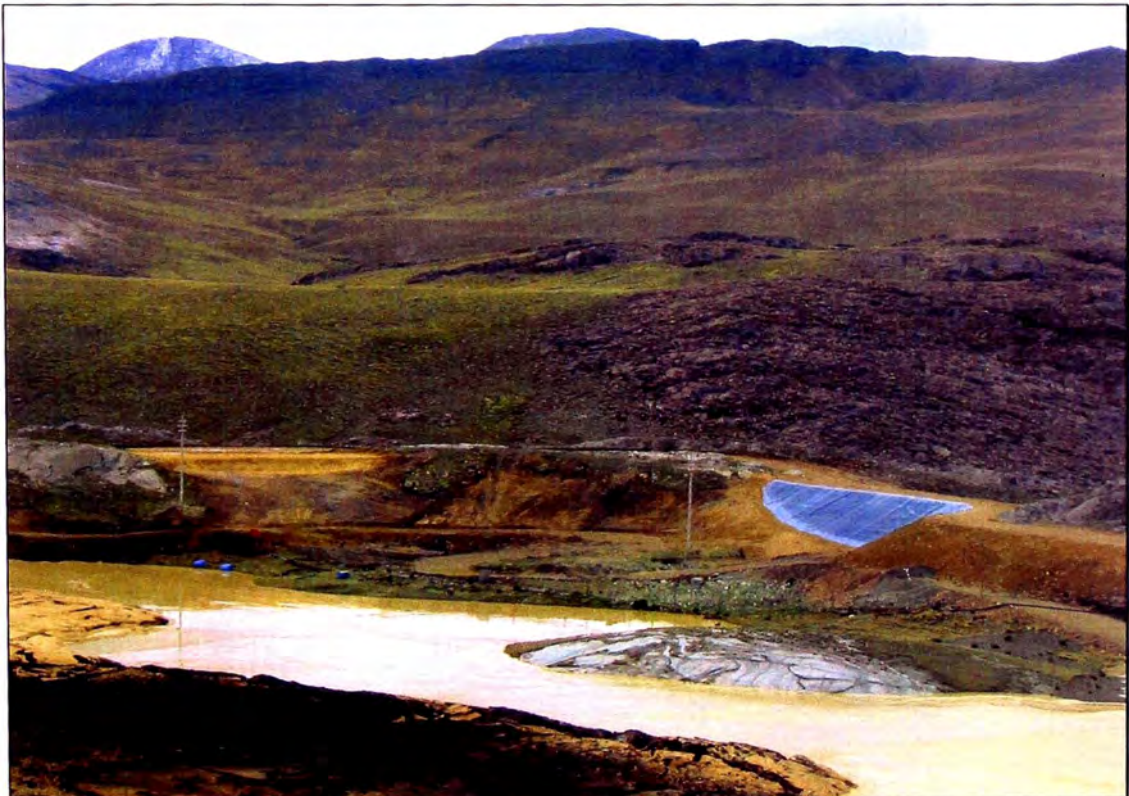
Foto N° 33: Presas Laterales N° 1 y 2 terminadas al 15/12/05.
