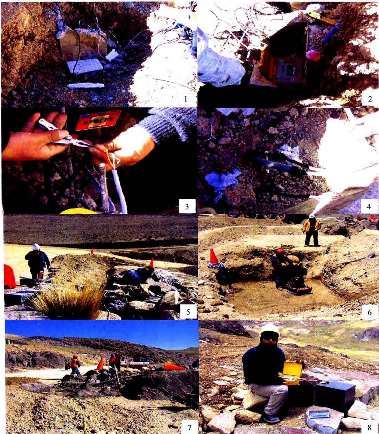
Foto N° 9: Extensión de los cables de los piezómetros de cuerda vibrante ubicados aguas abajo de la Presa Explorador.
