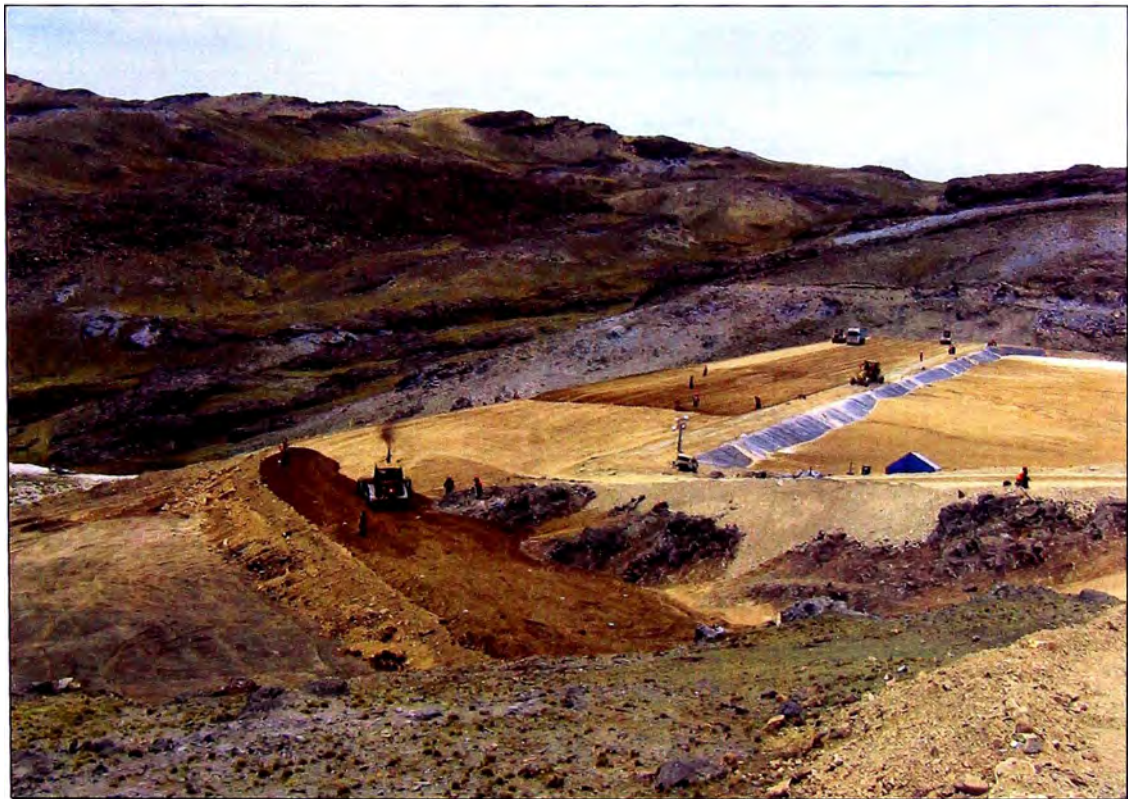
Foto N° 13: Vista panorámica de la Presa Explorador al 18/11/05. Obsérvese los trabajos de conformación para el desarrollo de la curva del recrecimiento.
