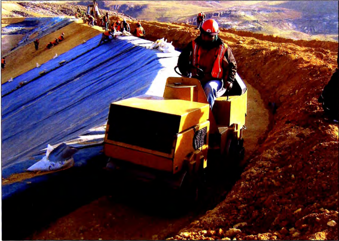
Foto N° 25: Compactación del relleno de la zanja de anclaje de la geomembrana, Presa Explorador.
