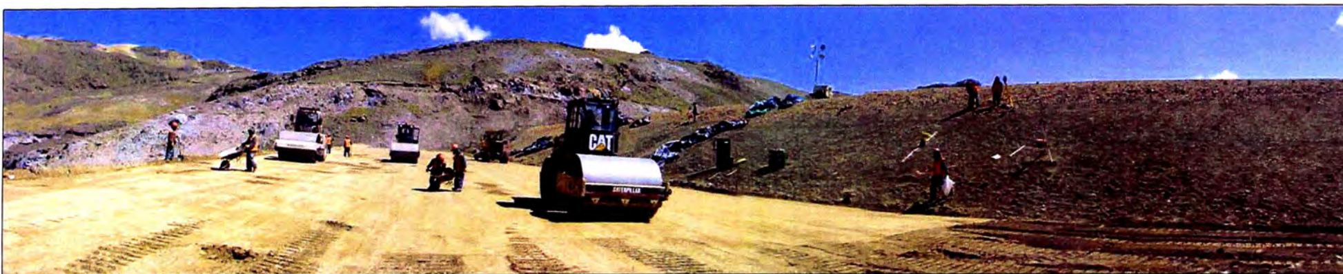
Foto N° 10: Terraplén del recrecimiento de la Presa Explorador al 04/11/05.
