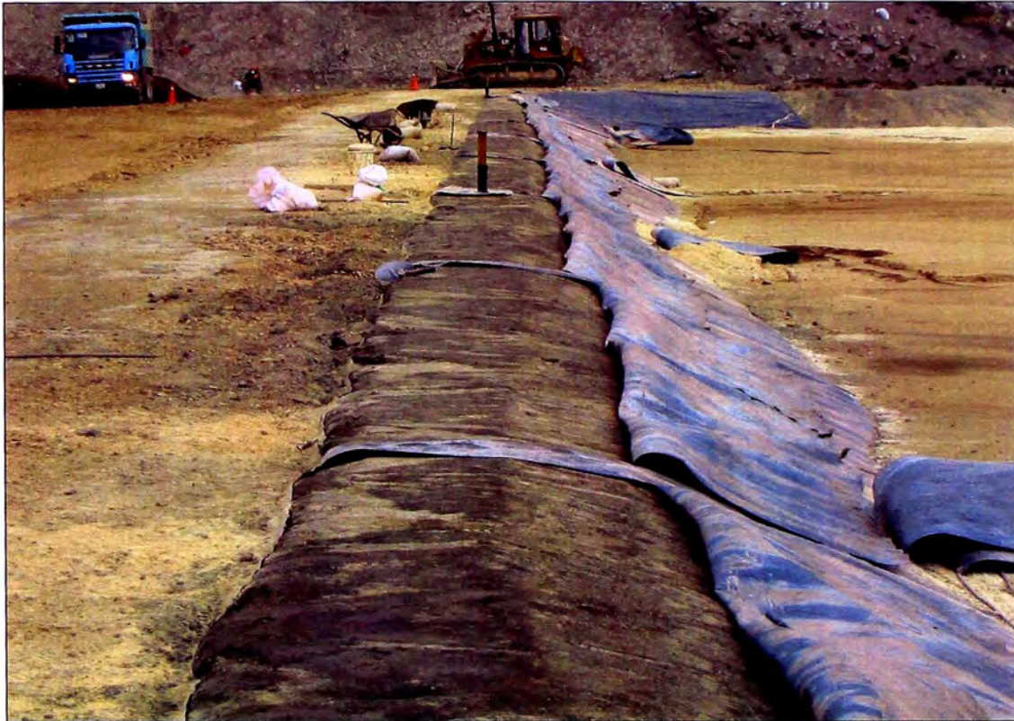
Foto N° 14: Geomembrana HPDE existente cortada y anclada en el talud de aguas arriba de la Presa Explorador.
