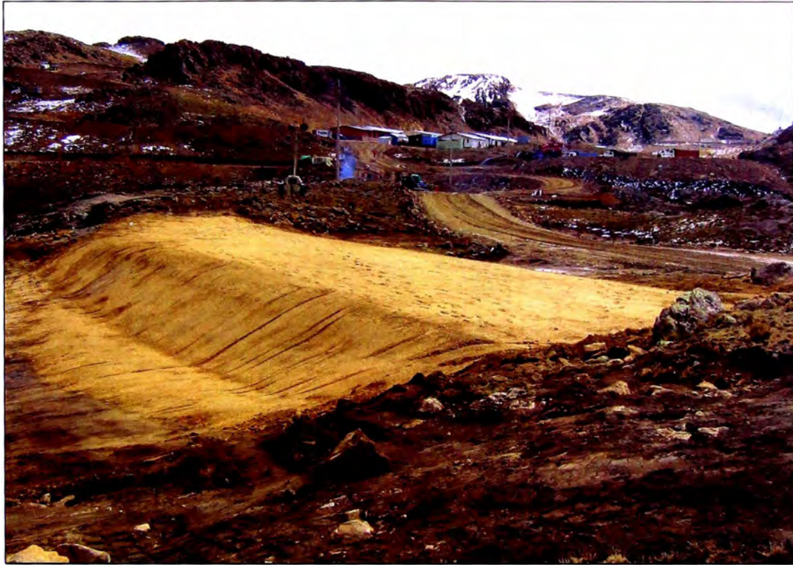
Foto N° 20: Presa Lateral N° 2 terminada. Cota de cresta 4568.0 msnm.
