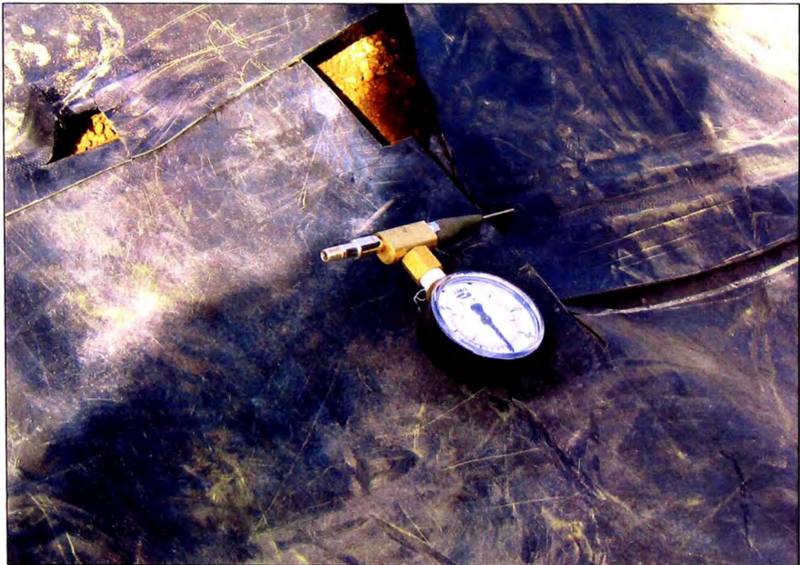
Foto N° 26: Ejecución del ensayo de presión de aire en el canal intermedio de la soldadura de doble cuña caliente.
