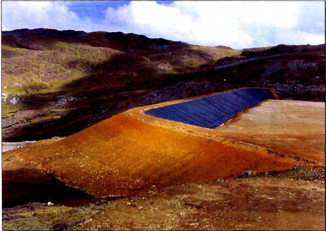
Foto N° 34: Recrecimiento de la Presa Explorador. Fecha 15/12/05.
