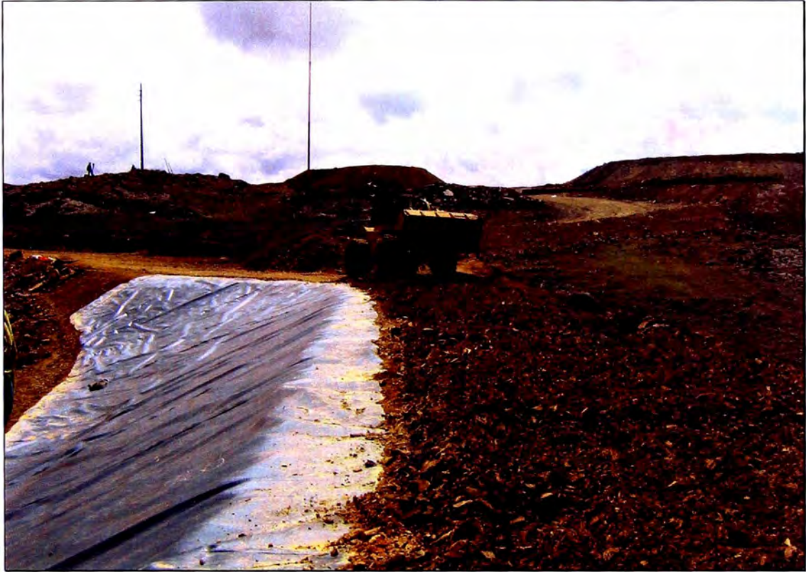
Foto N° 32: Colocación de la capa de rodadura sobre la cresta de la Presa Explorador.
