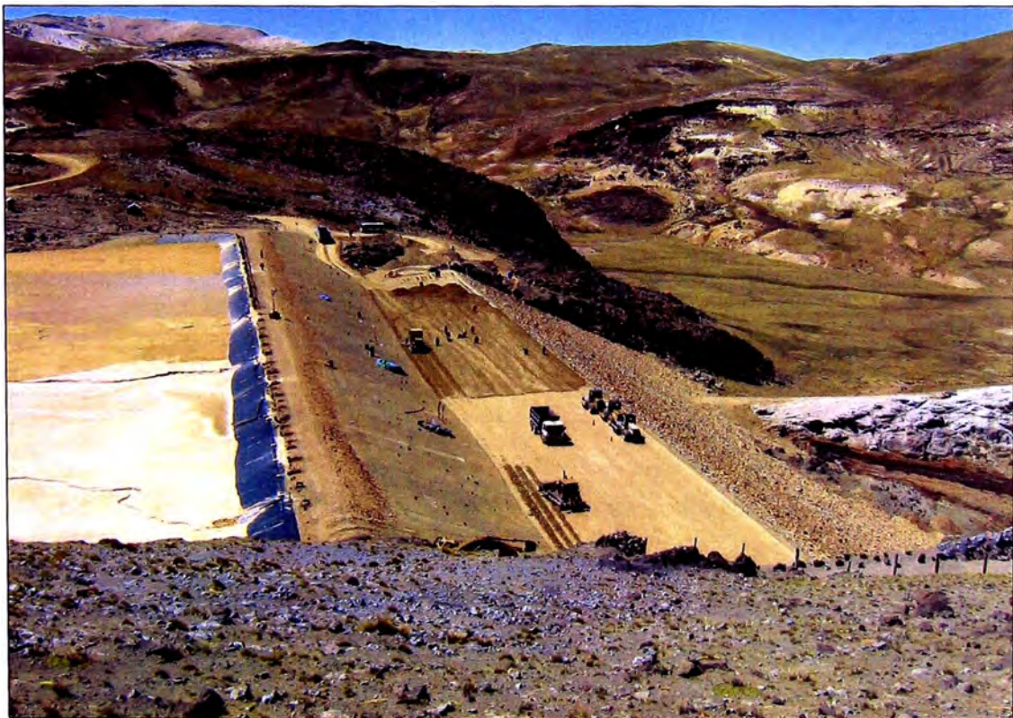
Foto N° 8: Vista panorámica del recrecimiento de la Presa Explorador al 01/11/05.
