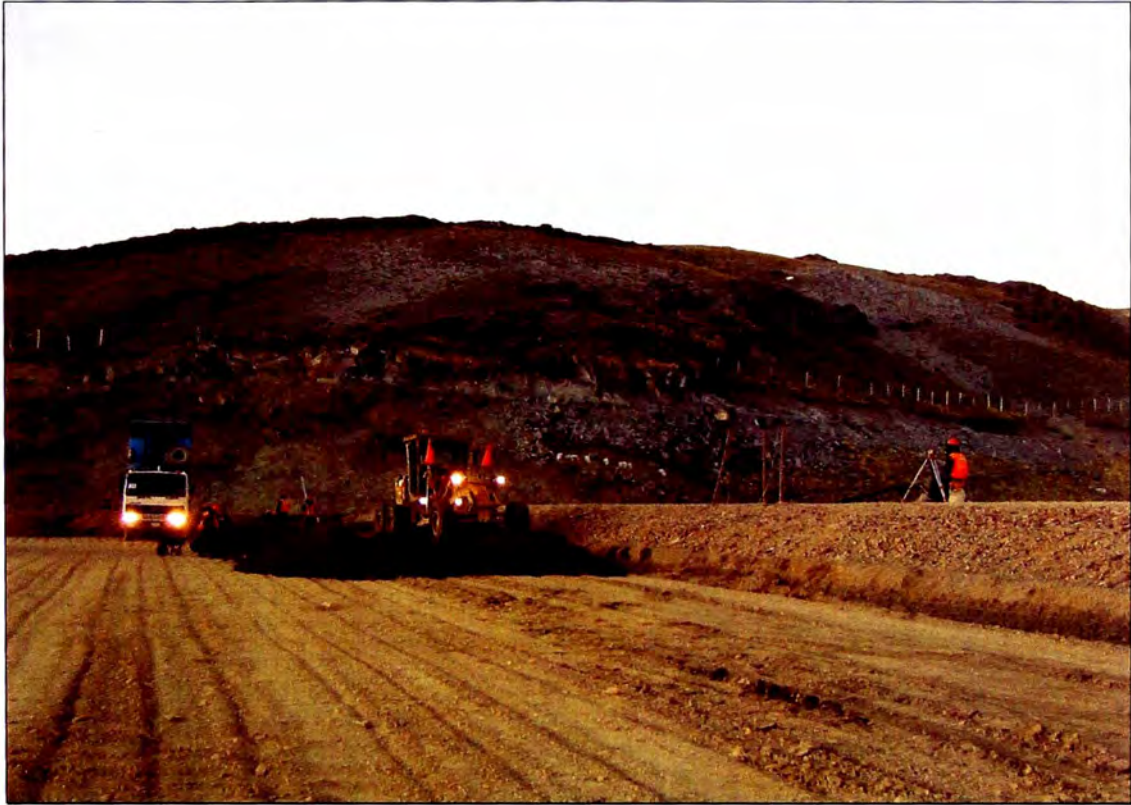
Foto N° 12: Recrecimiento de la Presa Explorador al 16/11/05.
