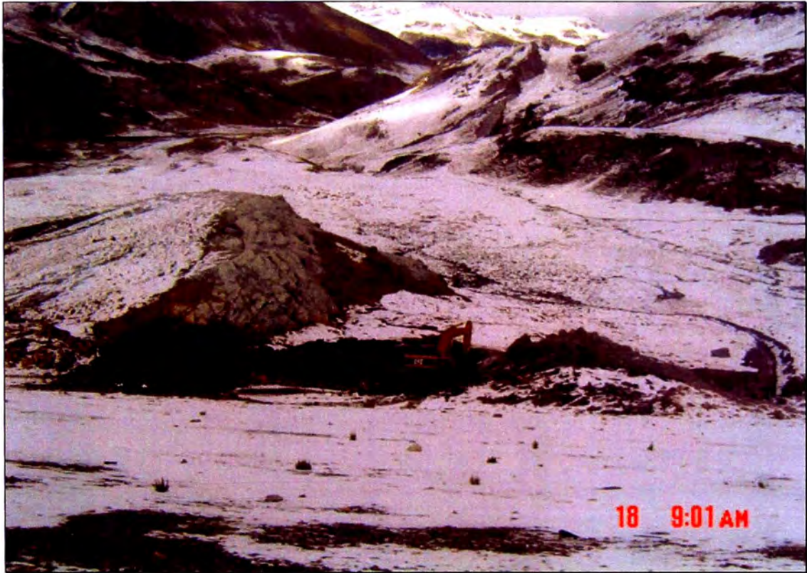
Foto N° 1: Inicio de la obra. Vista panorámica de la excavación del Top Soil (material orgánico), al pie de talud aguas abajo de la Presa Explorador, entre las prog. 0+110 a 0+135 aproximadamente.
