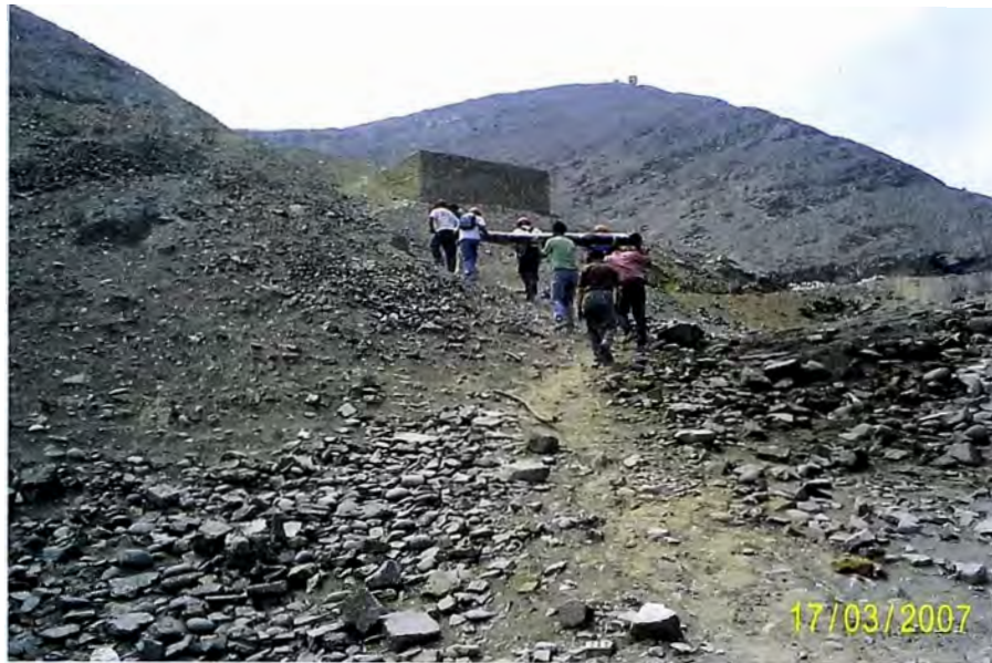
FOTO 7.- TRANSPORTANDO LA GEOMEMBRANA A LA ZONA DE TRABAJO, ESTA SI ES MAS PESADA.
