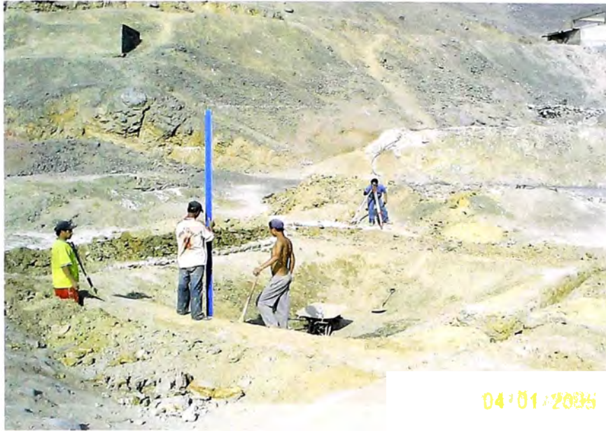
FOTO 3.- NIVELACION Y FERFILADO DEL DEPÓSITO
