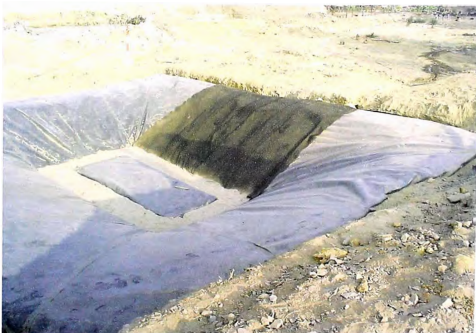
FOTO 14.- DEPÓSITO DE RELAVES EN SU ETAPA FINAL DE CONSTRUCCIÓN (CONFORMADO POR: CAPA DE GEOTEXTIL, SEGUIDAMENTE DE OTRA CAPA DE GEOMEMBRANA Y PARA EL DRENAJE SE OBSERVA EL GEODREN)
