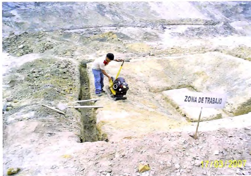
FOTO 4.- COMPACTACIÓN DEL TERRENO
