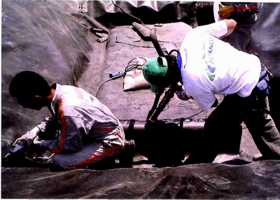
FOTO 11.- EN PLENA INSTALACIÓN DE LA GEOMEMBRANA
