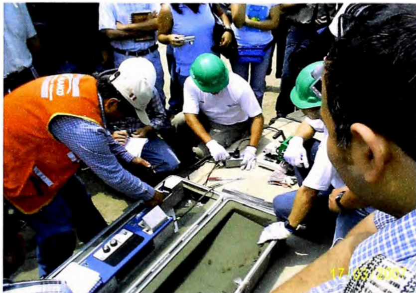
FOTO 8.- PRUEBAS DE CAMPO QUE SE REALIZAN ANTES DE EMPEZAR A INSTALAR LOS MATERIALES (EQUIPO: TENSIOMETRO)
