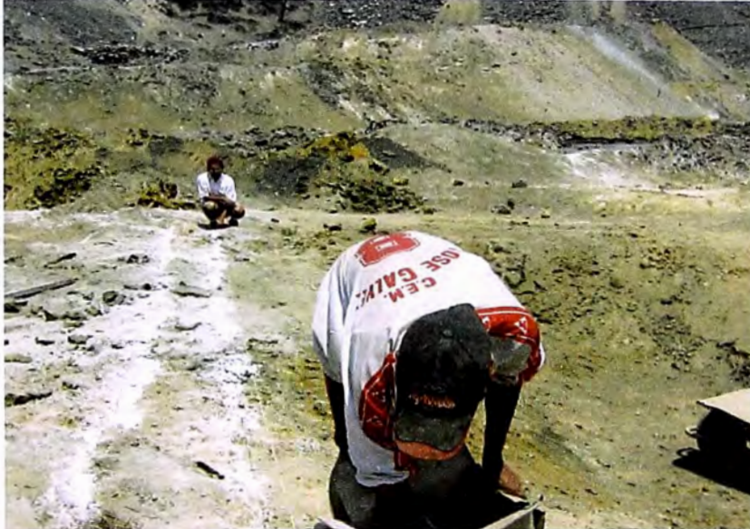
FOTO 1.- TRAZO Y MARCADO DE EJES DEL DEPÓSITO
