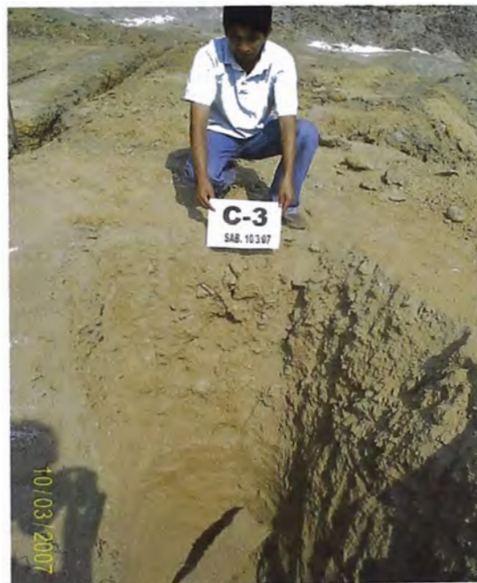
Figura 4.11.- Vista de Calicata C-3
