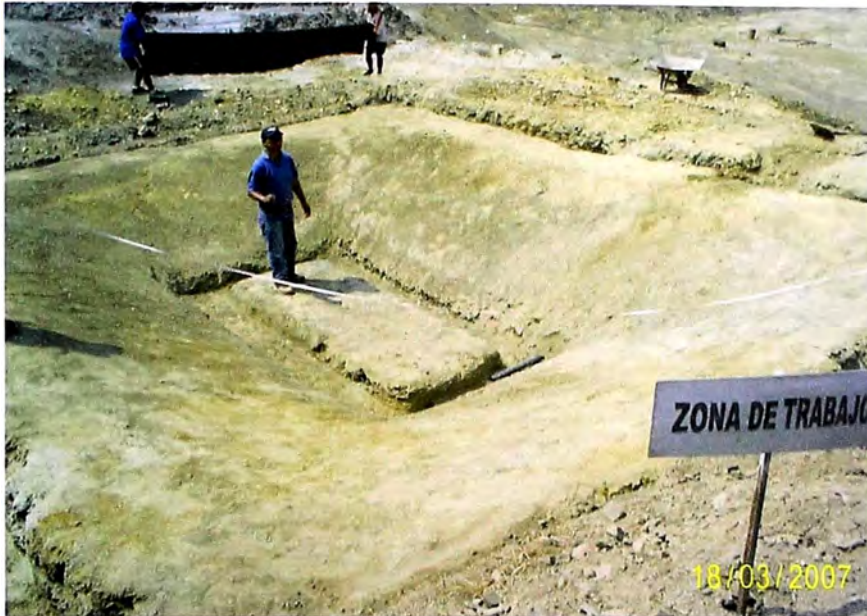
FOTO 9.- INSPECCION DE LA ZONA DE TRABAJO ANTES DE COLOCAR EL GEOTEXTIL (TIENE QUE ENCONTRARSE LIMPIO DE OBJETOS QUE PUEDAN DAÑAR EL GEOTEXTIL)
