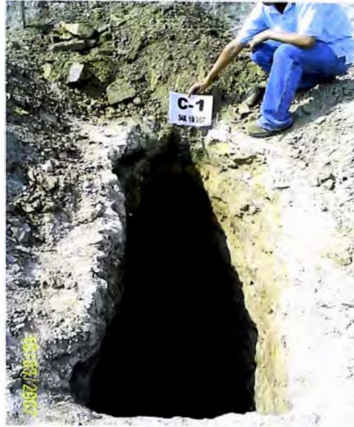
Figura 4.9.- Vista de Calicata C-1
