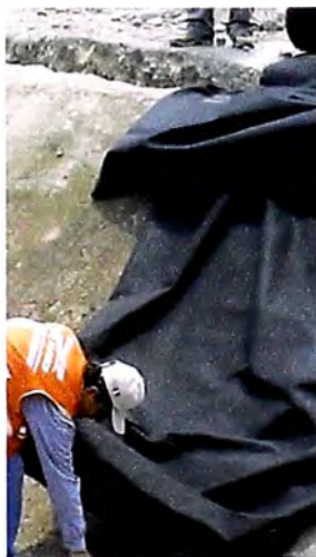
Figura 2.3.- Vista del geotextil no tejido
