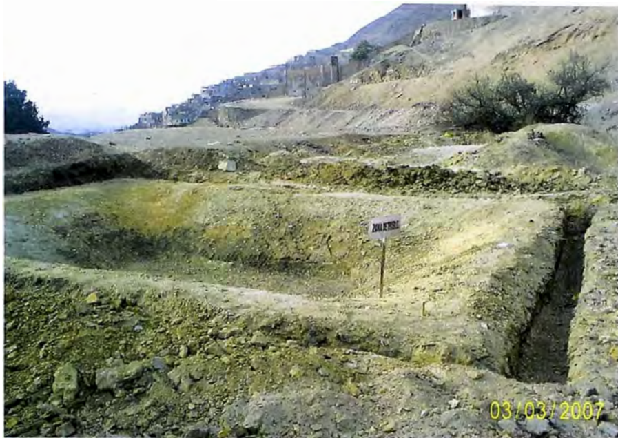
FOTO 5.- DEPÓSITO PERFILADO Y PREPARADO PARA LA INSTALACIÓN DEL GEOTEXTIL
