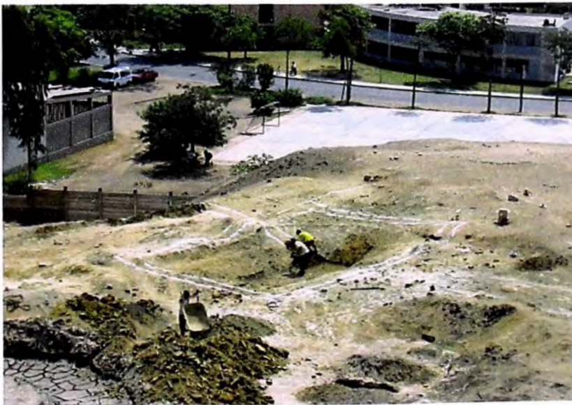
FOTO 2.- EXCAVACION DE ZANJAS
