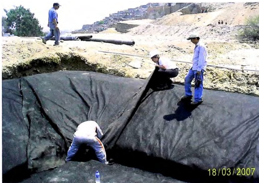
FOTO 10.- EN PLENA INSTALACIÓN DEL GEOTEXTIL
