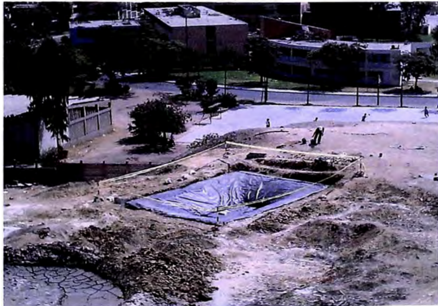
FOTO 12.- VISTA PANORAMICA DEL DEPOSITO DE RELAVES CON LA GEOMEMBRANA YA INSTALADA.
