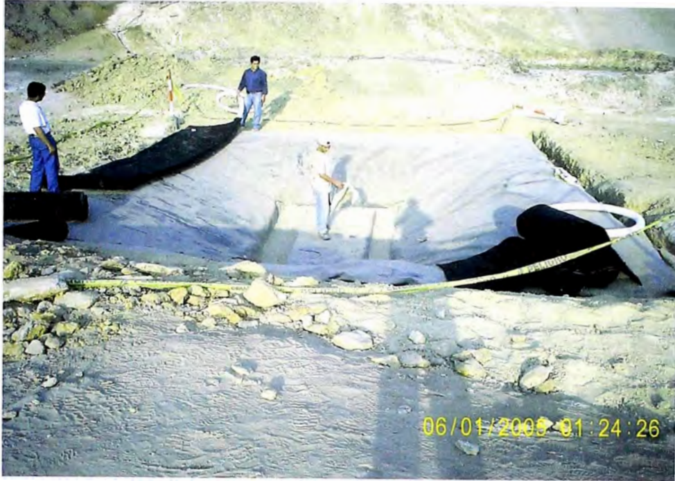
FOTO 13.- PREPARANDO EL GEOCOMPUESTO (GEODREN) PARA SU POSTERIOR INSTALACIÓN.
