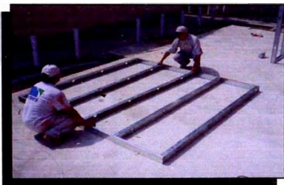
Figura 3.13. Se arman paneles uniendo parantes y rieles, luego de lo cual se anclan a la losa y se unen entre sí.
