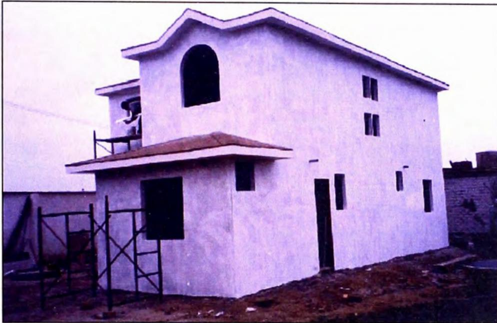
Foto A: Colocación completa de los paneles secos de Vivienda en Villa
