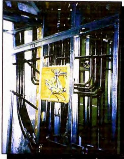
Foto 2.3: Se evita el picado de muros que sucede con otros sistemas; al colocar las tuberías de todos los sistemas proyectados antes de terminar de emplacar.
