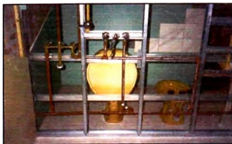
Figura 3.17: Estructura y entubado en zona de Baño
