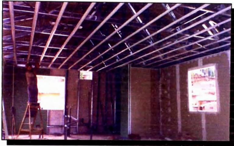
Figura 3.20 Techo a dos aguas con cobertura Perfil 4 Eternit
