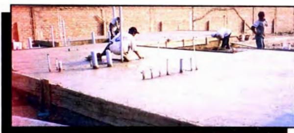
Figura 3.8. Sobre una losa de concreto se ancla la estructura de la edificación.
