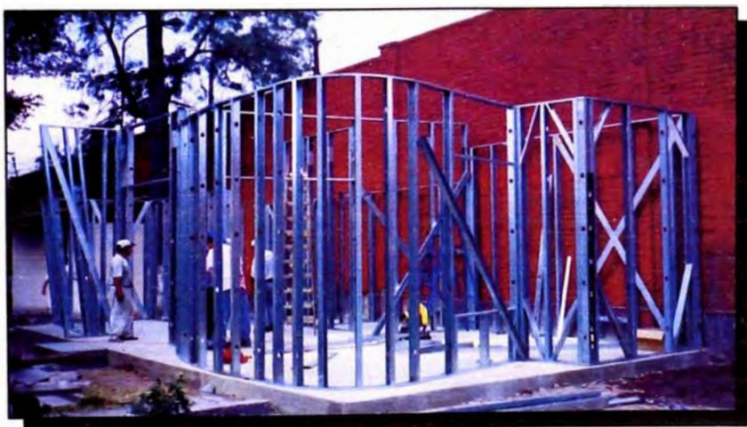
Figura 3.14. Se utilizan parantes de 0.90mm de espesor. Para los muros portantes, deben considerarse arriostres diagonales.
