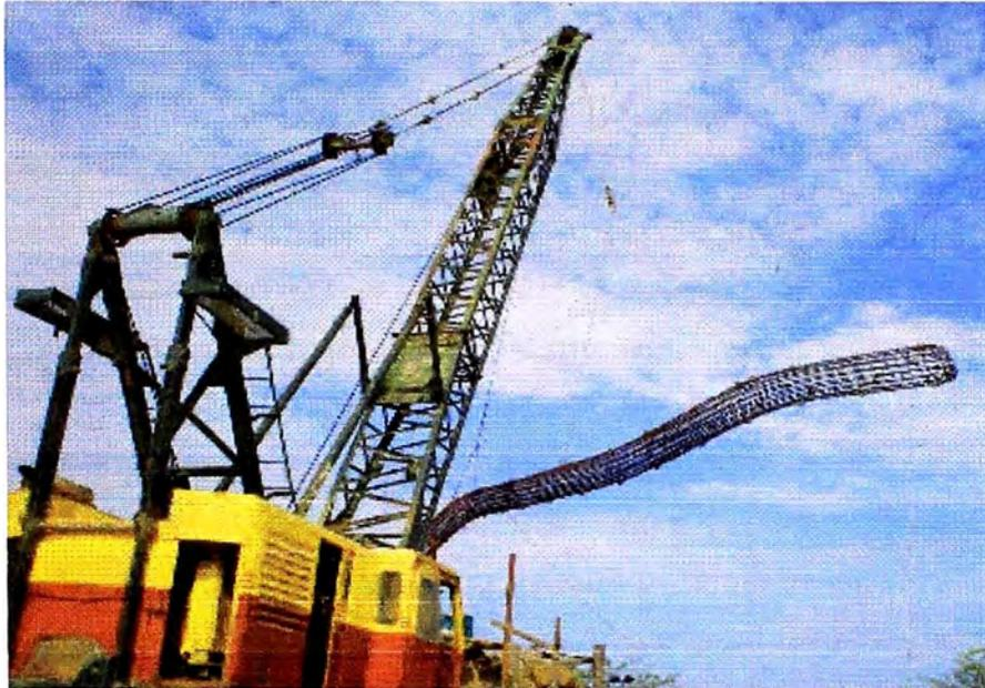
Fotografía VI-7: Maniobras de izaje para la colocación del acero de refuerzo al interior de la excavación del pilote.
