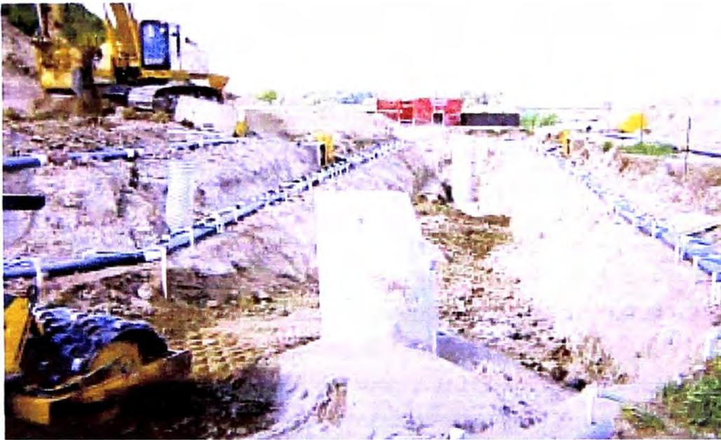
Fotografía II-5: Plataforma de pilotaje utilizando el método de "Dewatering"
