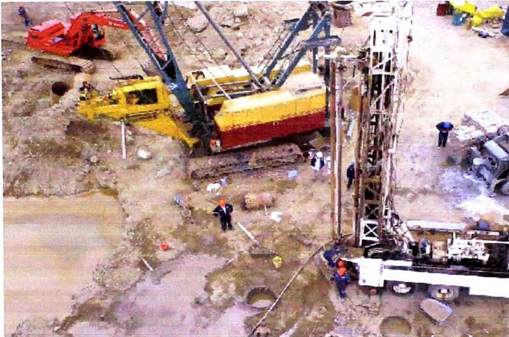
Fotografía III-12: Equipo de perforación Drill Tech en proceso de excavación.
