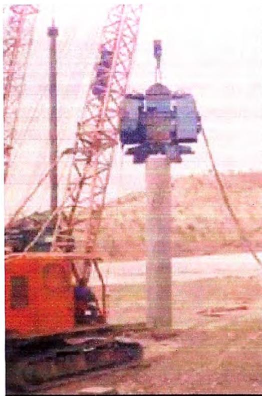
Fotografía II-7: Excavación con entubación recuperable.
