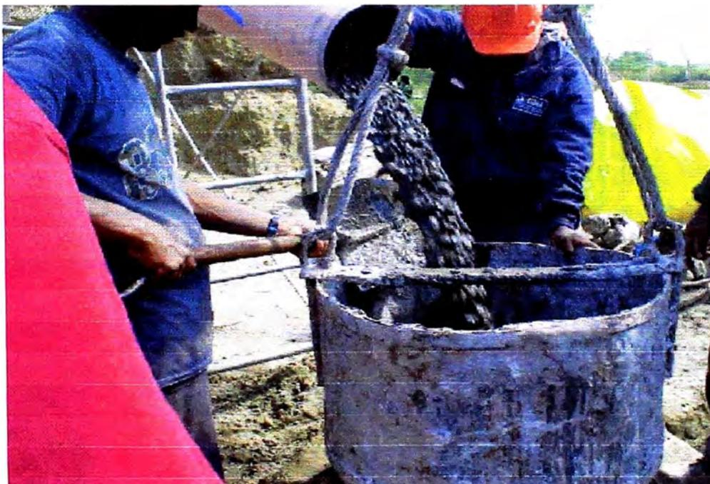
Fotografía VI-12: Proceso vaciado de concreto.
