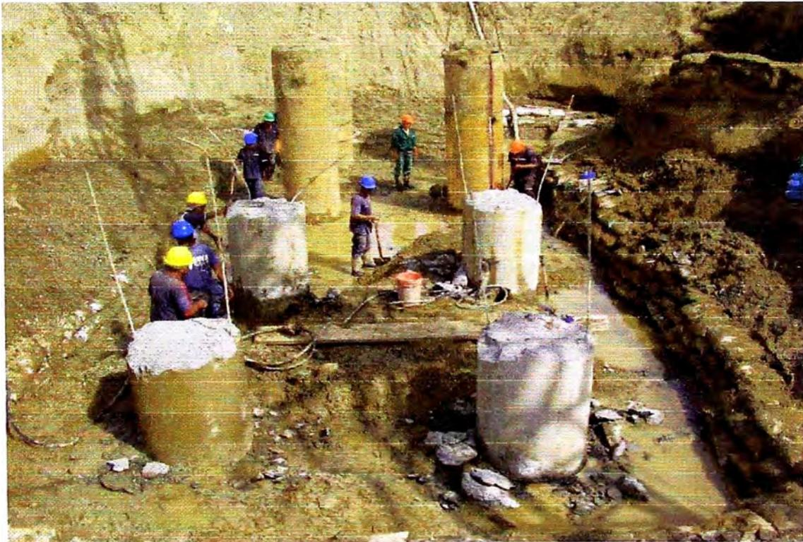
Fotografía VI-13: Proceso de descabezado de pilotes con la ayuda de martillos neumáticos.
