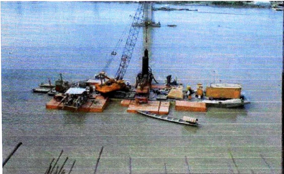
Fotografía VI-15: Plataforma de excavación de Pilotes en Agua
