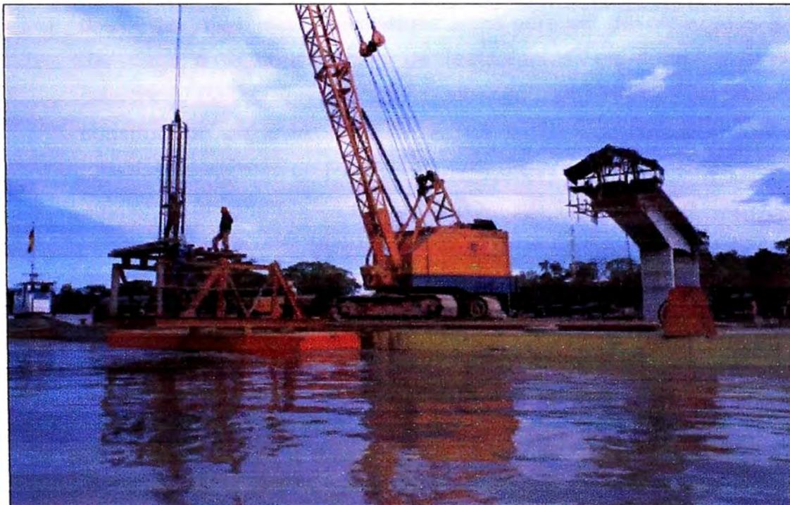
Fotografía II-4: Plataforma de excavación para Pilotes en Agua
