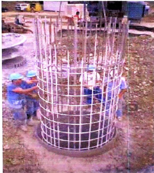
Fotografía II-6: Excavación con entubación perdida.
