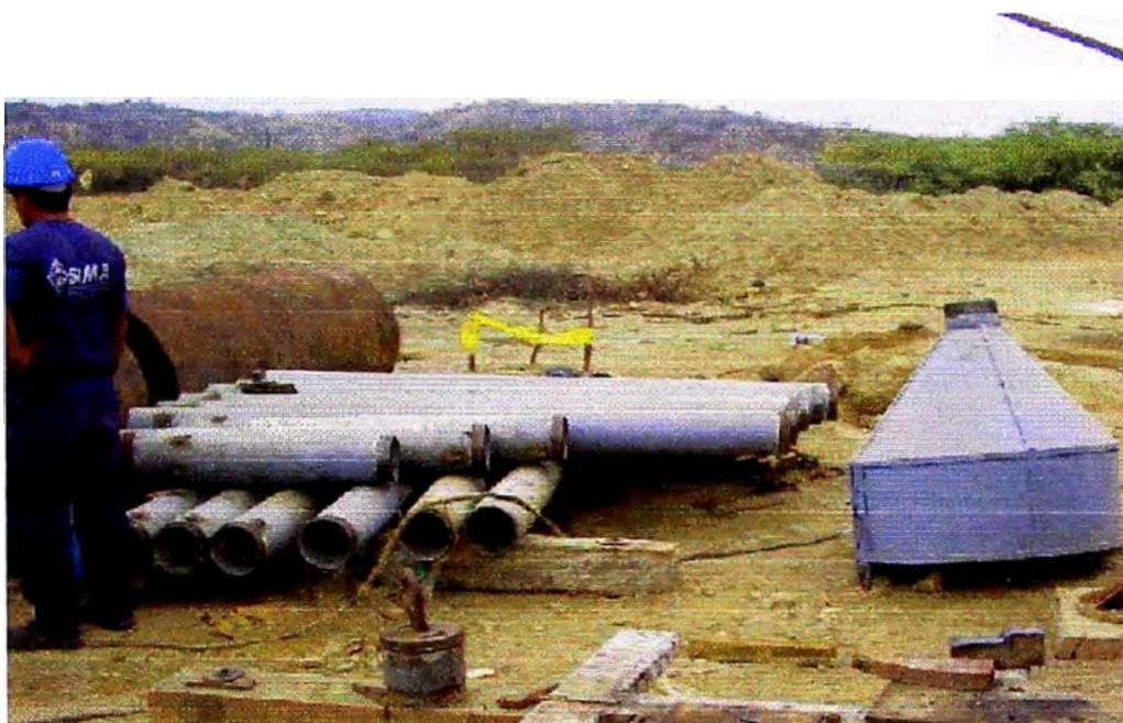
Fotografía VI-9: Conjunto de accesorios para el vaciado. Campana y tubería "Tremie".
