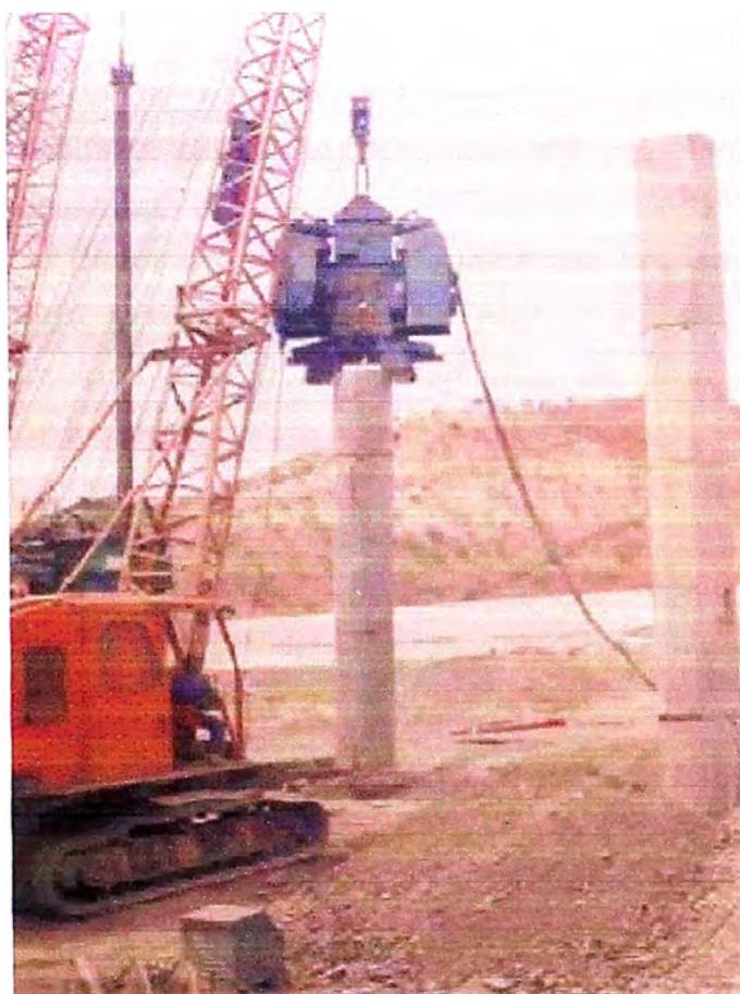
Fotografía III-8: Acople vibratorio para entubar
