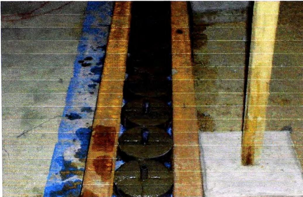
Fotografía VI-4: Fabricación de discos para separadores de refuerzo de corte o "sunchos".
