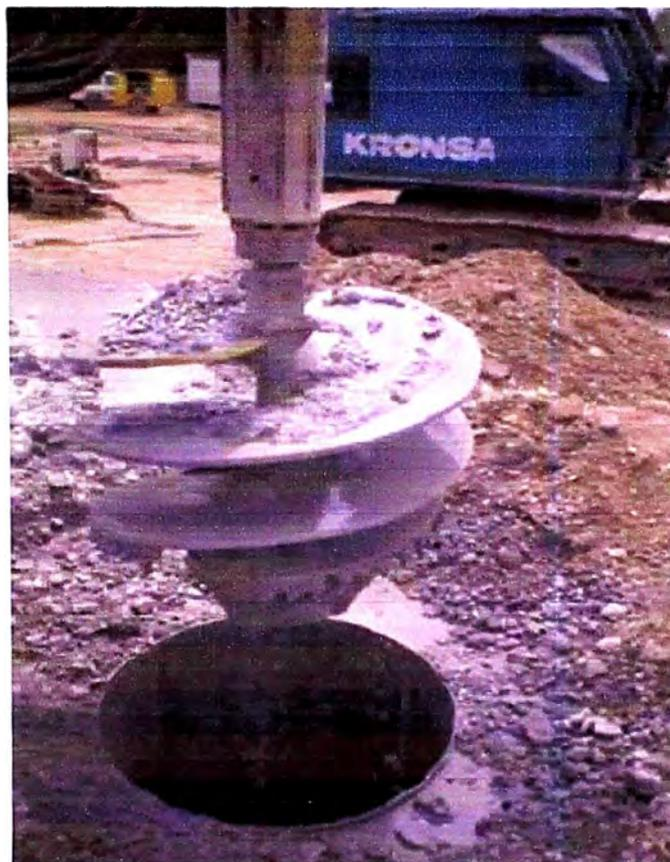
Fotografía III-4: Hélice de perforación.
