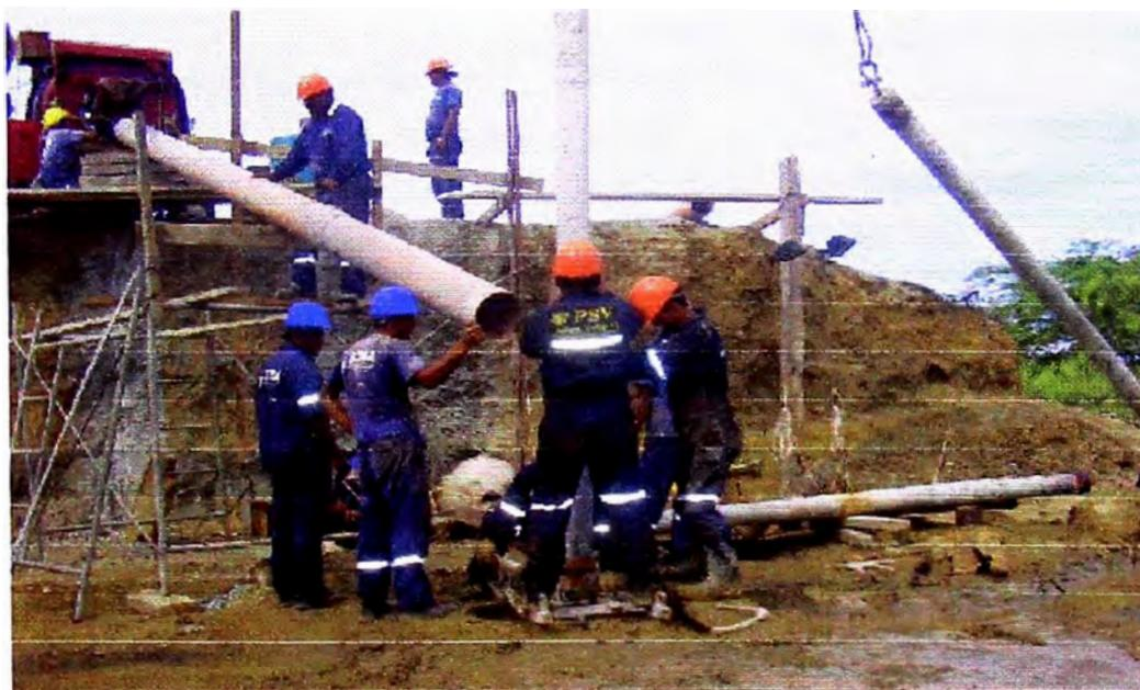
Fotografía VI-10: Proceso vaciado en donde se va retirando la tubería "Tremie".
