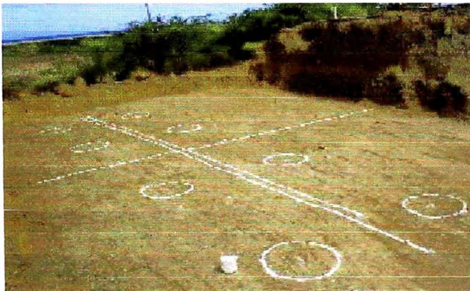
Fotografía VI-14: Plataforma de excavación de Pilotes sobre terreno natural
