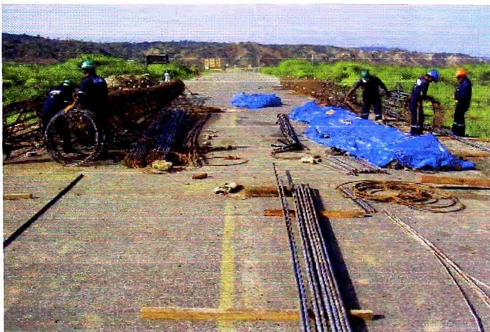
Fotografía VI-6: Armado de las canastillas de acero de refuerzo.
