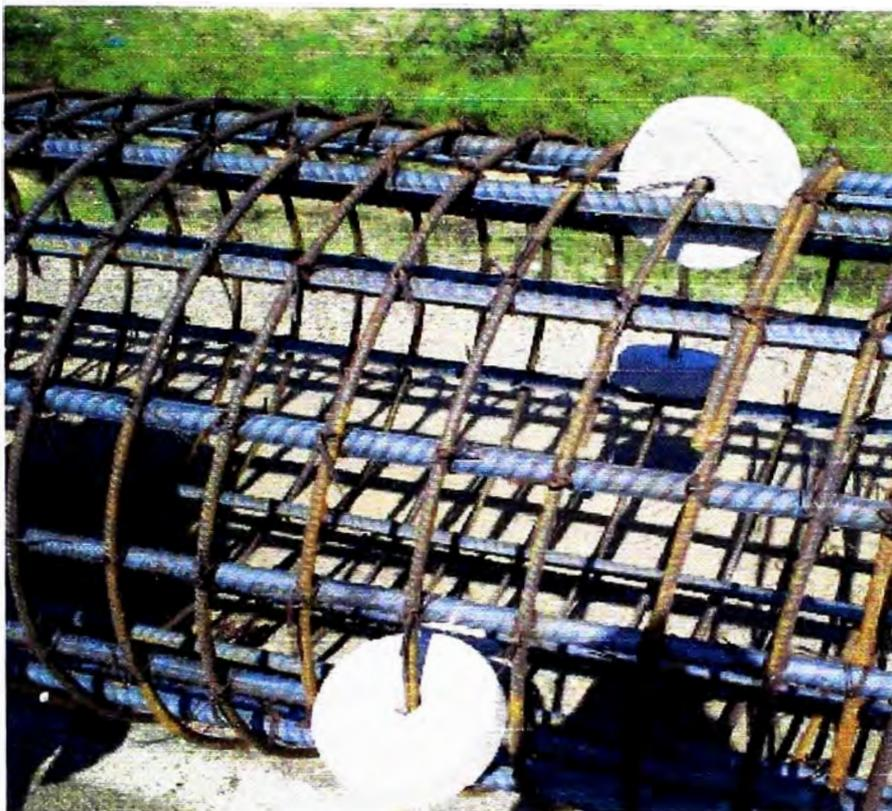
Fotografía VI-5: Disposición de los separadores en el refuerzo.
