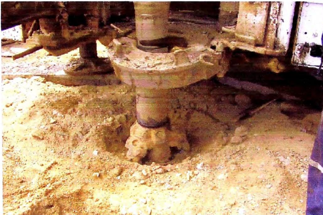
Fotografía III-11: Equipo de perforación Drill Tech iniciando la excavación.
