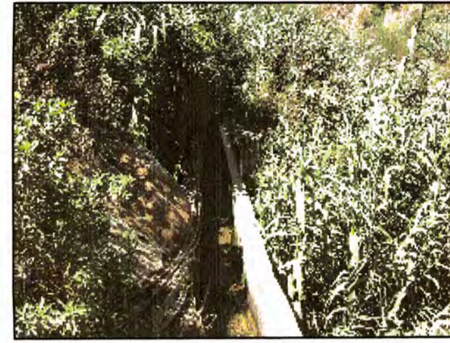
CANAL PRINCIPAL N° 1
