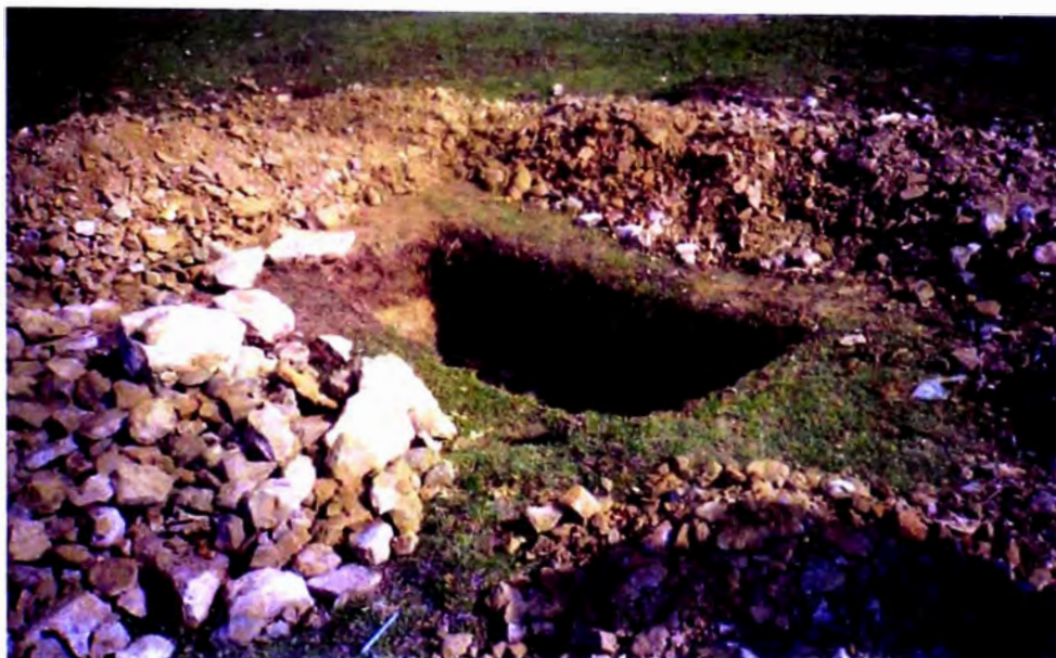
Foto 1 Excavación de calicata. Se muestra la naturaleza compacta del material el cual es extraído en grandes terrones del suelo.
