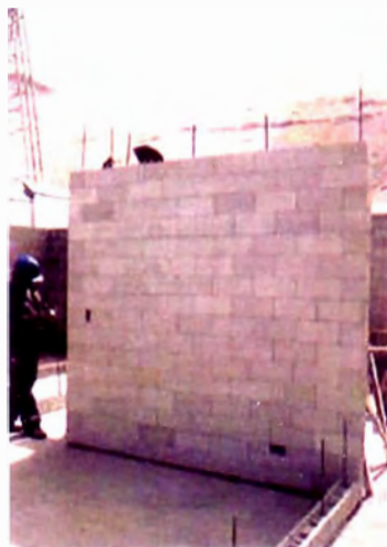
Vista exterior del muro terminado
