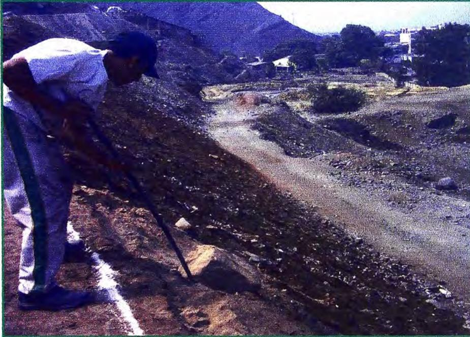
Foto N° 04 Realizando el perfilado y limpieza del talud. (retirando prietas)
