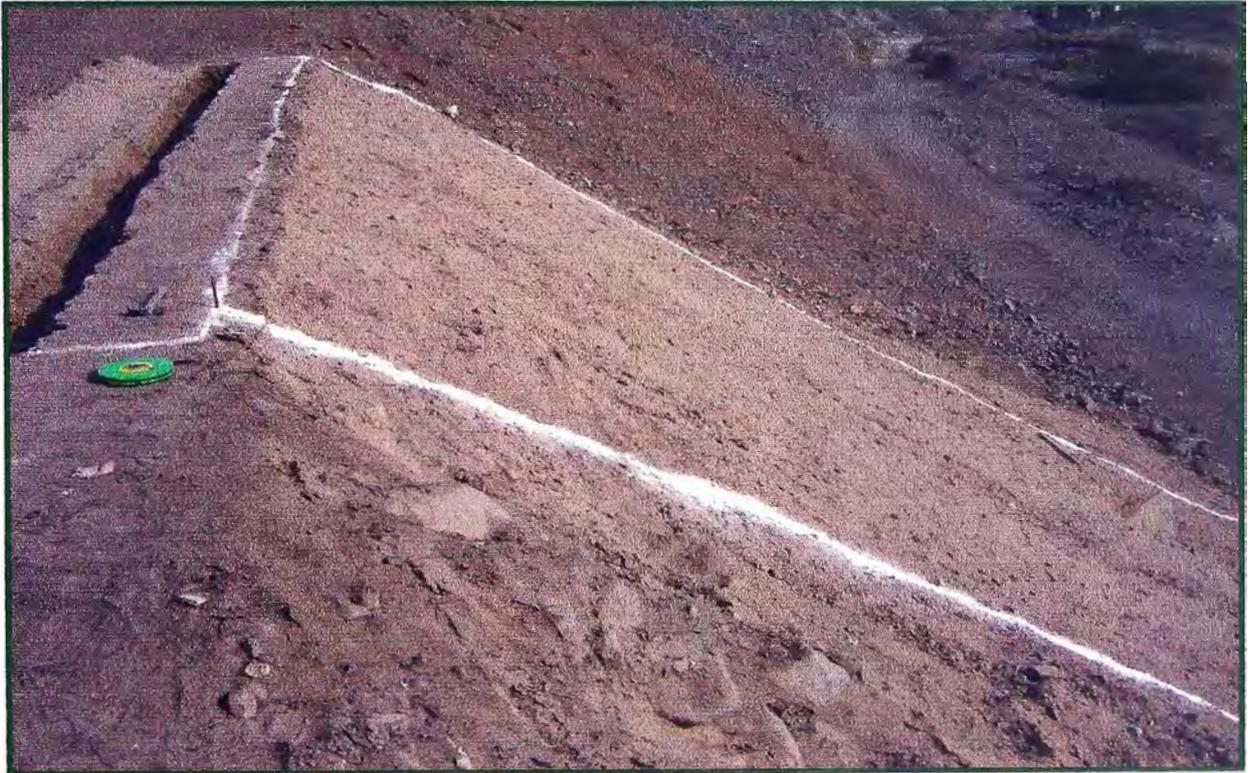
**Fotografía N° 06:** Colocando los mantos, la tierra de chacra y las semillas.
