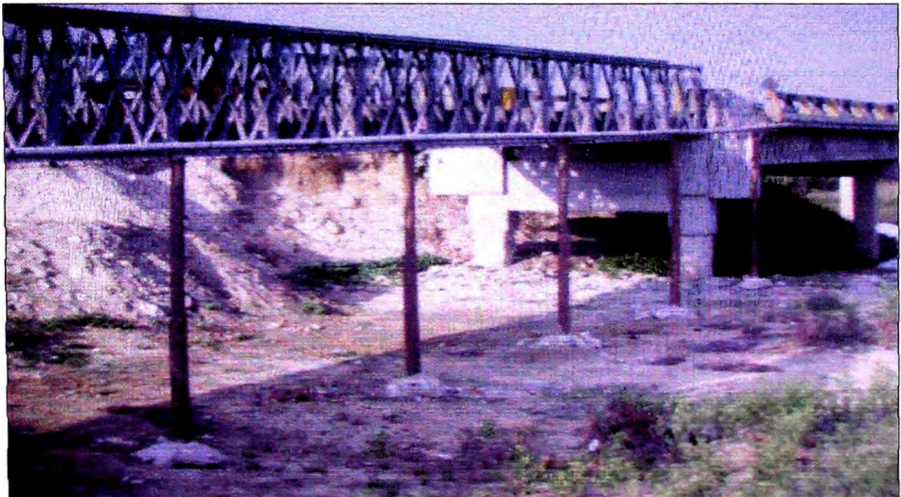
FOTO N°04: Vista del tramo metálico a ser reemplazado del Puente Independencia.
