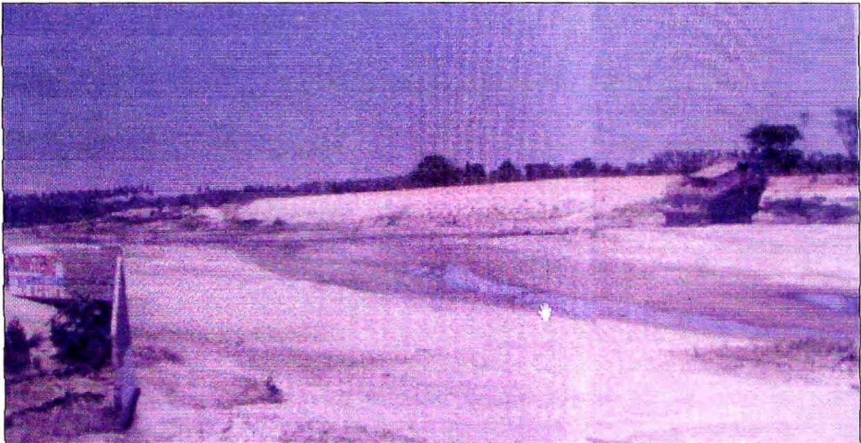
FOTO N°01: Vista del antiguo Puente Independencia, que fallo en El Niño de 83.
