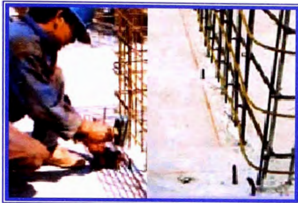
Foto N°01 - Colocación del acero en los cimientos. Fuente: revista el Constructivo
