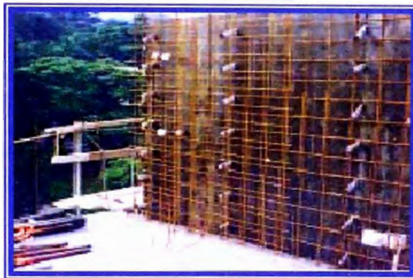
Foto N°02 - Instalación de los encofrados Fuente: revista el Constructivo
