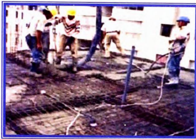
Foto N° 05 - Vaciado del Concreto Fuente: revista el Constructivo
