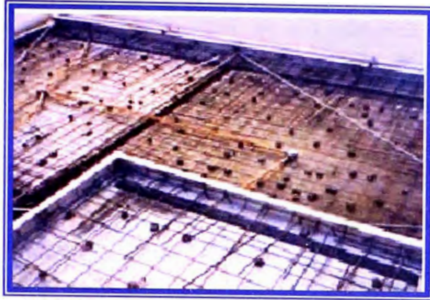
Foto N° 04 - Montaje del Refuerzo de losa Fuente: revista el Constructivo
