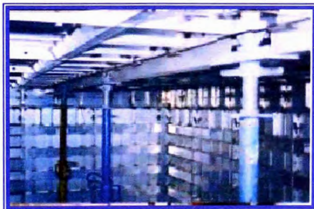
Foto N°03 - Montaje de las formaletas en interiores Fuente: revista el Constructivo
